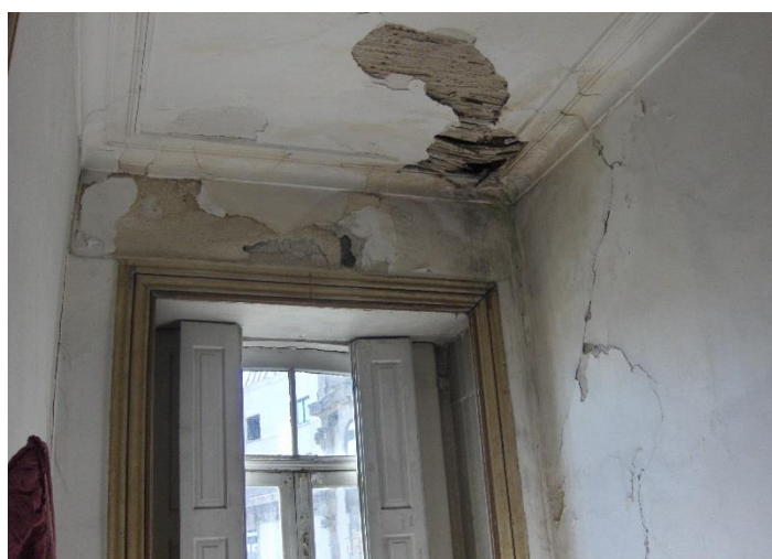
Figura 44 - Tetos degradados (Fonte: Irmãos Maia, C. C. O. P., Lda., 2008)
