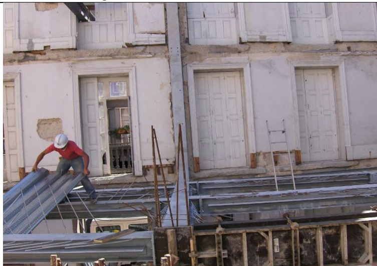
Figura 59 - Fixação da chapa colaborante (Fonte: Irmãos Maia, C. C. O. P., Lda., 2008)
