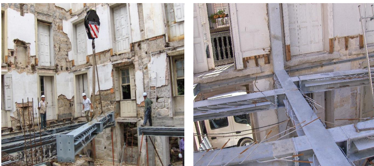
Figura 56 - Colocação de vigas metálicas do rés-do-chão (Fonte: Irmãos Maia, C. C. O. P., Lda., 2008)
