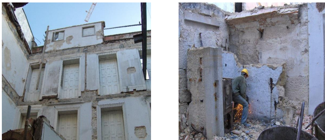
Figura 48 - Demolição do interior (Fonte: Irmãos Maia, C. C. O. P., Lda., 2008)
