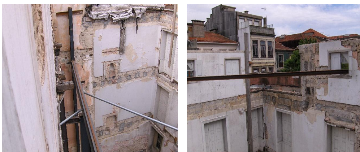
Figura 49 - Estrutura provisória (Fonte: Irmãos Maia, C. C. O. P., Lda., 2008)
