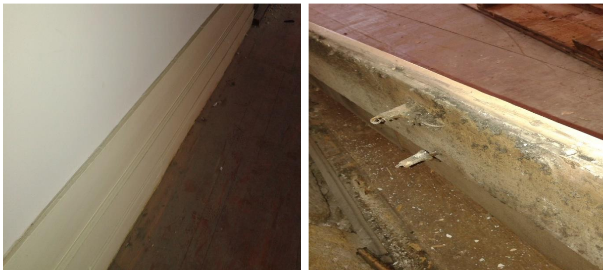
Figura 70 - Rodapé em madeira (Fonte: AC Maias Engenharia Lda., 2015)
