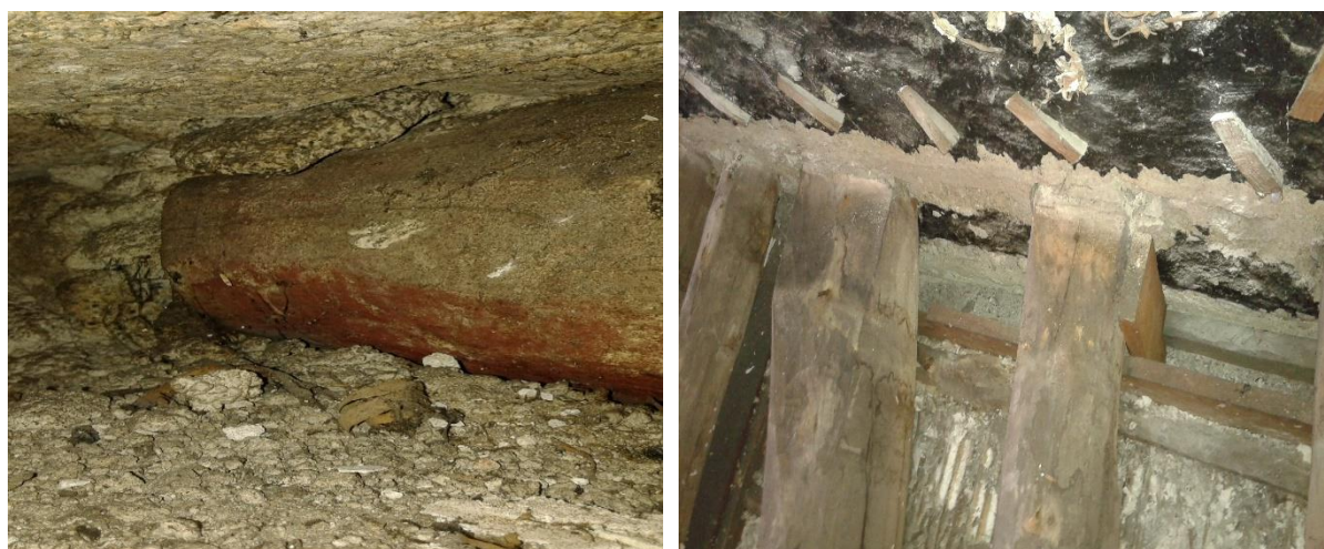
Figura 72 - Vigamento de madeira (Fonte: AC Maias Engenharia Lda., 2015)
