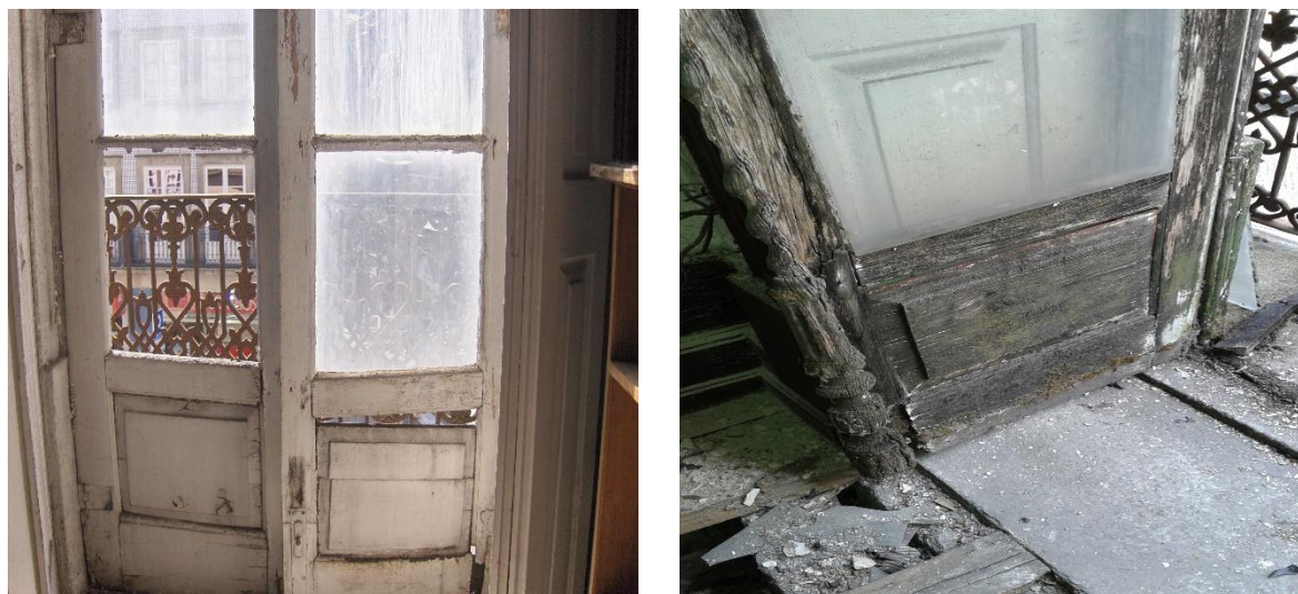
Figura 69 - Janelas e portadas em madeira (Fonte: AC Maias Engenharia Lda., 2015)
