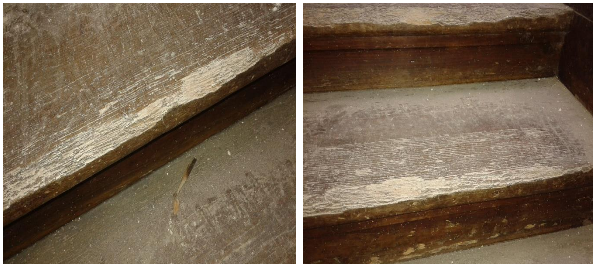
Figura 77 - Caixa de escadas (Fonte: AC Maias Engenharia Lda., 2015)
