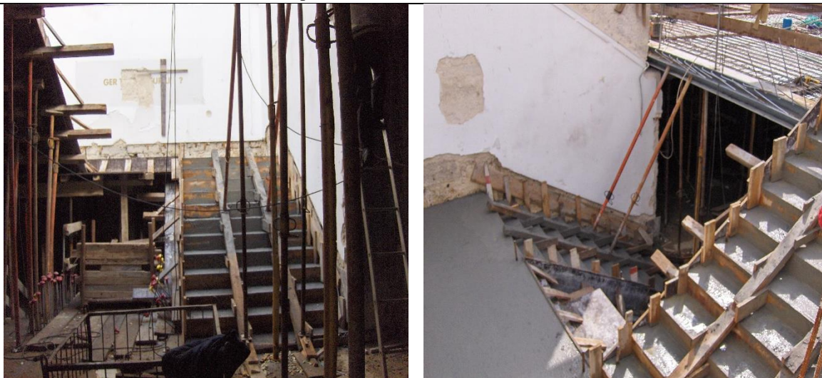
Figura 62 - Escadas em betão armado (Fonte: Irmãos Maia, C. C. O. P., Lda., 2008)
