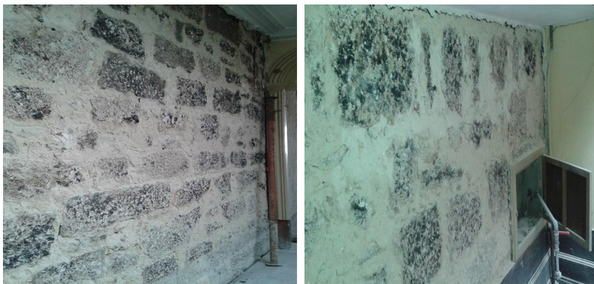
Figura 80 - Paredes em granito da caixa de escadas (Fonte: AC Maias Engenharia Lda., 2015)
