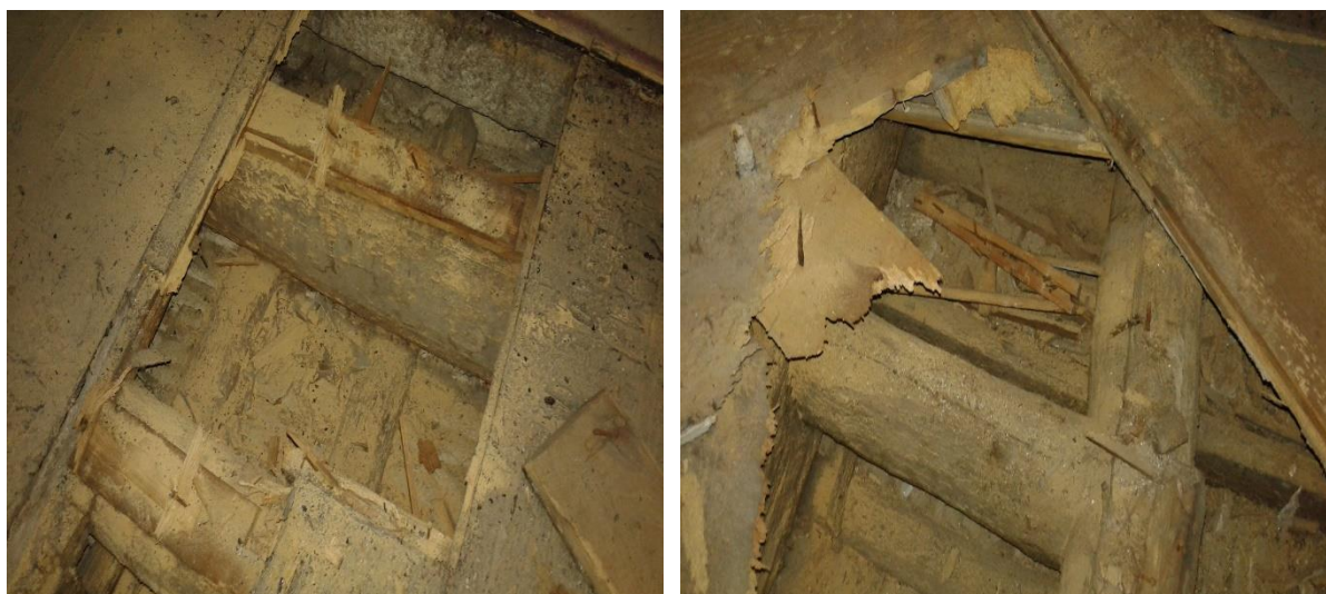
Figura 74 - Soalho em riga velha (Fonte: AC Maias Engenharia Lda., 2015)
