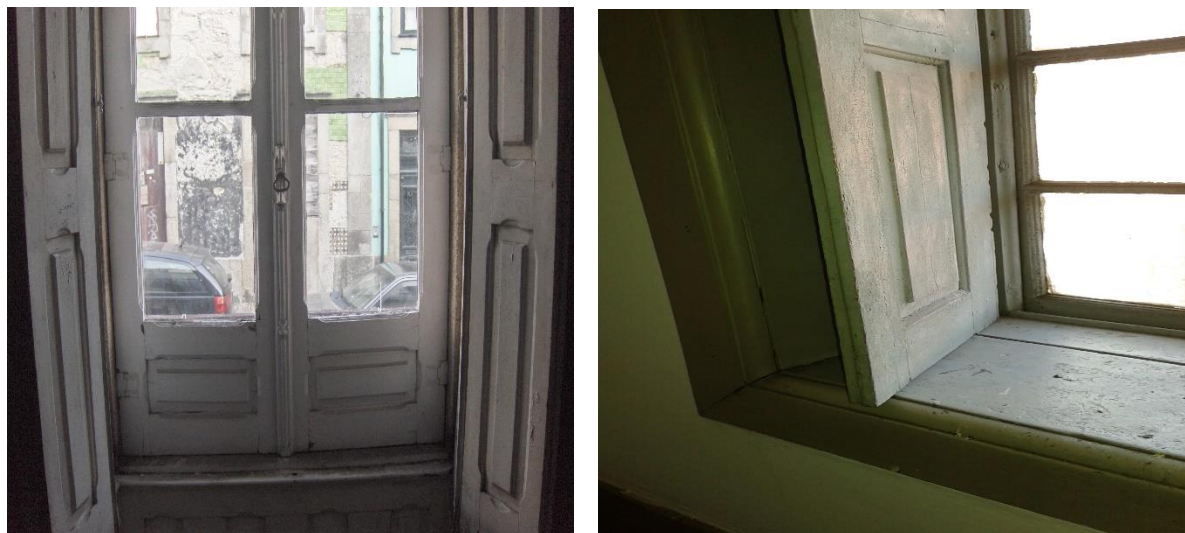
Figura 19 - Vidro das janelas exteriores (Fonte: AC Maias, Engenharia Lda.)
