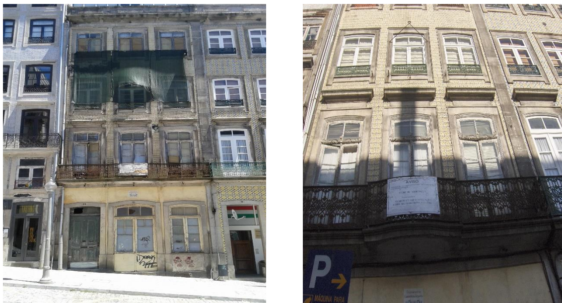
Figura 66 - Fachada do edifício nº82 da rua de Ferreira Borges (Fonte: AC Maias, Engenharia Lda., 2015)
