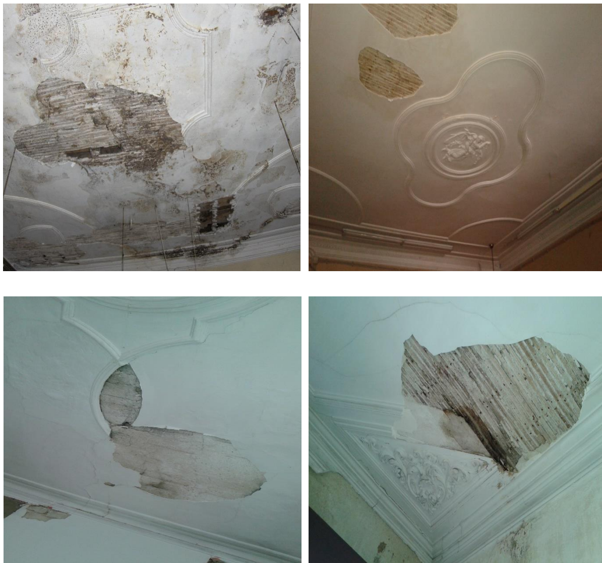
Figura 76 - Tetos em gesso (Fonte: AC Maias Engenharia Lda., 2015)
