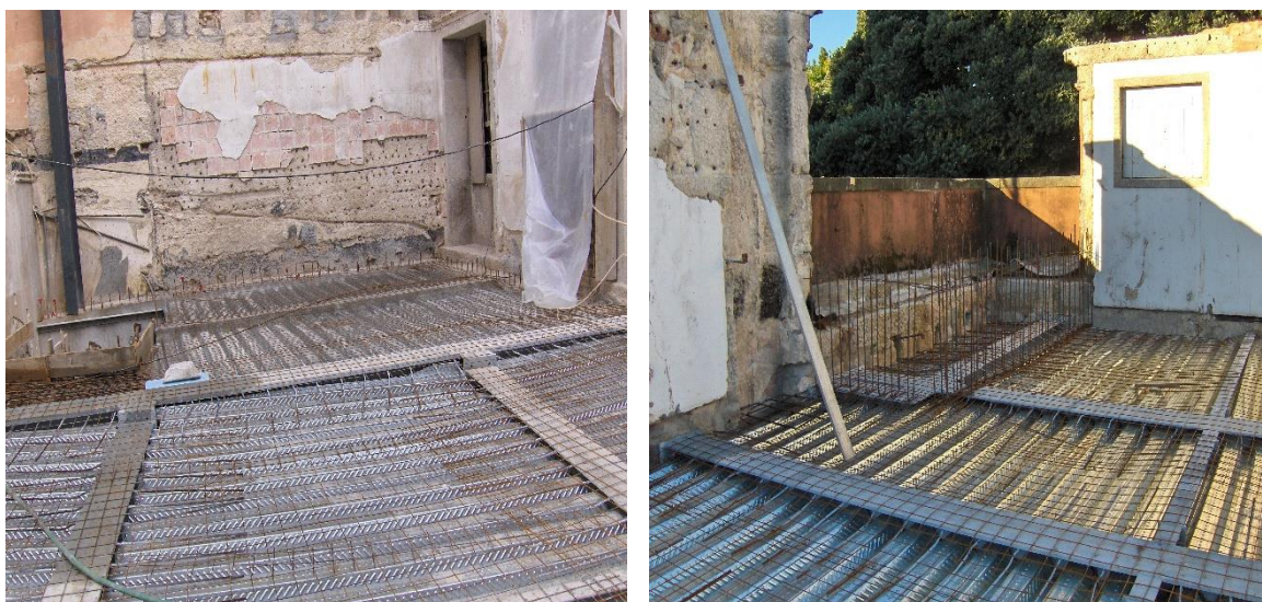
Figura 37 - Laje colaborante (Fonte: Irmãos Maia, C.C.O.P, Lda.)
