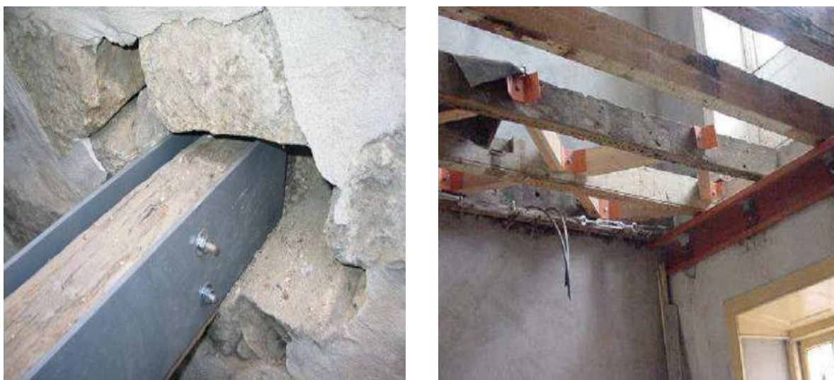
Figura 38 - Técnicas de reforço em madeira (Fonte: Arriaga, 2002)
