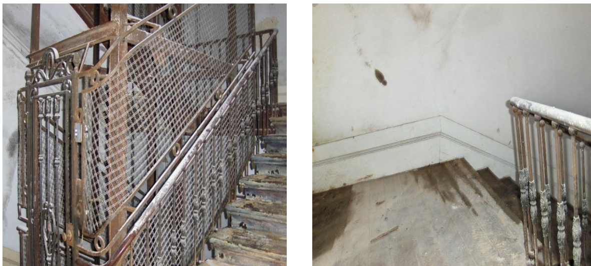
Figura 47 - Elevador e caixa de escadas (Fonte: Irmãos Maia, C. C. O. P., Lda., 2008)
