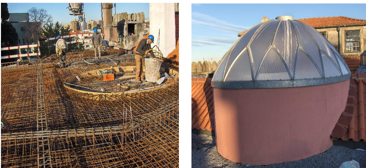
Figura 63 - Cobertura e claraboia translúcida em policarbonato (Fonte: Irmãos Maia, C. C. O. P., Lda., 2008)
