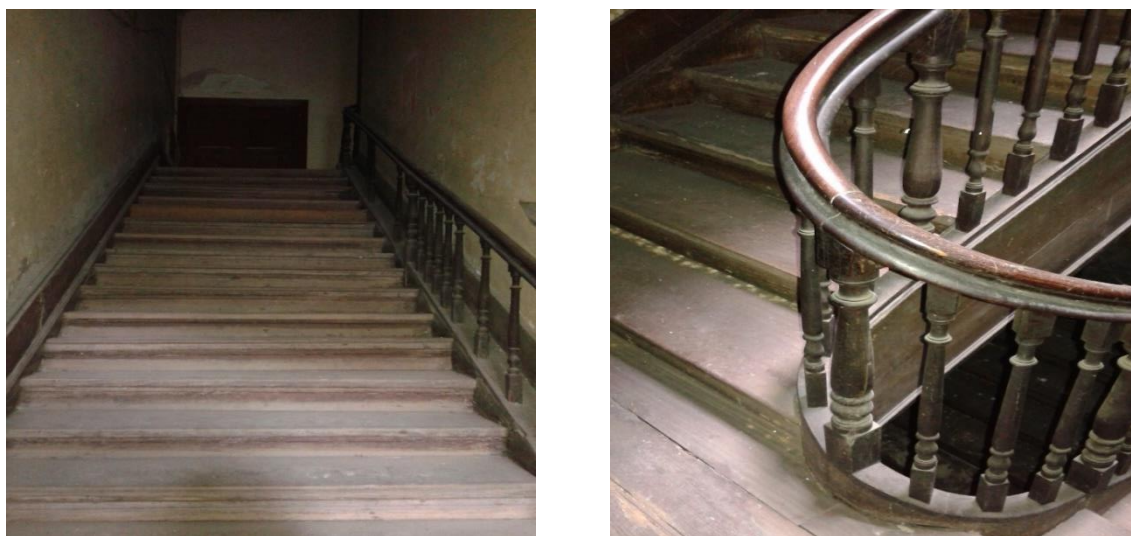
Figura 78 - Balaústre de madeira (Fonte: AC Maias Engenharia Lda., 2015)
