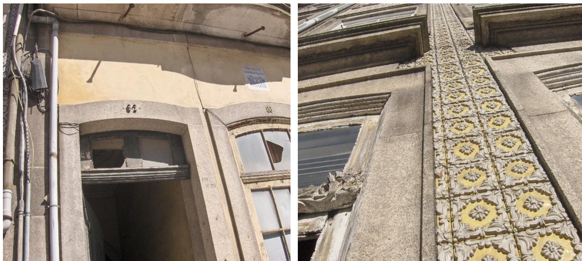
Figura 71 - Elementos de granito em fachada (Fonte: AC Maias Engenharia Lda., 2015)
