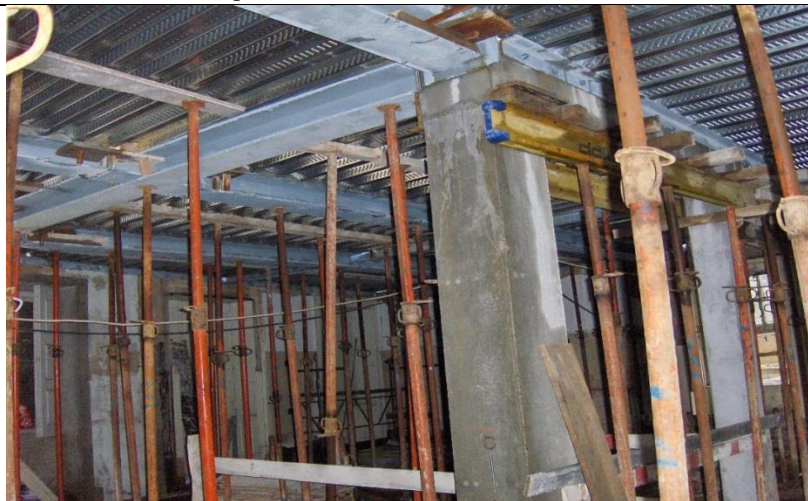
Figura 55 - Pilares em betão armado (Fonte: Irmãos Maia, C. C. O. P., Lda., 2008)
