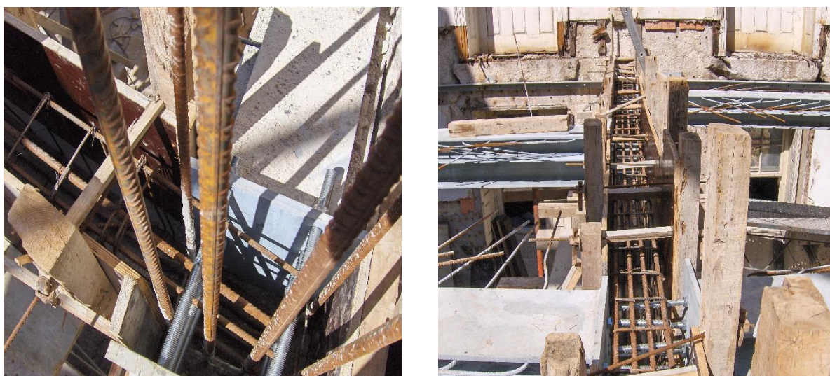
Figura 58 - Estrutura mista, vigas metálicas e em betão armado (Fonte: Irmãos Maia, C. C. O. P., Lda., 2008)
