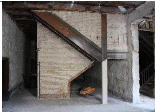
Figura 25 - Paredes interiores em madeira de tabique interior com duplo tabuado (Fonte: Pires, A., Faculdade de Engenharia da Universidade do Porto, 2013)
