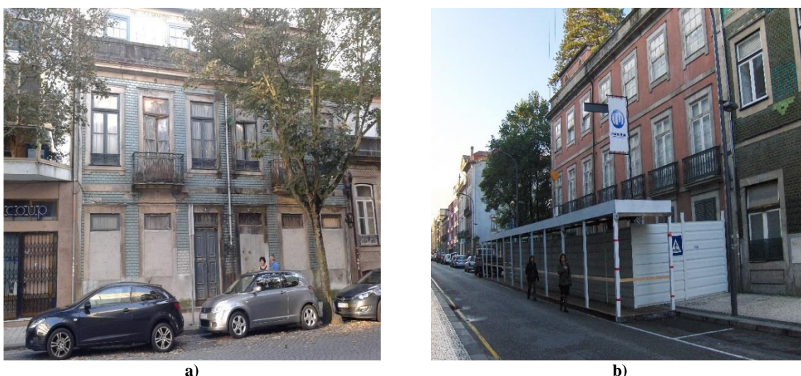
Figura 2 - Edifícios burgueses da cidade do Porto (Fonte: a) Projeto de Reabilitação de Edifícios - Universidade Fernando Pessoa, 2014; b) Irmãos Maia C. C. O. P., Lda., 2008)
