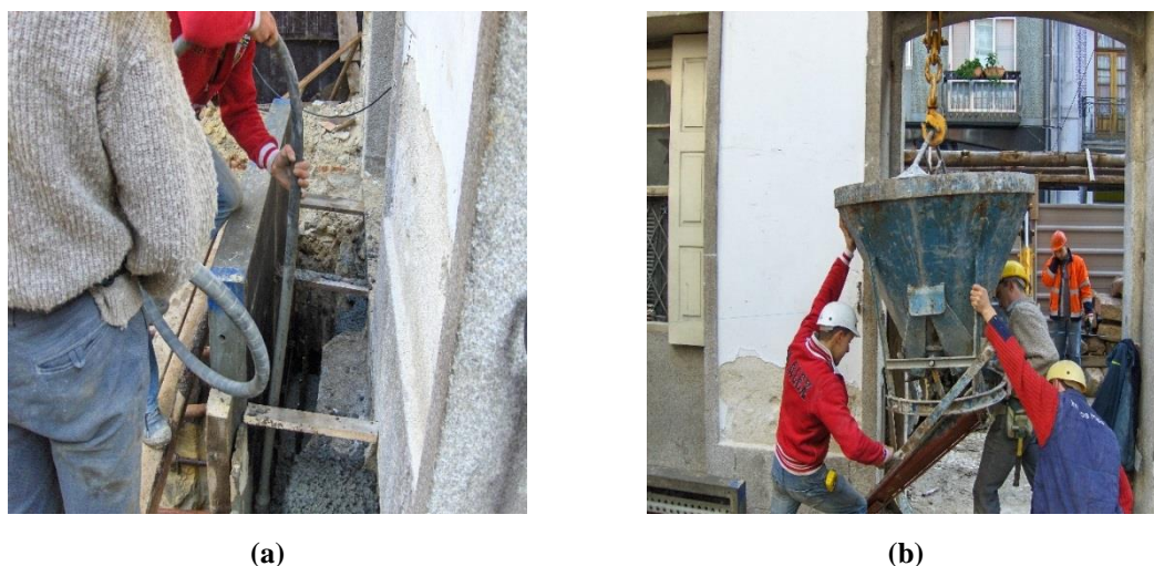
Figura 54 - Muro de contenção e respetiva betonagem (Fonte: Irmãos Maia, C. C. O. P., Lda., 2008)
