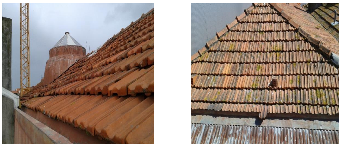
Figura 67 - Cobertura e claraboia (Fonte: AC Maias, Engenharia Lda., 2015)
