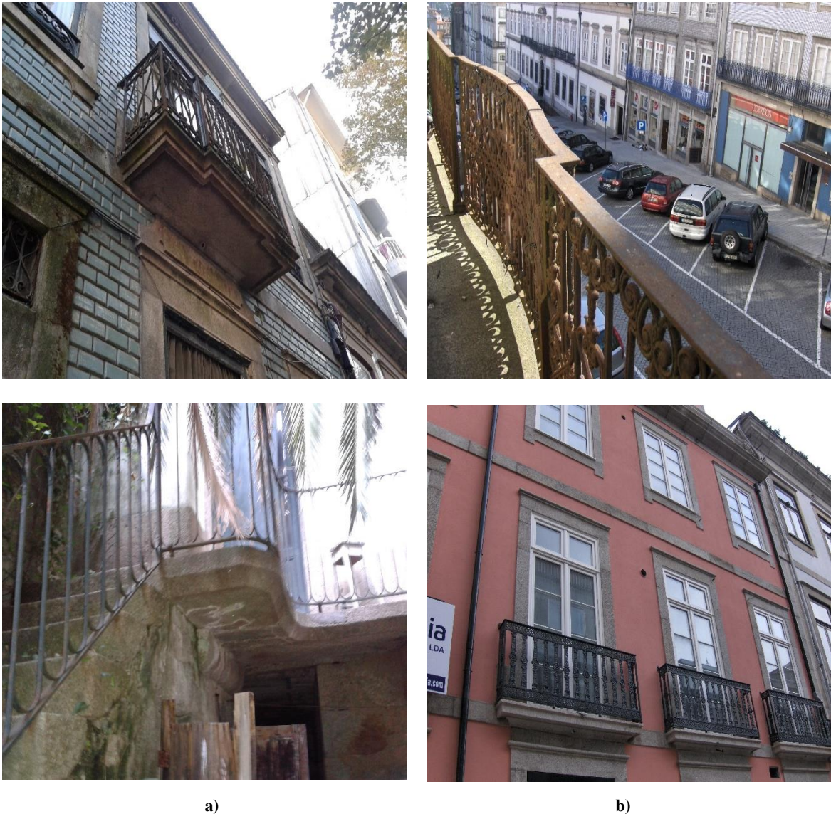
Figura 14 - Grades de varandas em ferro forjado/fundido (Fonte: a) Projeto de Reabilitação de Edifícios - Universidade Fernando Pessoa; b) AC Maias, Engenharia Lda.)
