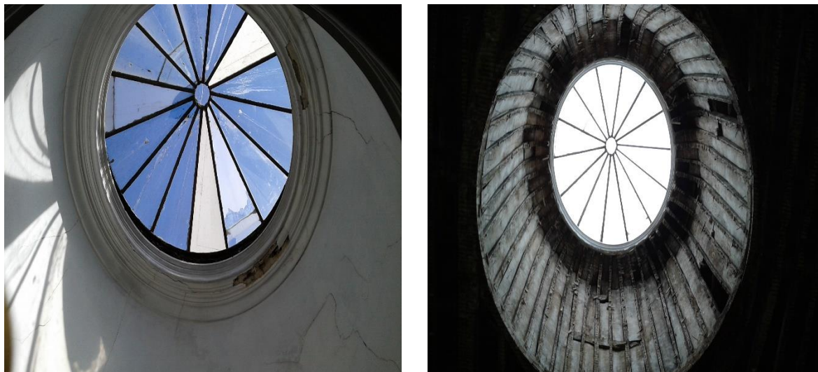
Figura 68 - Cobertura e claraboia (Fonte: AC Maias, Engenharia Lda., 2015)
