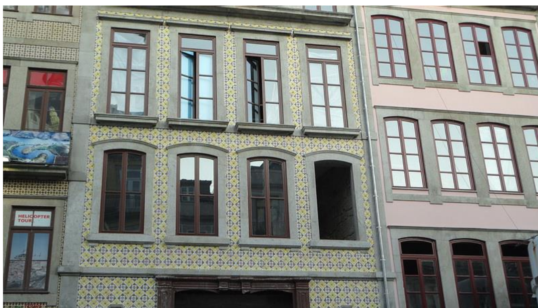
Figura 1 - Fachada de edifício reabilitado na cidade do Porto (Fonte: SRU – Porto Vivo, 2014)
