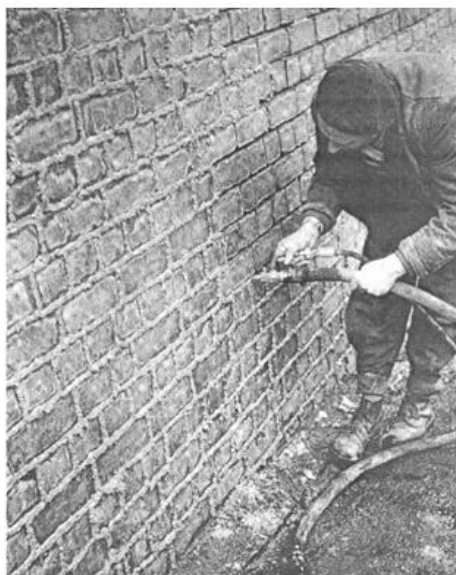
Figura 36 - Lavagem das juntas e colocação da nova argamassa de substituição (Fonte: Tomazevic, 1999)
