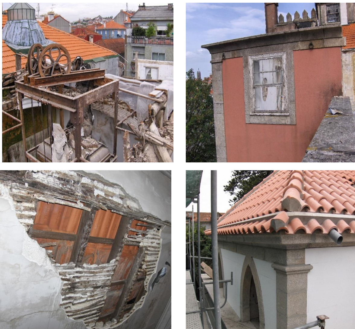
Figura 17 - Telha tradicional e elementos de granito em vãos exteriores (Fonte: Irmãos Maia, C.C.O.P., Lda.)
