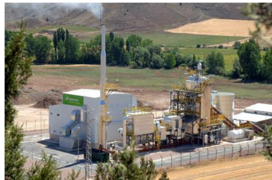
Figura 17 - Central Elétrica de Biomassa de resíduos florestais em Corduente, Guadalajara, Espanha (2)
