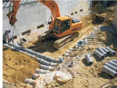
Figura 56 – Colocação dos 32 tubos para o sistema de arrefecimento de ar pelo solo (Fonte: Gonçalves, 2005, p.6)
