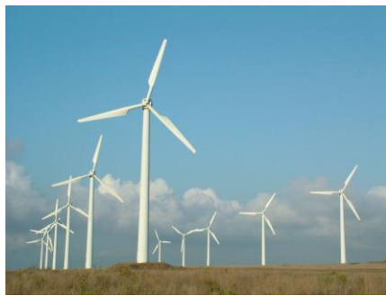
Figura 6 - Parque Eólico de Sines (Portugal) (Fonte: Câmara Municipal de Sines, 2007)
