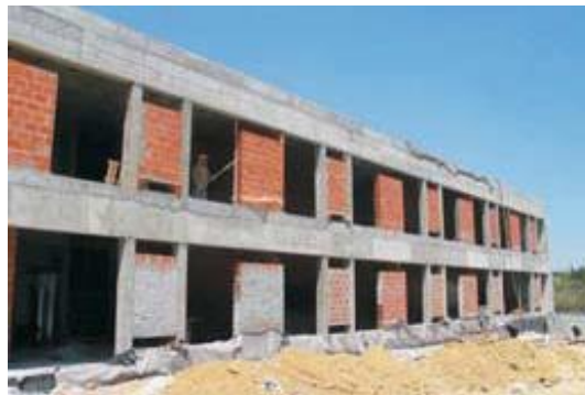
Figura 49 – Paredes exteriores da fachada sul do Edifício Solar XXI ainda em construção (Fonte: Gonçalves 2005, p.4)
