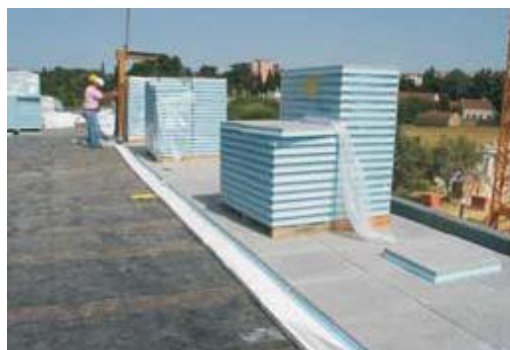
Figura 50 - Aplicação do isolamento exterior na cobertura do Edifício Solar XXI (Fonte: Gonçalves, 2005, p.5)
