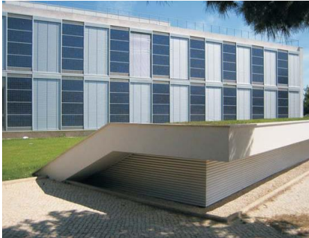
Figura 55 - Entrada de ar do sistema de arrefecimento do ar pelo solo (Fonte: Gonçalves, 2005, p.7)
