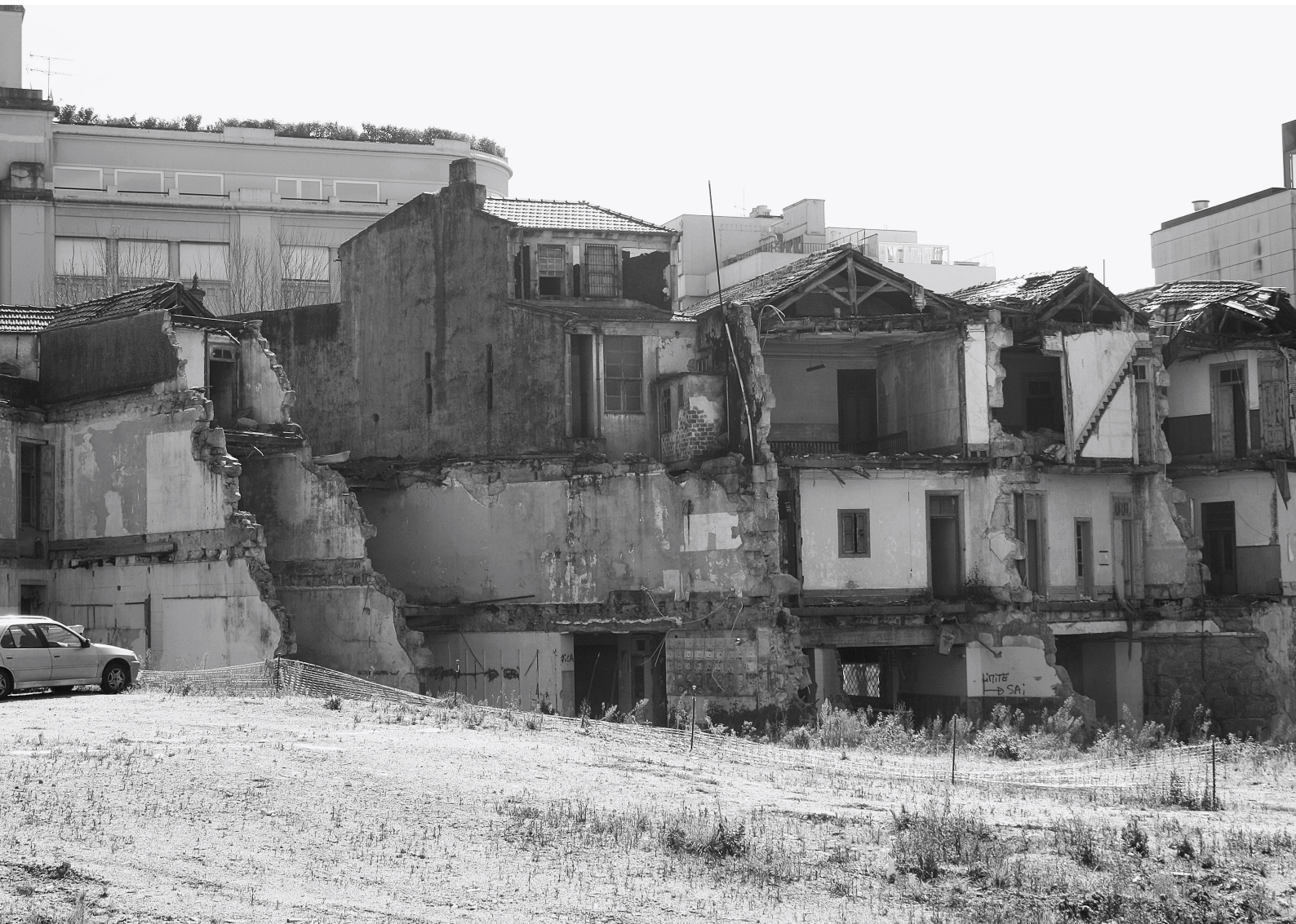
Figura 24. Demolição no Quarteirão D. João I
