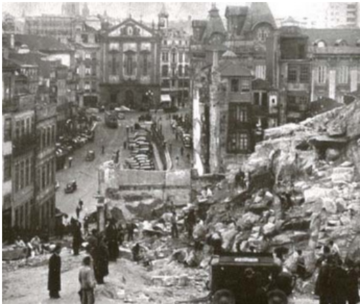
Figura 8. Demolições para abertura da “Avenida da Ponte”
