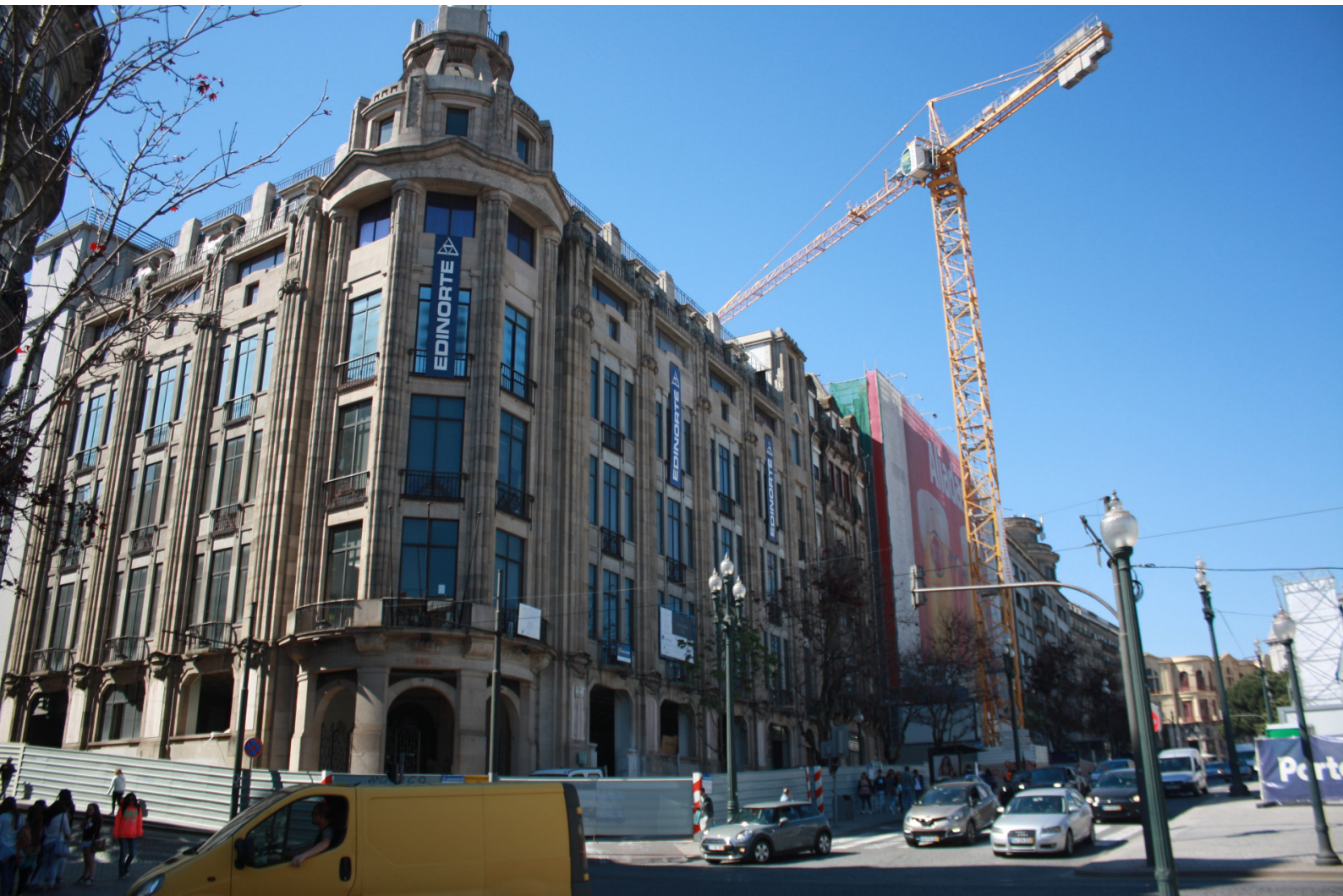
Figura 34. “Reabilitação” na Avenida dos Aliados
