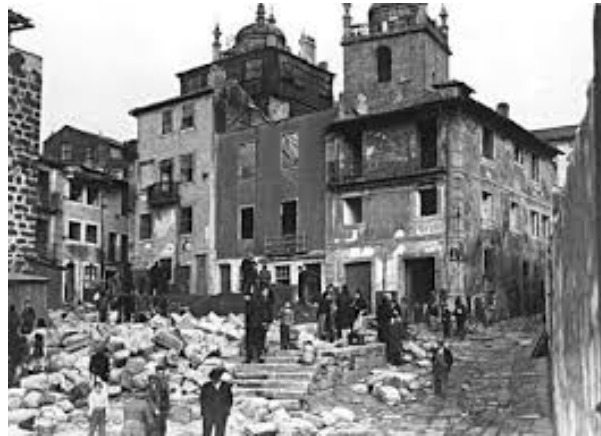
Figura 9. Demolições no Terreiro da Sé
