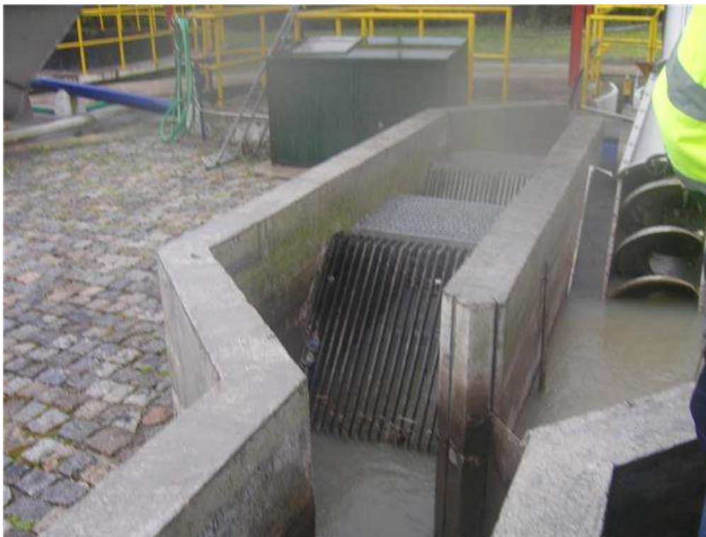
Figura 3- Processo de gradagem e tamisagem (ETARi, 2010).
