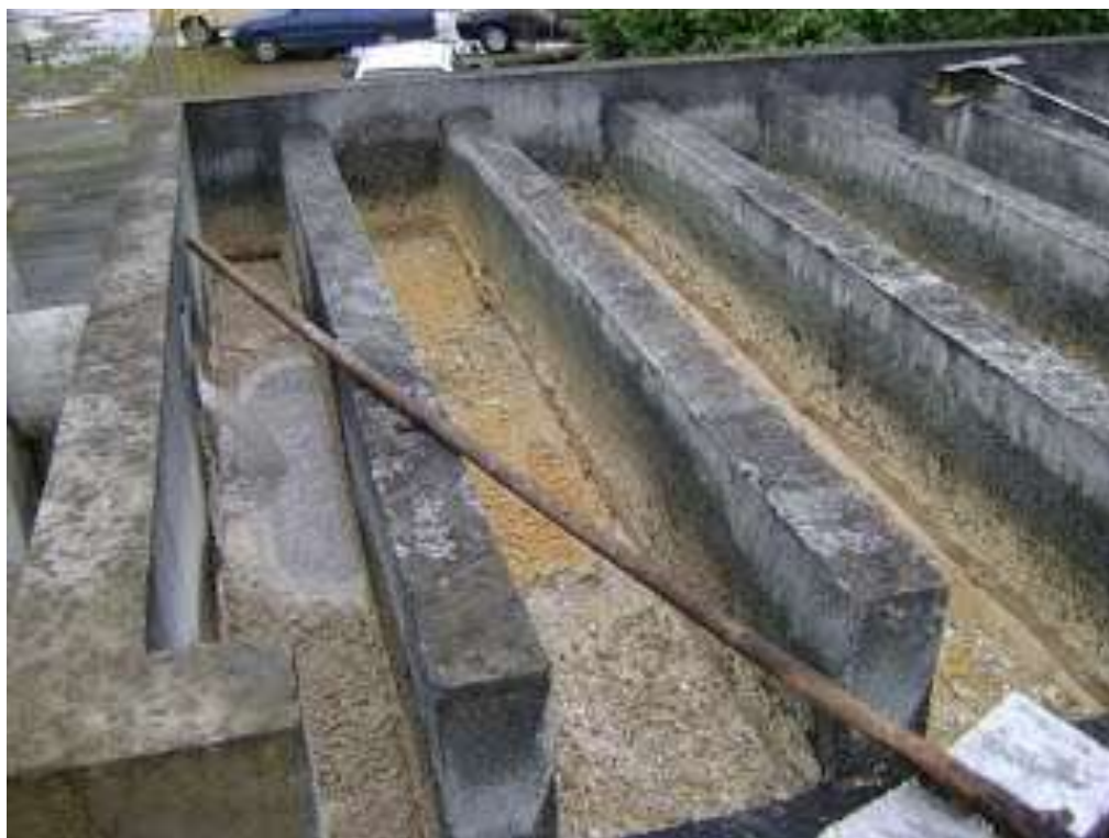
Figura 4- Fossas sépticas (ETARi, 2010).
