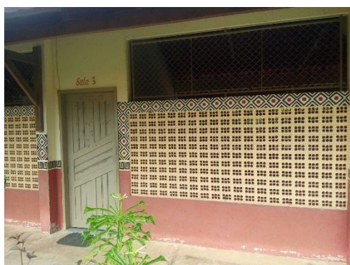
Sala de Aula – Ensino Fundamental
