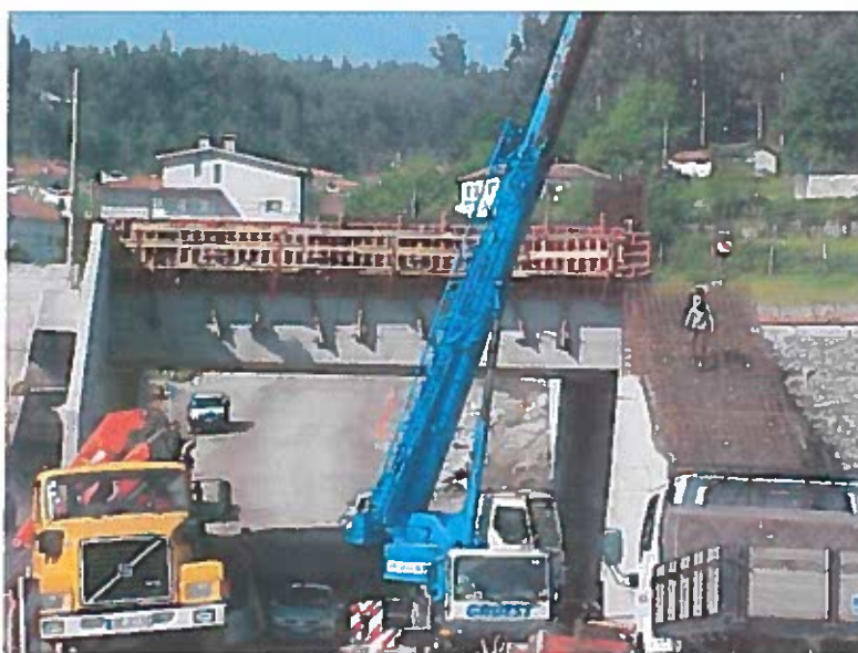
Figura 29 – Cauda que foi reaproveitada para executar uma escada [cedido pela Empreitada da Linha do Minho]
