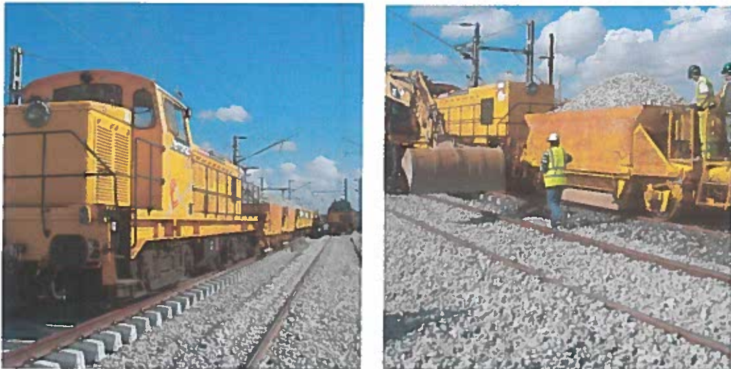
Figura 33: Rebalastragem mecânica, colocação de balastro com balastreiro [cedido pela Empreitada da Linha do Minho]
