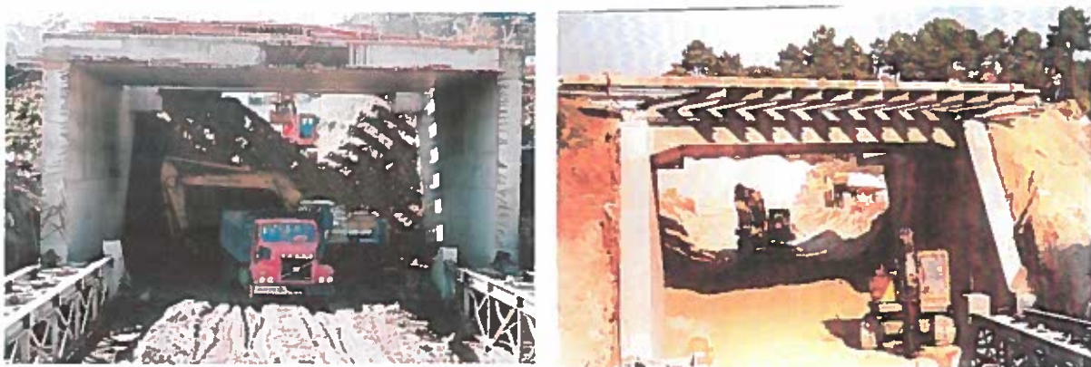
Figura 40: Conclusão da escavação e do deslize [cedido pela Empreitada da Linha do Minho]
