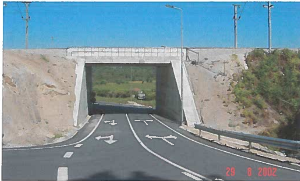
Figura 8: Passagem inferior executada pelo método tradicional [cedido pela Empreitada da Linha do Douro]
