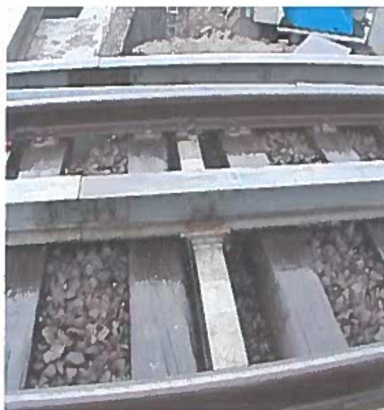
Figura 53: Pormenores das carlingas que são os perfil metálico paralelo às travessas de madeira [cedido pela Empreitada da Linha do Minho]
