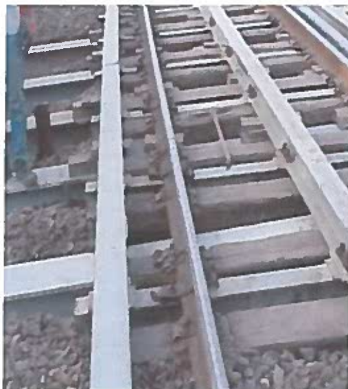
Figura 58: Pormenores das travessas [cedido pela Empreitada da Linha do Minho]
