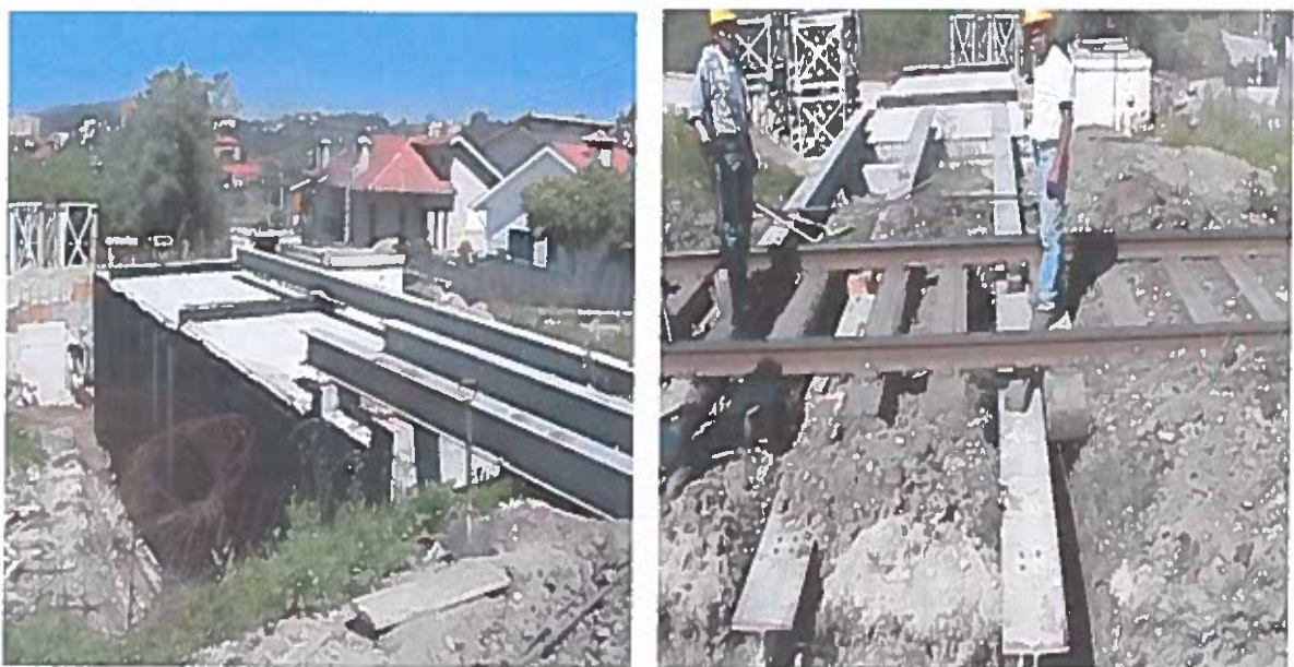
Figura 9 : Execução da suspensão de via aplicada ao método de deslize [cedido pela Empreitada da Linha do Minho]
