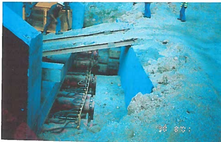
Figura 35 – Início da execução do deslize [cedido pela Empreitada da Linha do Douro]
