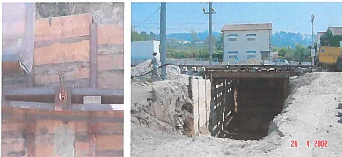
Figura 6: Entivação da plataforma de via/talude [cedido pela Empreitada da Linha do Douro]
