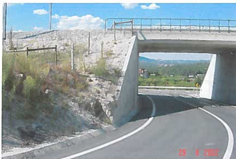
Figura 31 – Muros ala já executas [cedido pela Empreitada da Linha do Minho]
