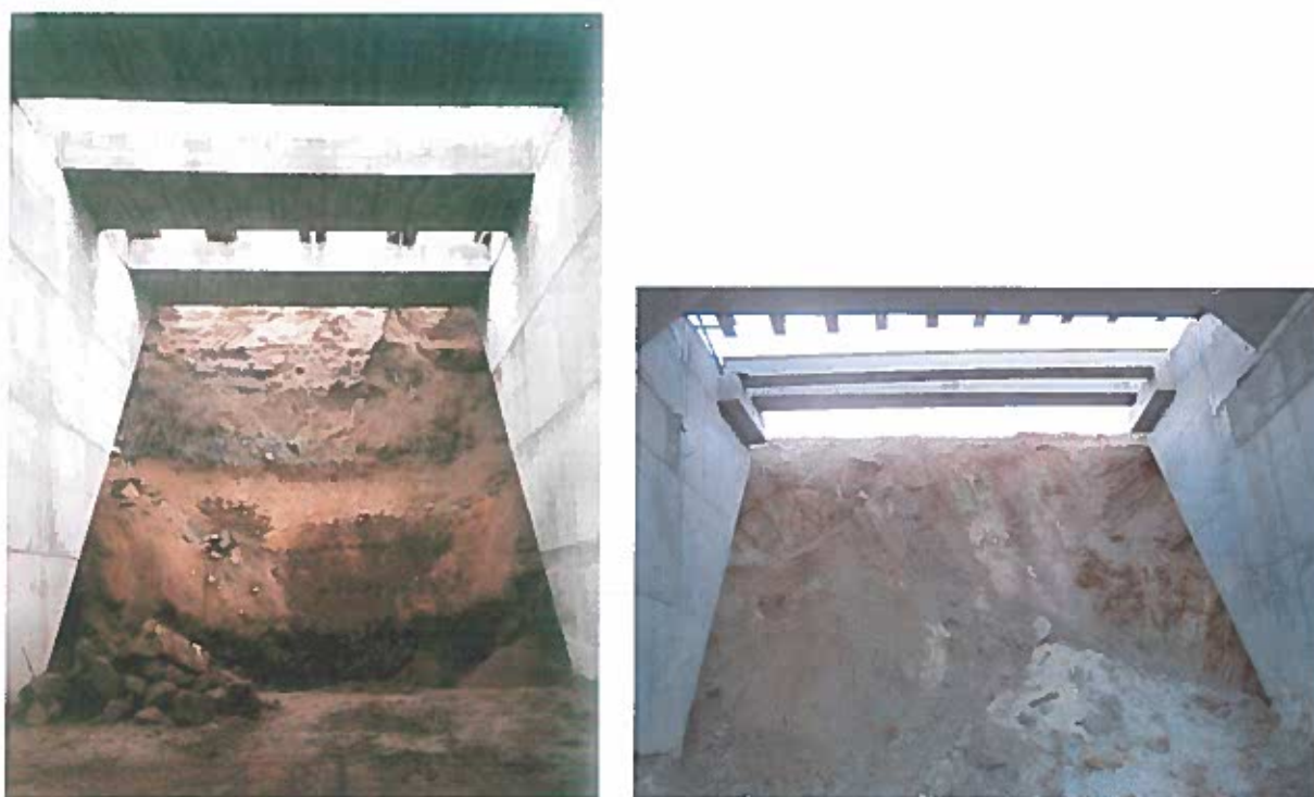
Figura 36 – Início da escavação e da execução do deslizamento [cedido pela Empreitada da Linha do Douro e Linha do Minho]
