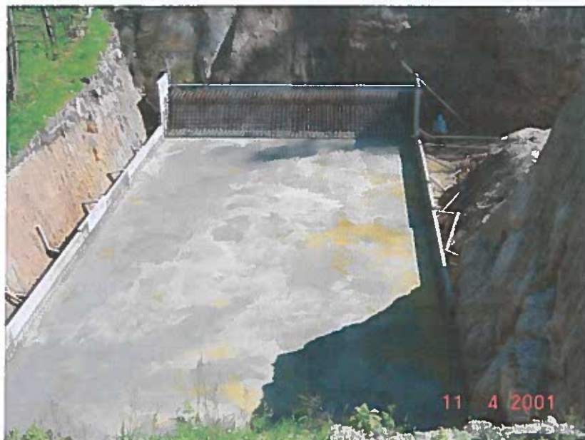
Figura 19 – Laje de regularização com o murete [cedido pela Empreitada da Linha do Douro]
