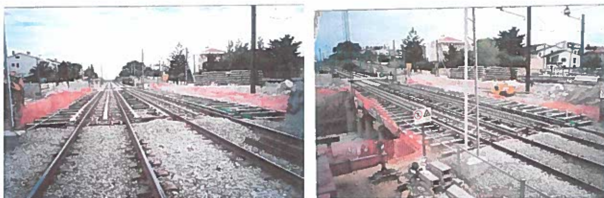
Figura 3: Suspensão de via-férrea, vista superior [cedido pela Empreitada da linha de Carcavelos]
