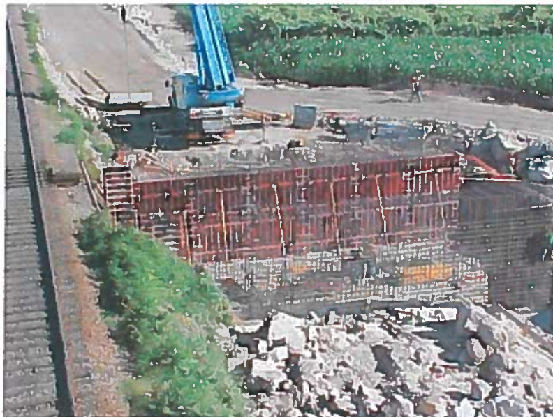
Figura 18 – Execução do quadro deslizante [cedido pela Empreitada da Linha do Minho]
