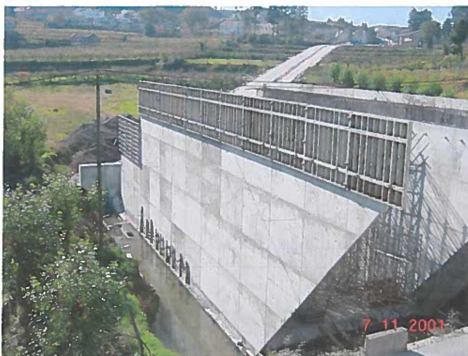
Figura 10: Execução do quadro de deslize [cedido pela Empreitada da Linha do Douro]
