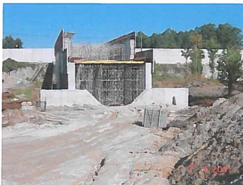
Figura 23 – Muro de reacção com o terreno natural no tardoiz [cedido pela Empreitada da Linha do Douro]
