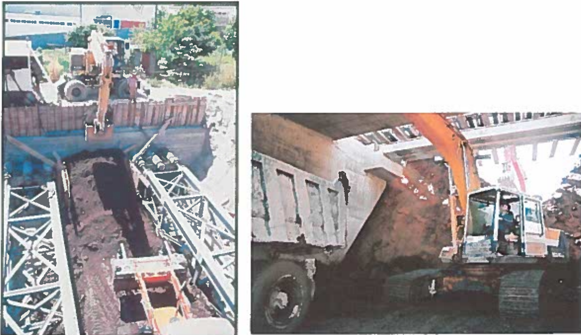
Figura 39: Pormenores da escavação com equipamento mecânico [cedido pela Empreitada da Linha do Minho]
