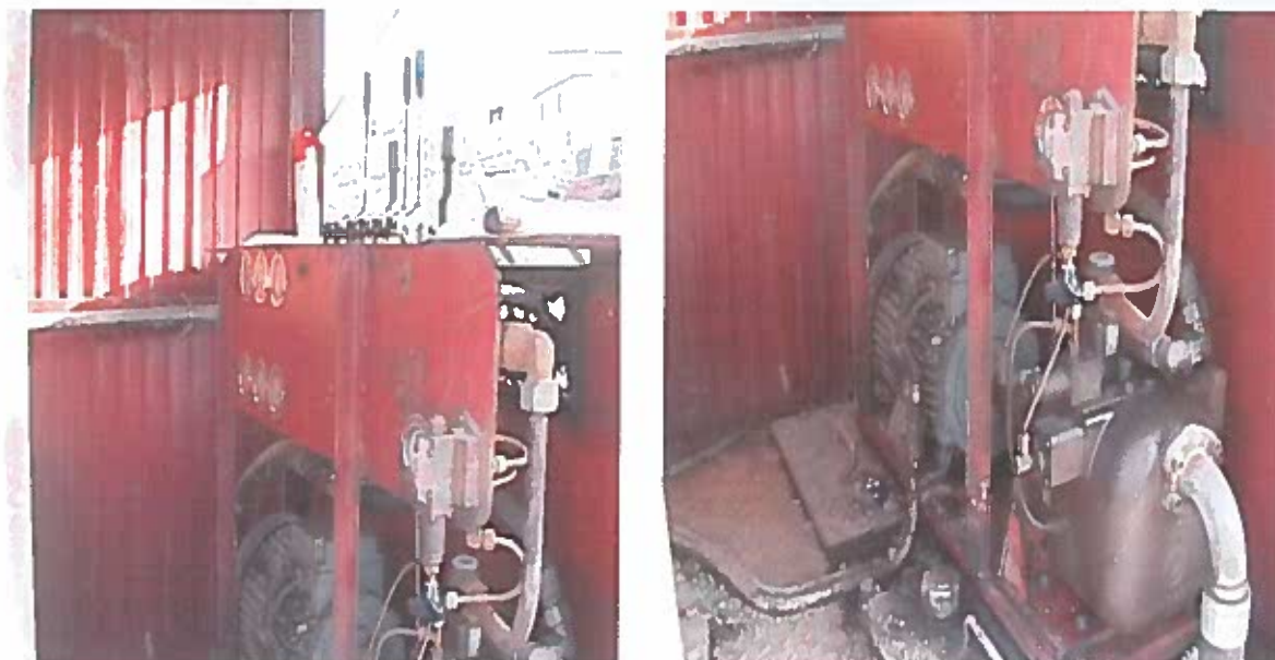
Figura 42: Casa das máquinas de manobra dos macacos [cedido pela Empreitada da Linha do Minho]
