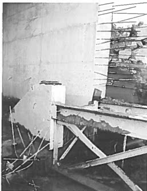
Figura 21 – Maciços de apoio [cedido pela Empreitada da Linha do Minho]
