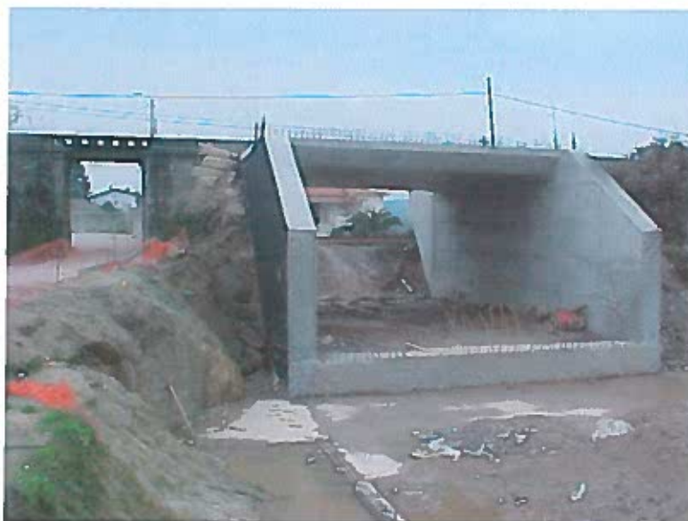
Figura 14 – Pormenor das caudas [cedido pela Empreitada da Linha do Douro]
