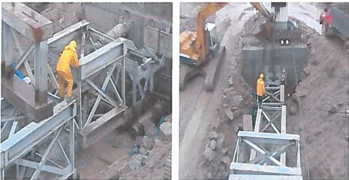
Figura 38 : Colocação das prolongas [cedido pela Empreitada da Linha do Minho]
