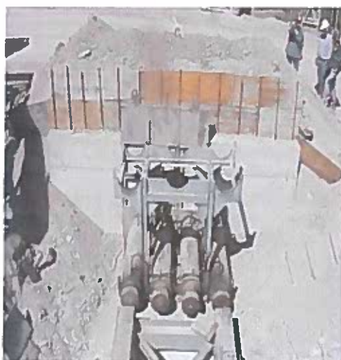
Figura 11 – Macacos hidráulicos [cedido pela Empreitada da Linha do Minho]
