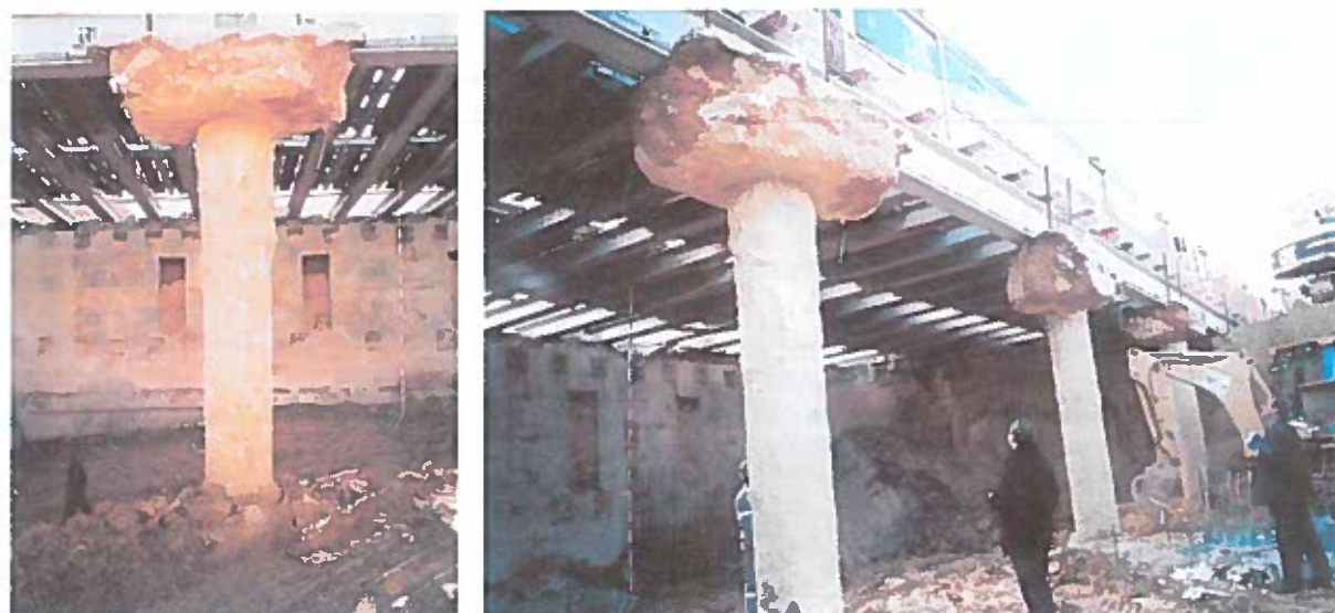
Figura 4: Suspensão de via-férrea [cedido pela Empreitada da linha de Carcavelos]
