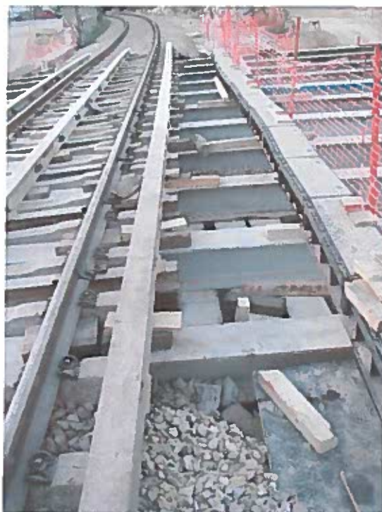
Figura 59: Pormenores da suspensão de via [cedido pela Empreitada da Linha do Minho]
