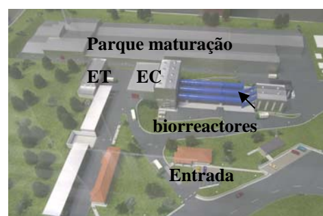
Figura VI.3. - Vista geral da ETRSU após as obras de requalificação.
