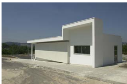
Figura VI.10. - Edifício de recepção do ecocentro.
