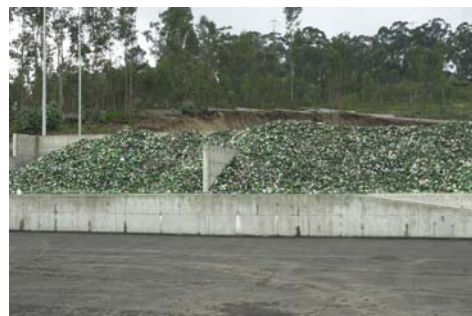
Figura VI.9. - Plataforma de armazenamento do vidro na ET para posterior remoção pela SPV.
