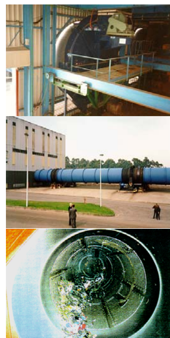
Figura VI.5. - Sequência dos RSU desde os biorreactores até à afinação.
