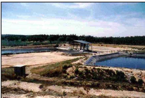
Figura V.15. Estação de Tratamento de Águas Lixiviadas adjacente ao AS da Resitejo (Resitejo, 2005).
