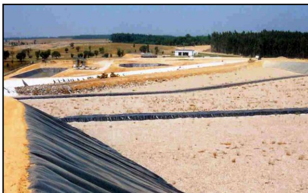
Figura V.16. Vista do AS, ainda na fase de construção (Resitejo, 1999).
