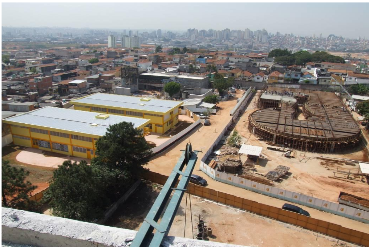
Figura 7- Construção do Centro de Convivência Educativa e Cultural de Heliópolis - Fonte: Acervo UNAS
