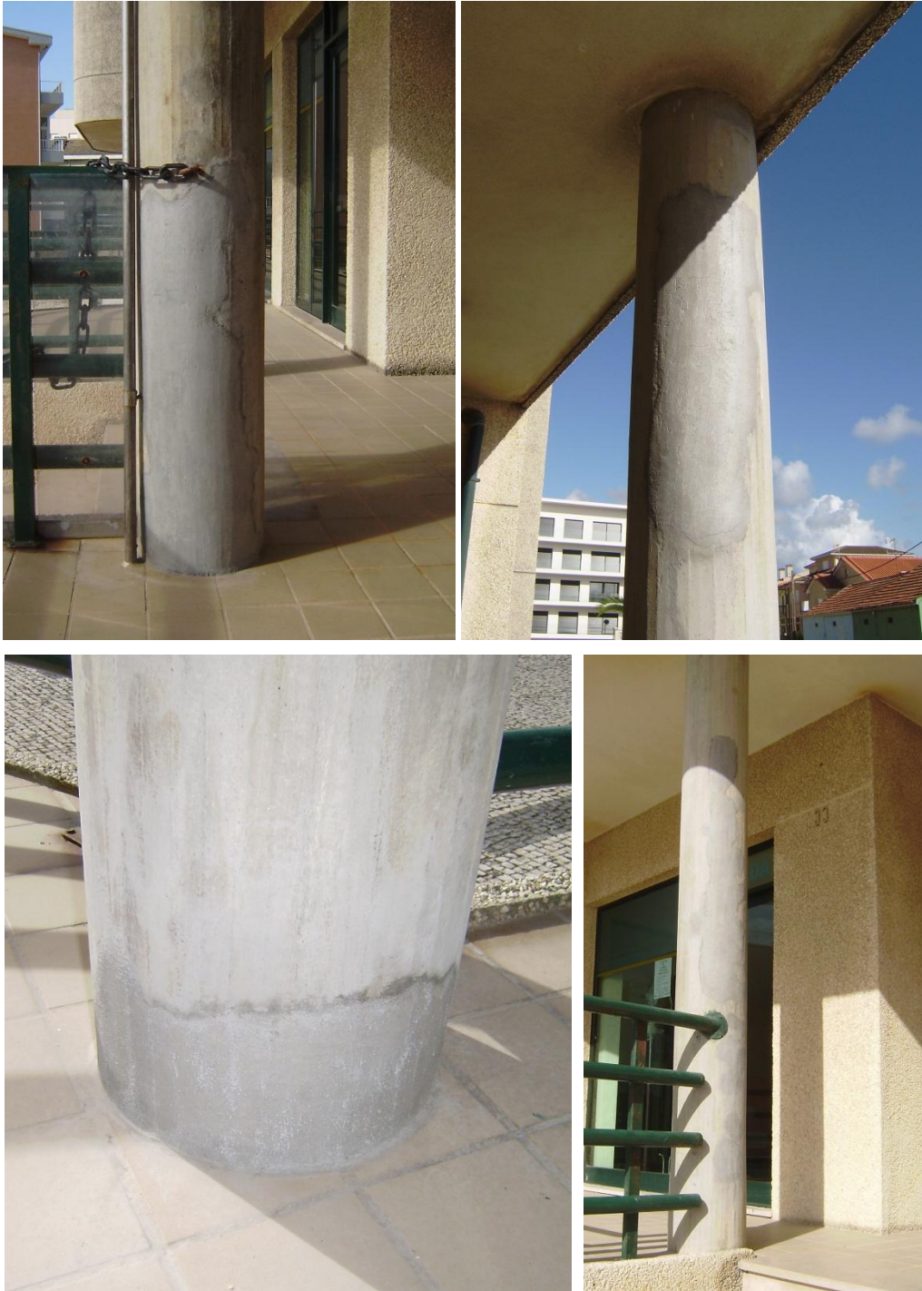
Figura 40. Processo de tratamento dos pilares: recobrimento dos pilares com argamassa selecionada
