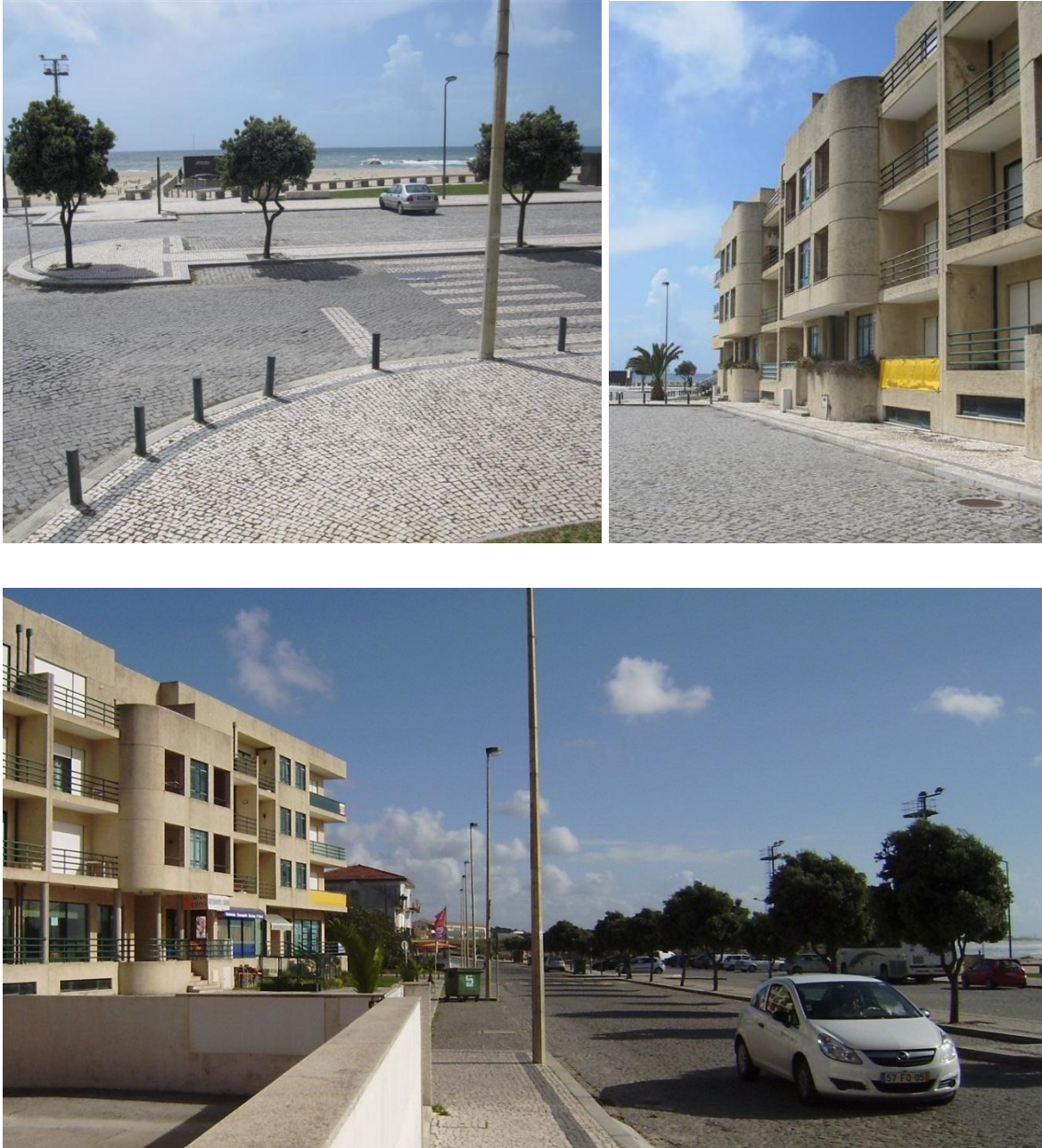
Figura 35. Fotografias do exterior e envolvente do edifício
