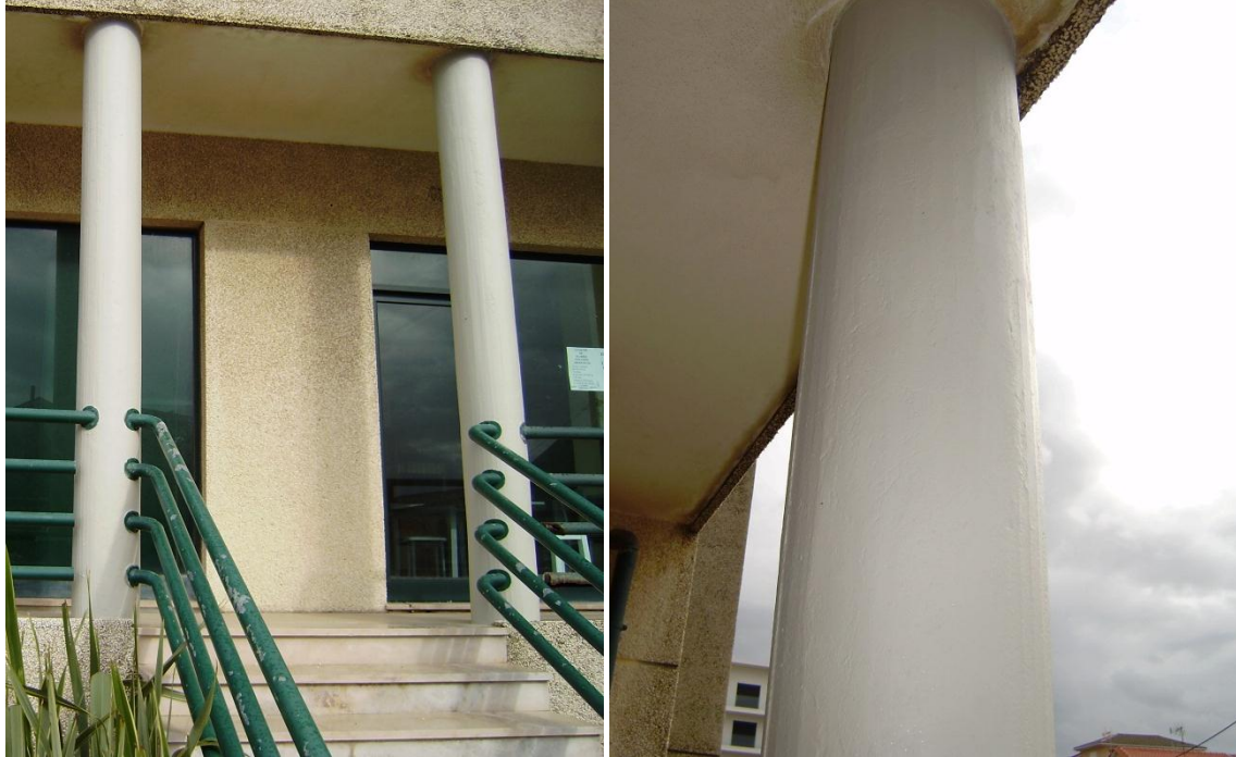
Figura 41. Aspeto final dos pilares de betão armado tratados
