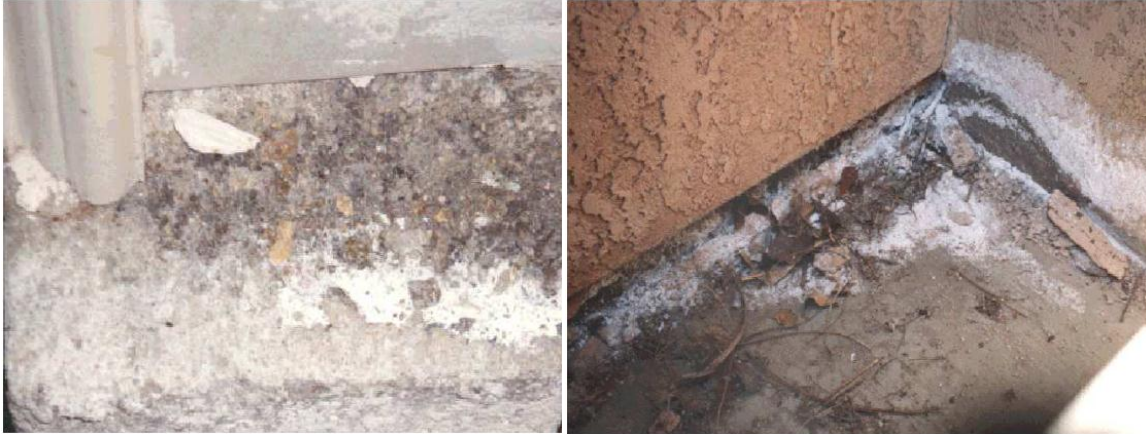
Figura 6. Exemplos de ataque de sulfatos de origem externa (Costa, 2011)
