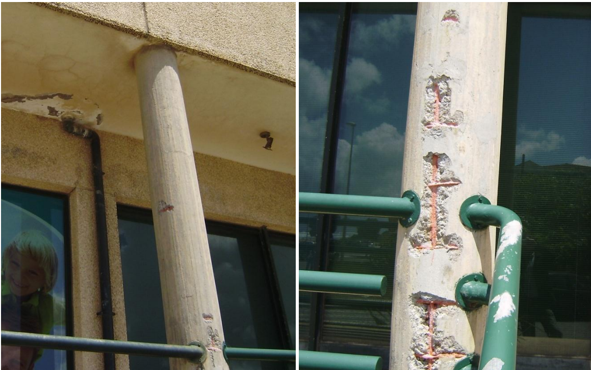
Figura 39. Processo de tratamento dos pilares: limpeza e proteção das armaduras
