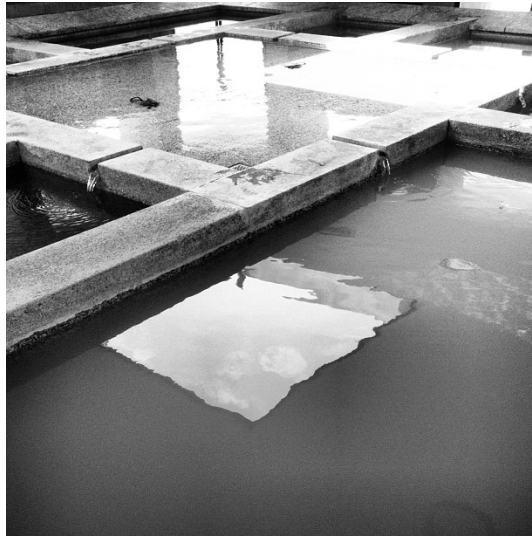
Figura 115 - Pilas y reflejo de la abertura de la cubierta en el agua
