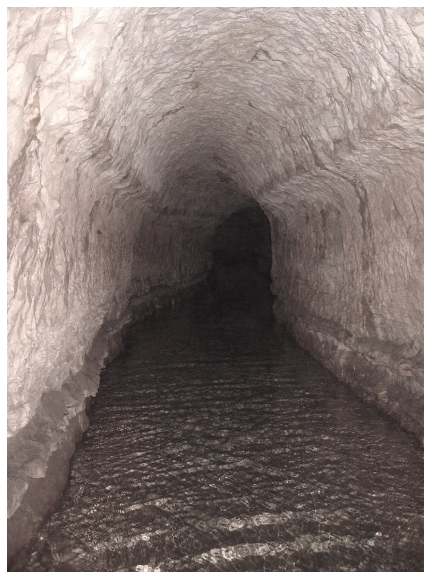
Figura 1 - Galería subterránea de Qanat
