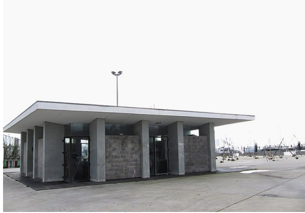
Figura 122 - Sencillez formal y de materiales en la construcción del lavadero público de Afurada
