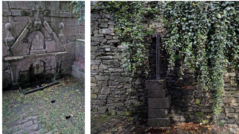
Figura 102 - Fuente preexistente encuadrada en una cota inferior
