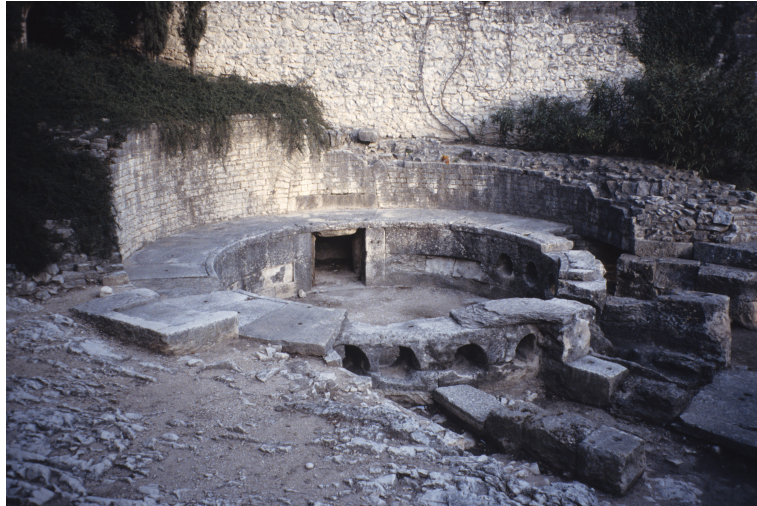
Figura 45 - Depósito divisor al final del acueducto de Nîmes
