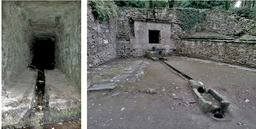
Figura 97 - Canalización de donde surge el agua de Bonaval
