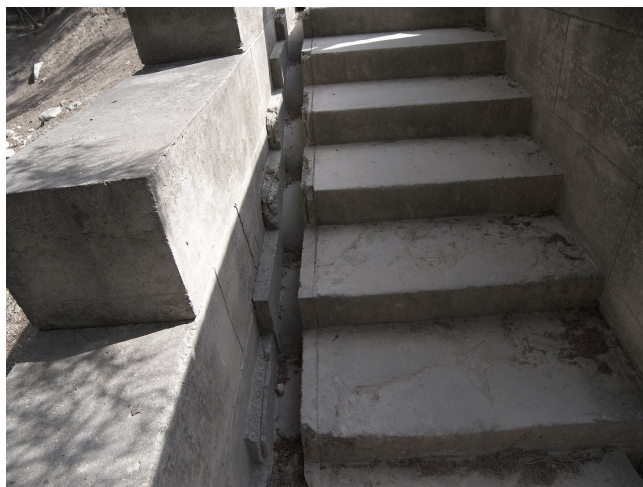
Figura 124 - Canal de agua de lluvia abierto a lo largo de una escalera del palacio minoico de Knossos Fuente: https://ancientwatertechnologies.com/2012/12/26/minoan-water-system-at-tylissos-crete/
