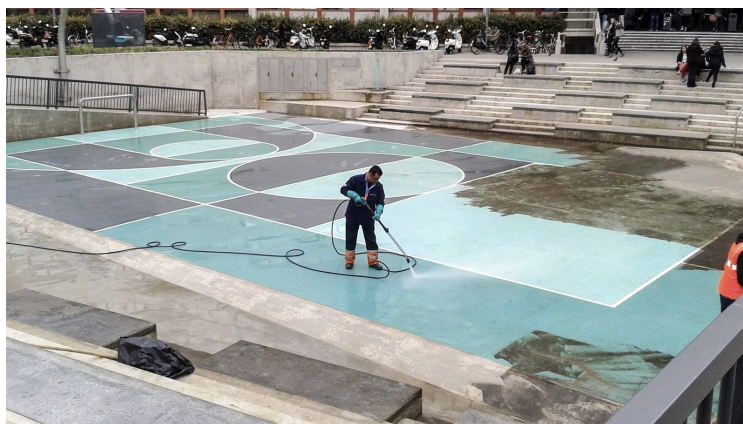
Figura 134 - Una vez que el agua se ha drenado, la piscina se limpia con la propia agua almacenada y se transforma de nuevo en un campo de juego, Rotterdam
