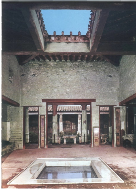
Figura 46 - “Compluvium” e “impluvium” en un atrium romano
