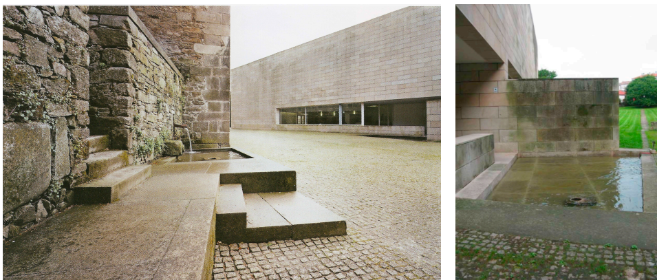
Figura 104 - Fuente y pila proveniente de la parte alta
