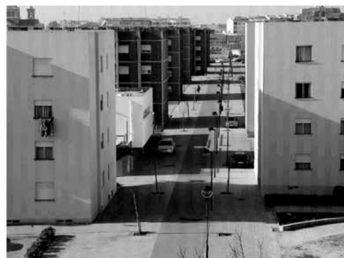
FIGURA 22. VISTA DA VIA PEDONAL COM A ALAMEDA DE EMERGÊNCIA.
