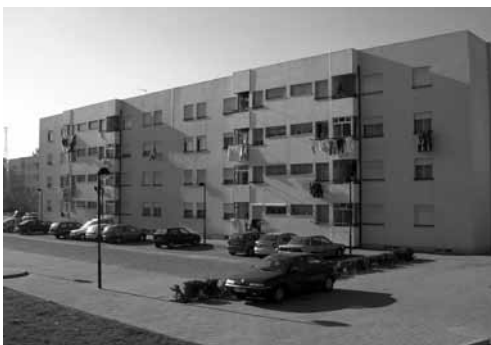
FIGURA 25. ÁREA DE ESTACIONAMENTO NAS TRASEIRAS DO EDIFÍCIO.
