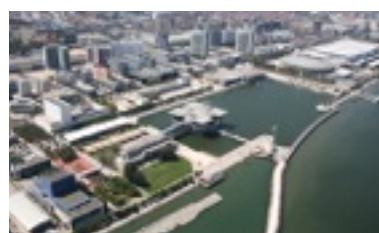
Figura 15. Parque Expo.Lisboa (2015) http://www.parqueexpo.pt/cache/binImagens/pq_01-4722.jpg
