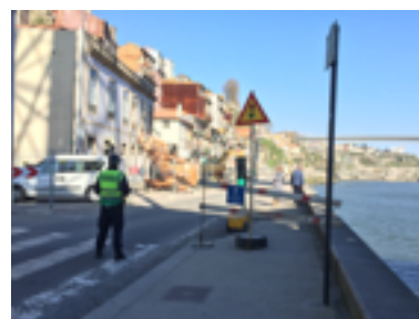
Figura 66, rua em obras, Porto
