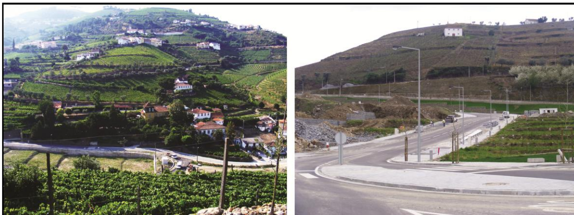
Imagem 71 - Zona Oficial (em construção) Foto: Autor (2011).
