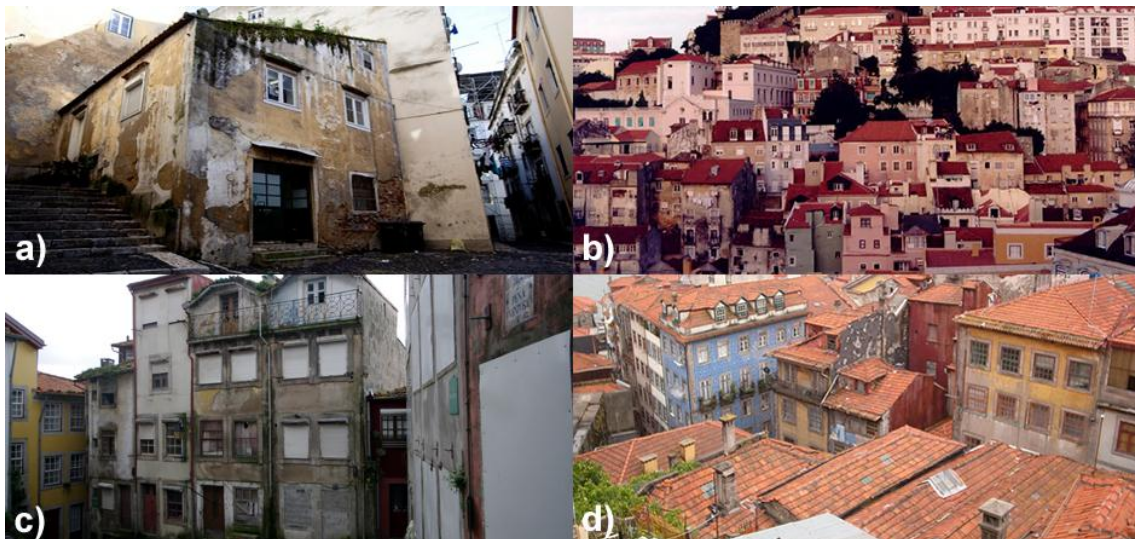
Figura IV.13 - Estado de degradação dos centros urbanos históricos portugueses
