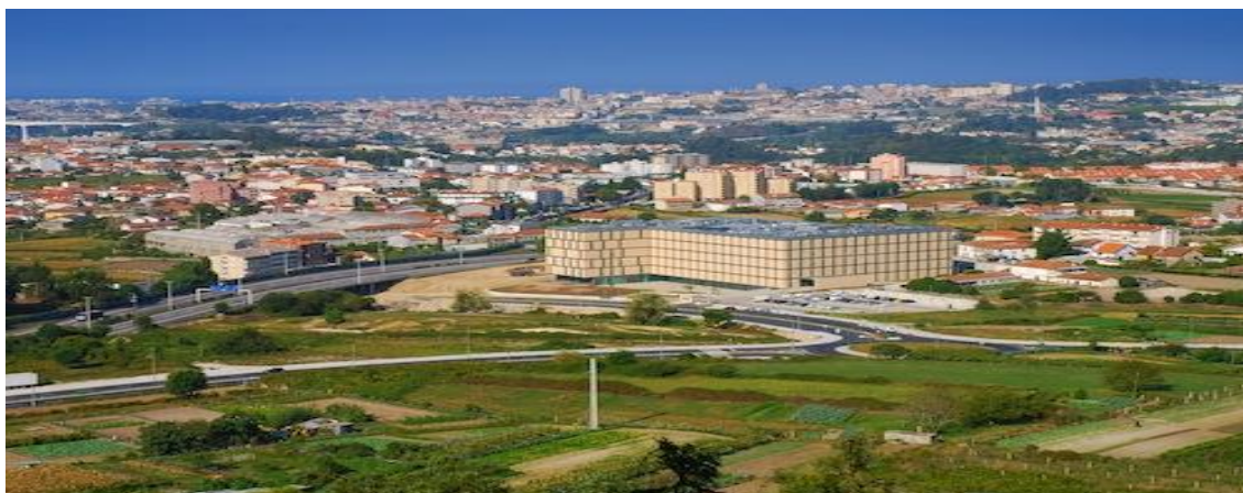
Figura 3: Vista do Hospital-Escola Fernando Pessoa, ao lado da IC29
