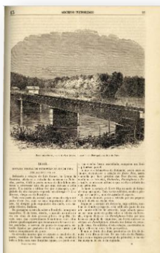
Figura 31 – Archivo Pittoresco , nº 13, 1865 – A Ponte americana ou de Carlos Gomes, na estrada de Petropolis ao Juiz de Fora
