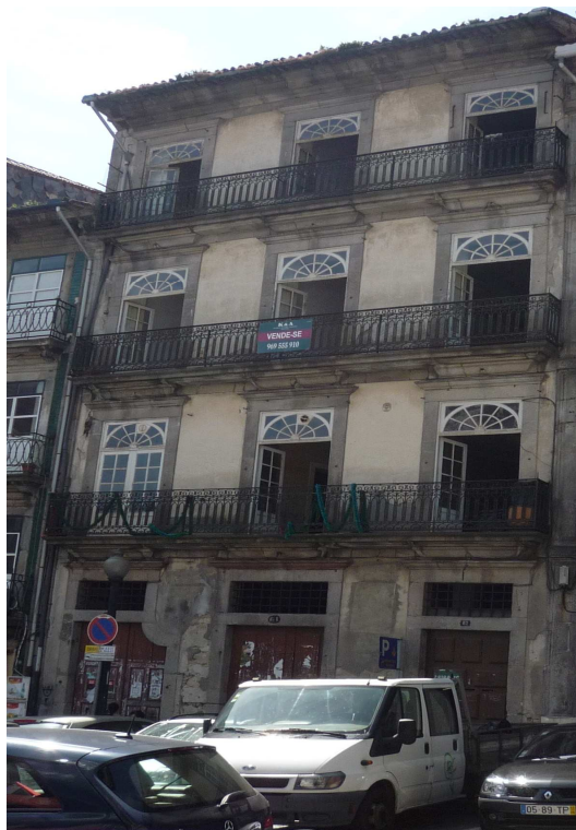
Fig. 76 – Visualização das varandas corridas, entre duas paredes de meação de um edifício.
