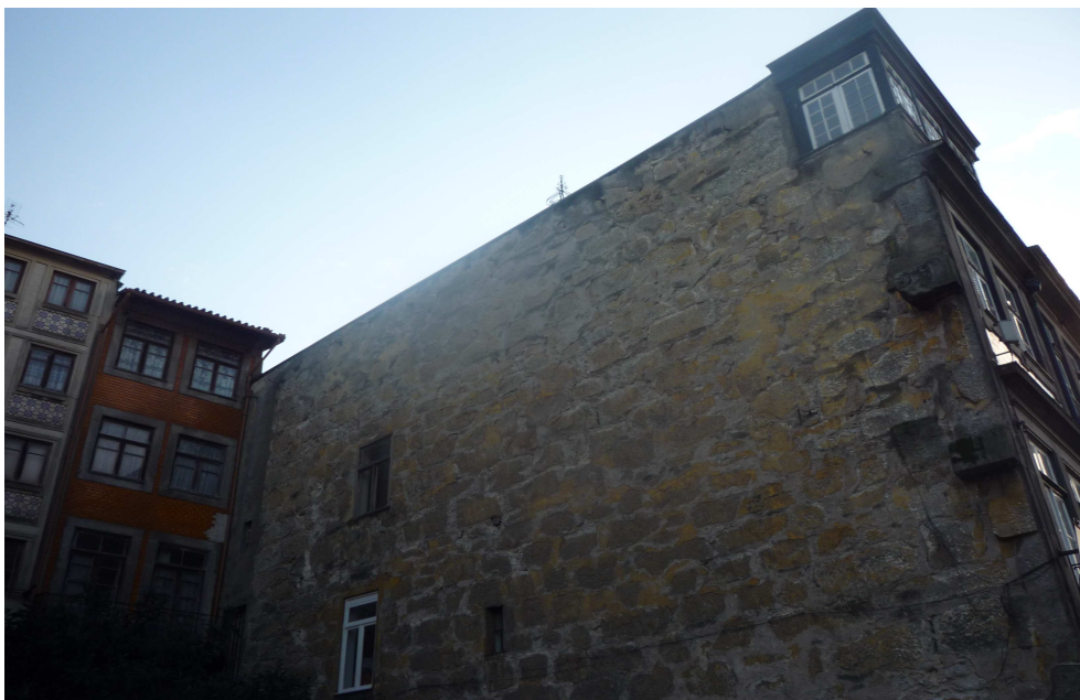
Fig. 117 – Alçado em alvenaria de pedra aparelhada (juntas desalinhas) - Rua do Infante D. Henrique.
