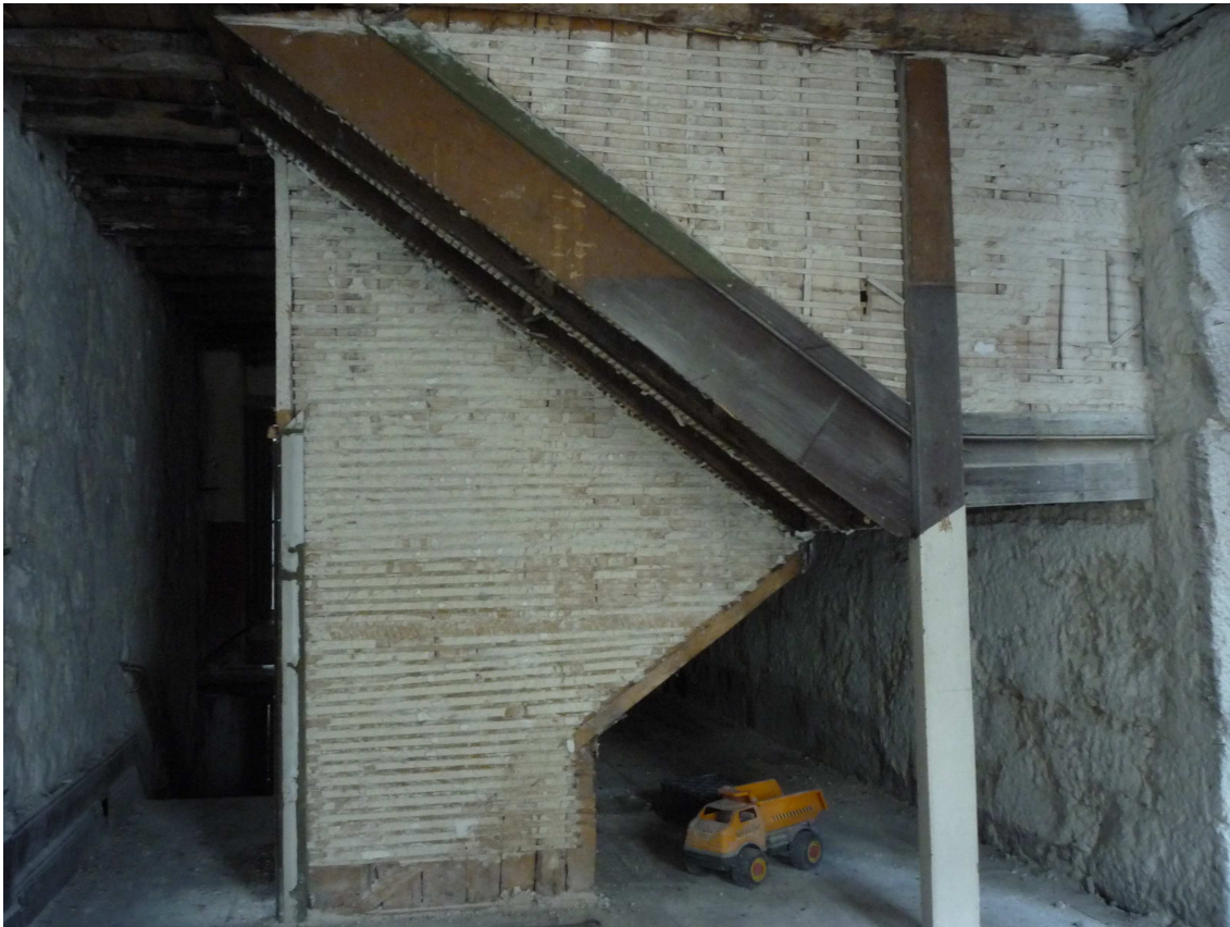
Fig. 110 – Visualização da parede da caixa de escadas a suportar a cadeia dos patamares intermédios.
