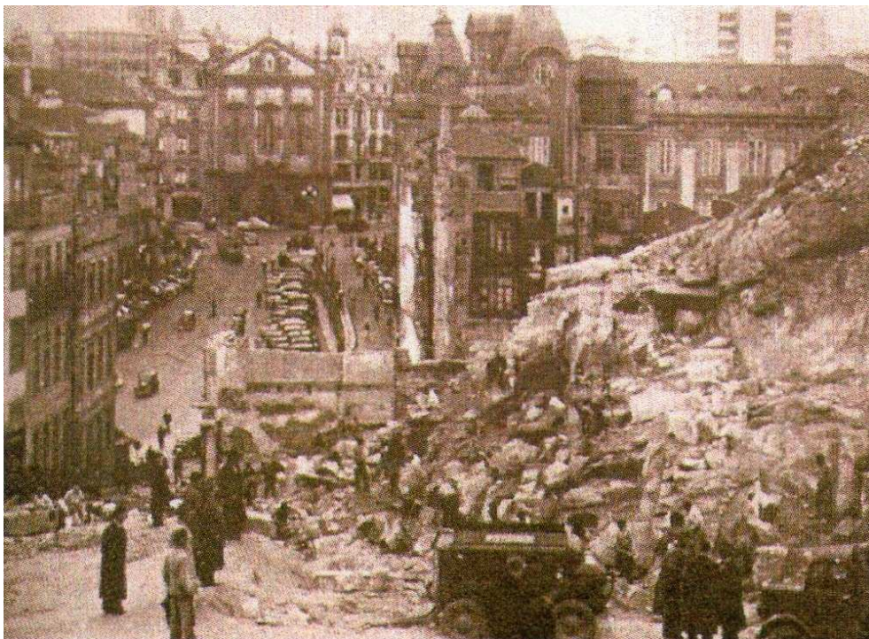
Fig. 47 - Visualização das demolições e desaterros para a abertura da Avenida da Ponte (A. H. M. P. cit. in Assunção 2010, anexo p. 67).
