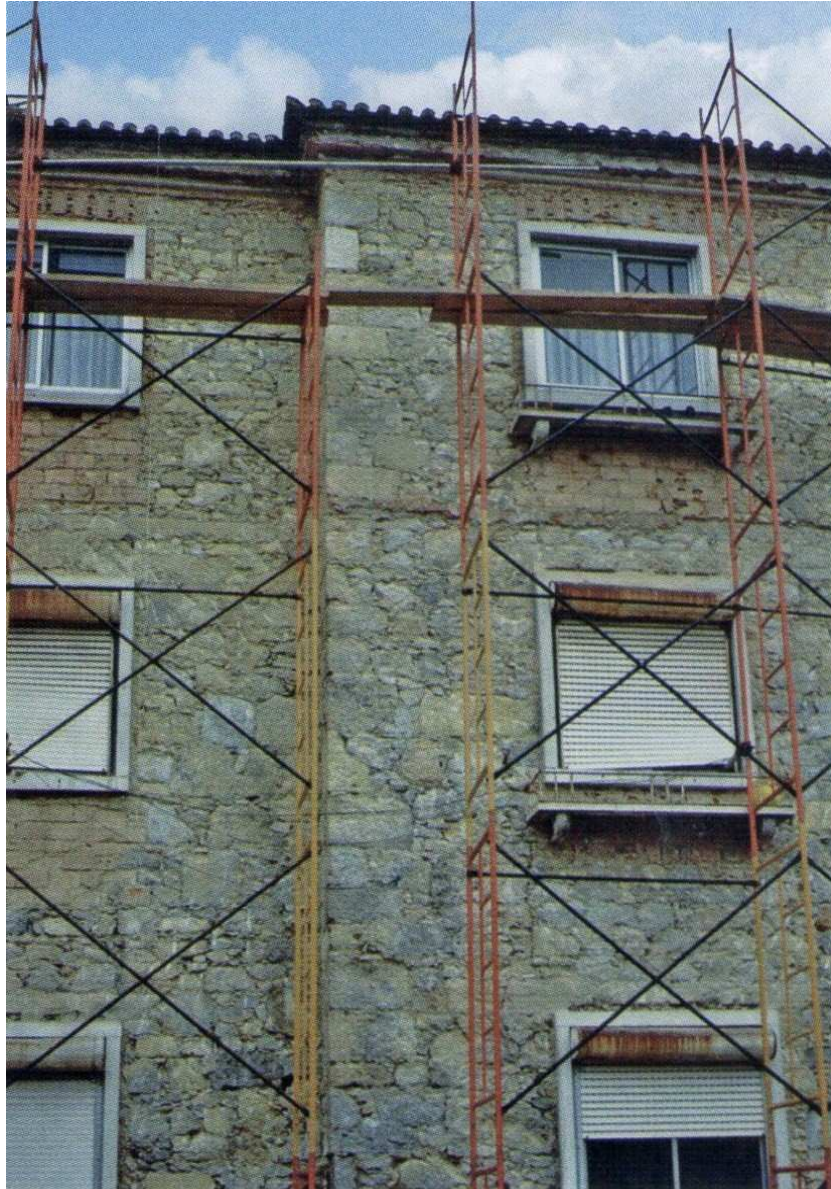
Fig. 134 – Intervenção de reparação para substituir o revestimento em fachada de alvenaria (Aguiar, Paiva e Pinho, 2006, p. 605).
