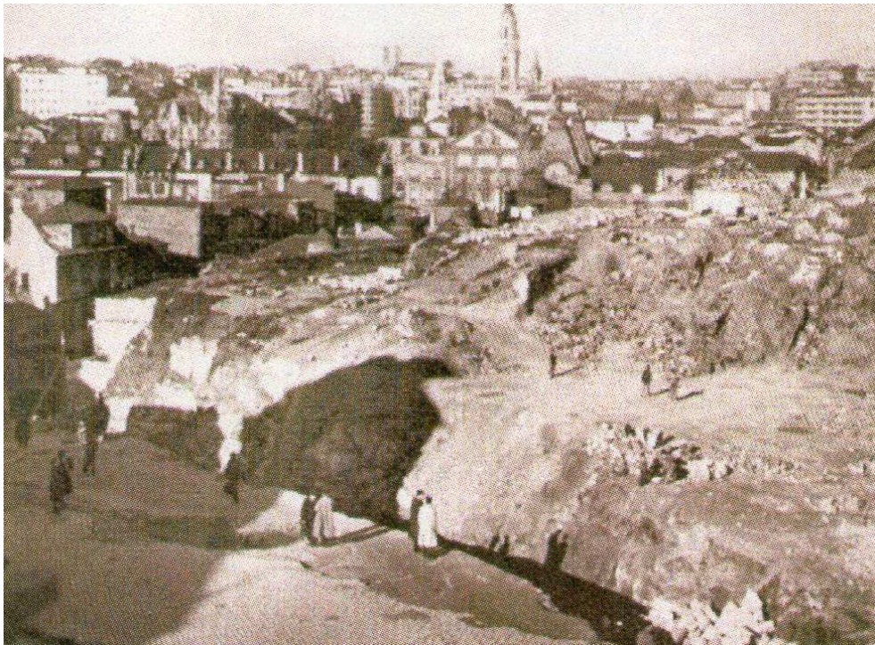
Fig. 45 - Visualização das demolições e desaterros para a abertura da Avenida da Ponte (A. H. M. P. cit. in Assunção 2010, anexo p. 67).
