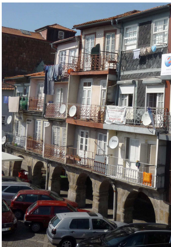
Fig. 66 – Visualização dos conjuntos edificados, em Miragaia.
