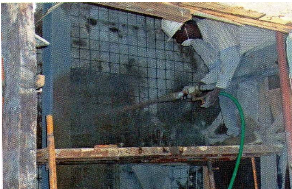
Fig. 138 - Colocação de redes metálicas e projecção de betão para consolidação e aumento da capacidade resistente da parede de alvenaria (Alvenobra cit. in Aguiar, Paiva e Pinho, 2006, p. 606).
