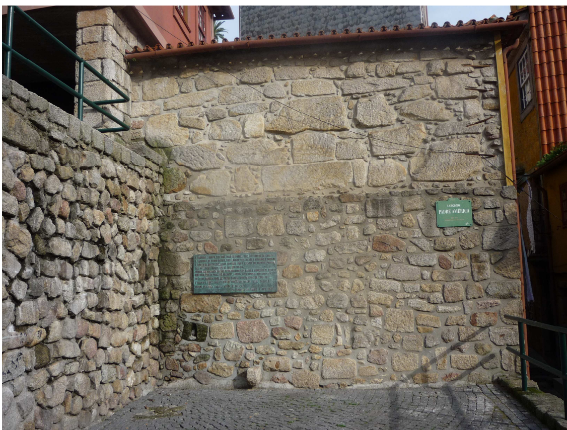
Fig. 119 – Visualização do uso de calços ou cunhas na parte superior e disposição aleatória na parte inferior do alçado - zona do Barredo.
