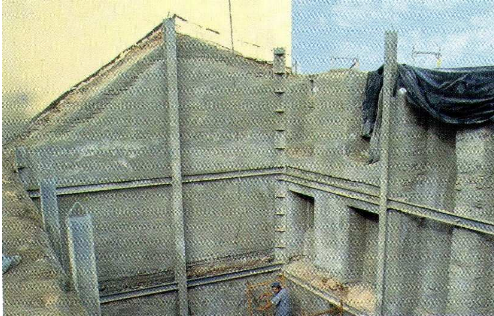
Fig. 135 – Perfis metálicos colocados para aumento da capacidade resistente de paredes de alvenaria e ligação entre paredes ortogonais (Alvenobra cit. in Aguiar, Paiva e Pinho, 2006, p. 606).
