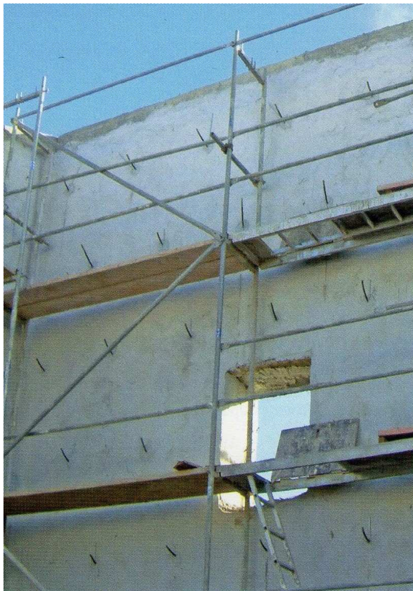
Fig. 140 – Visualização de aplicação de injeções de consolidação em parede de alvenaria de pedra (Bel, S. A. cit. in Aguiar, Paiva e Pinho, 2006, p. 607).
