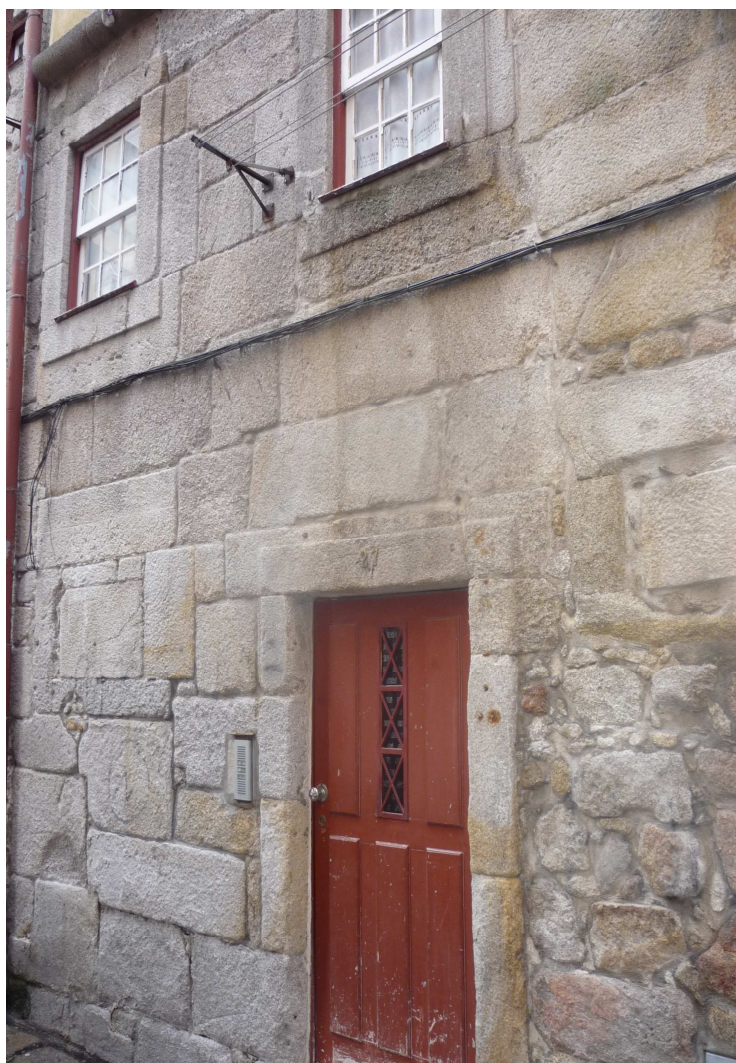
Fig. 116 – Alçado basicamente composto em alvenaria de pedra aparelhada (juntas alinhadas) - zona do Barredo.
