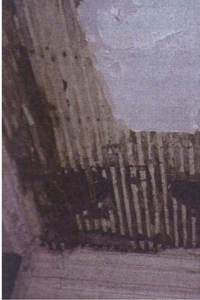
Fig. 97 – Pormenor de um tecto revestido em fasquios, com revestimento e acabamento em gesso (Foto de um grupo de alunos do ano lectivo 2002/2003 cit. in Teixeira 2004, p. 95).
