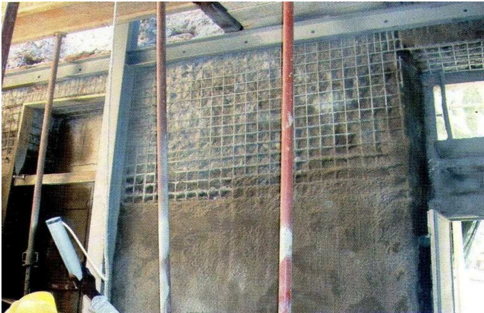
Fig. 137 – Colocação de redes metálicas e projecção de betão para consolidação e aumento da capacidade resistente da parede de alvenaria (Alvenobra cit. in Aguiar, Paiva e Pinho, 2006, p. 606).
