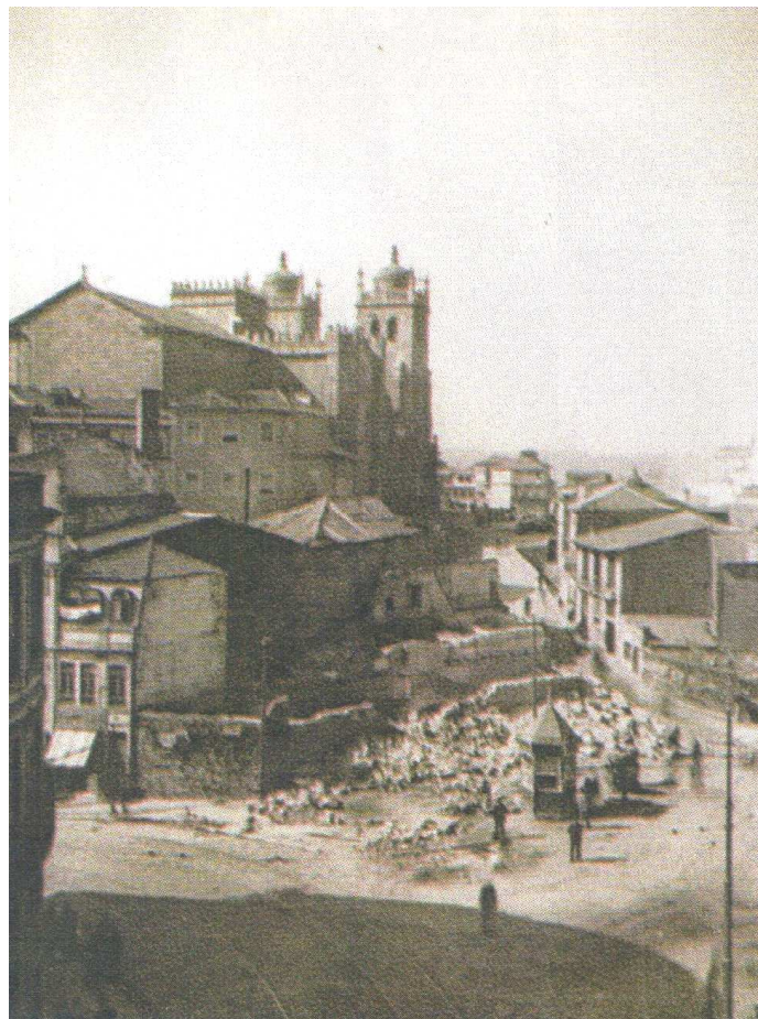
Fig. 43 – Caracterização do local durante as demolições (A. H. M. P. cit. in Assunção 2010, anexo p. 62).
