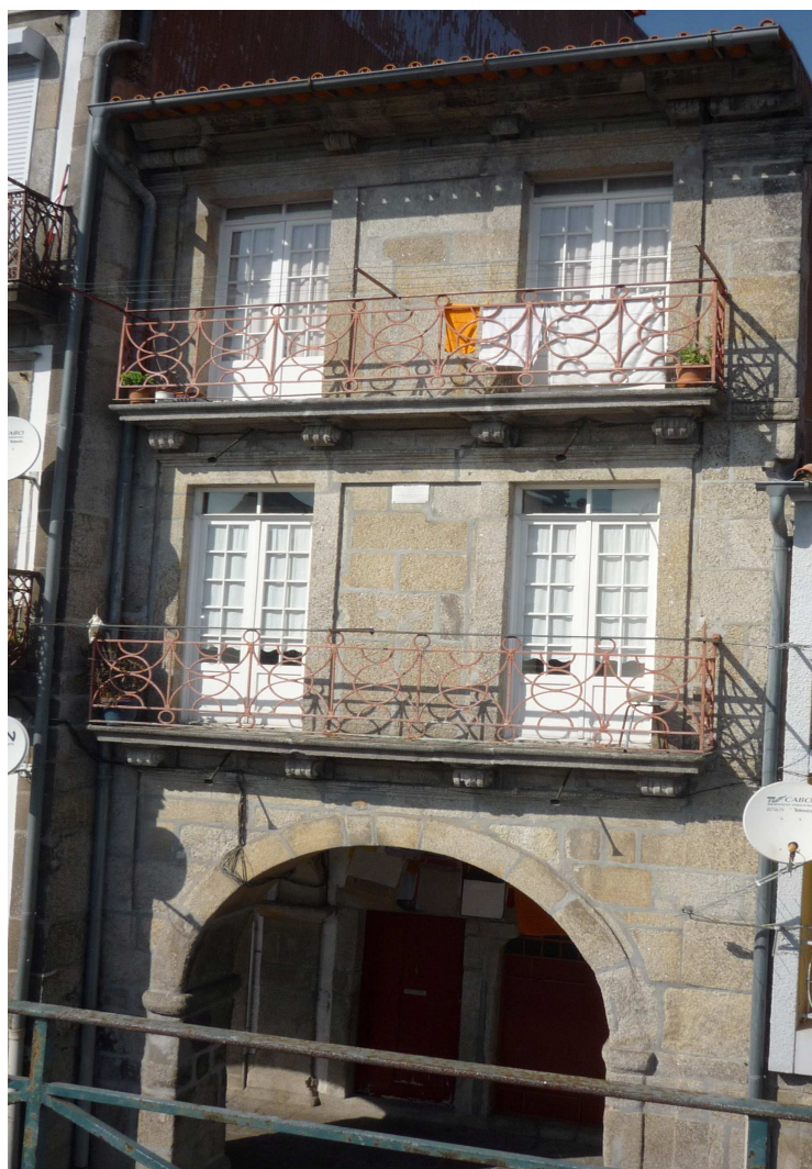
Fig. 79 – Visualização de cornijas, nos remates superiores do edifício.
