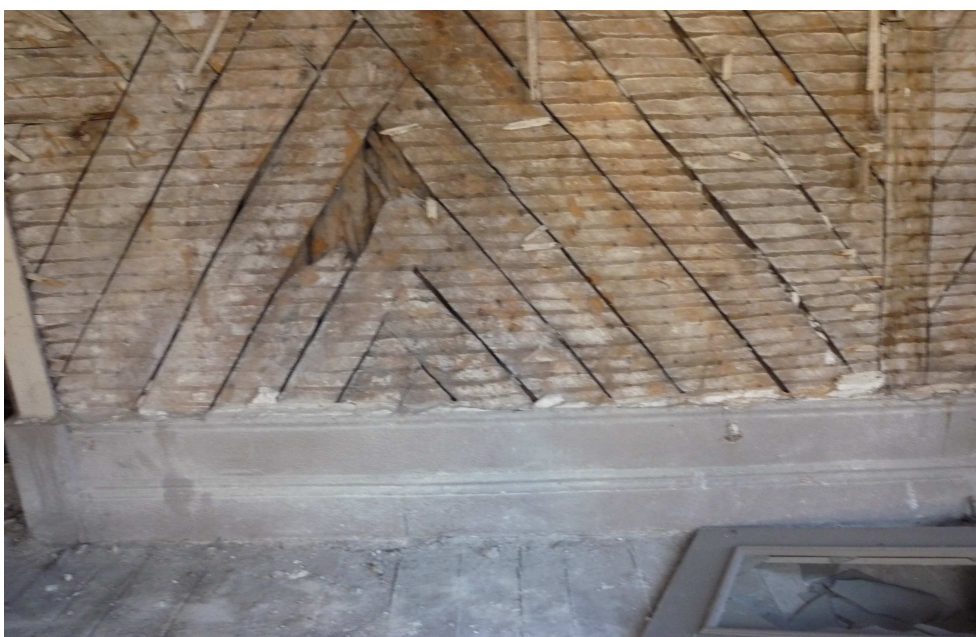
Fig. 87 – Visualização da constituição das paredes em tabique executadas em duplo tabuado.
