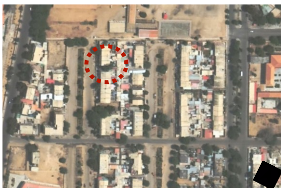
Figura 73: Vista aérea - habitação em banda 2
