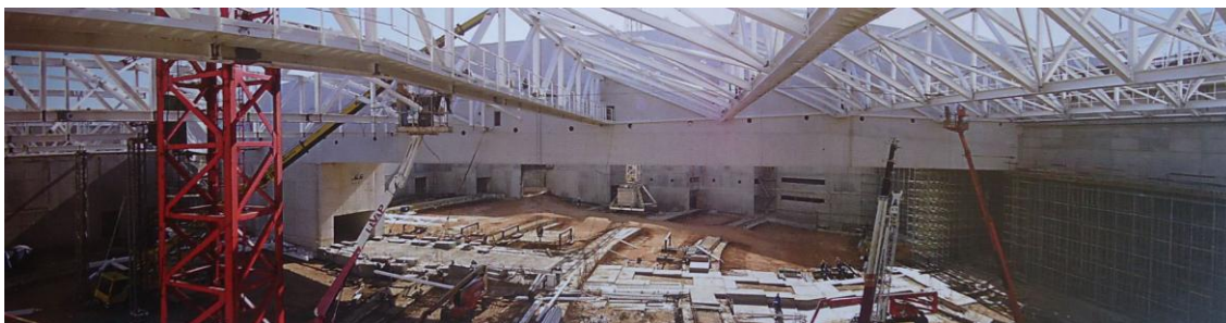
Figura 51 - Panorama do interior da nova igreja polivalente em fase de obra. (Fonte: Alexandros Tombazis, 2005).
