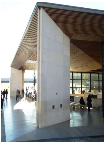
Figura 45 - Um dos Apoios, que serve de estrutura ao alpendre. (Fonte: Patrick Silva, 2012).
