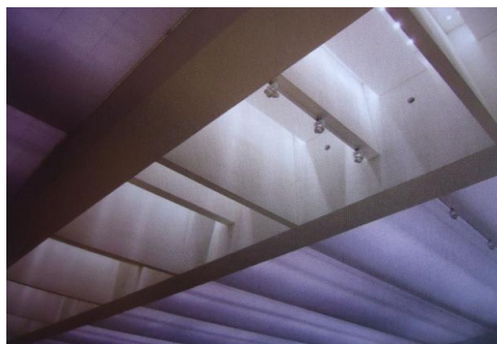
Figura 64 - Pormenor da iluminação do teto. (Fonte: Fernando Guerra, 2009).
