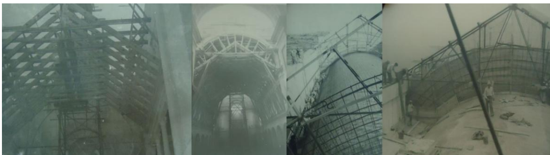
Figura 21 – Construção da cobertura - montagem da cambota, armaduras do casquilho e dos arcos, etc. (Fonte: Arquivo do Santuário de Fátima, 1945).
