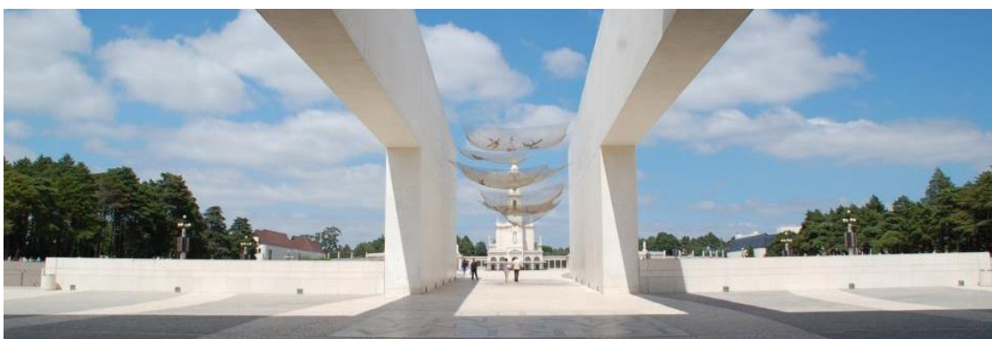
Figura 55 - Panorama do pórtico de entrada, proporcionado pelas vigas gêmeas (Fonte: Leandro Magalhães, 2012).
