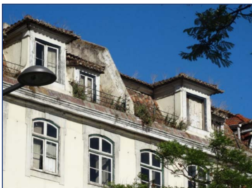
Imagem 11. Parede Corta-Fogo, usada para impedir a expansão do incêndio (Santos, 2017)
