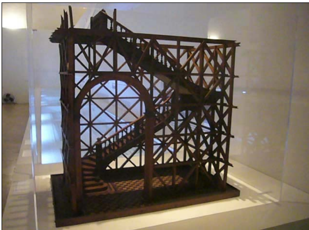
Imagem 13. A “gaiola Pombalina”, aparente em maqueta, na recuperação de edifício da baixa lisboeta (Bueno)
