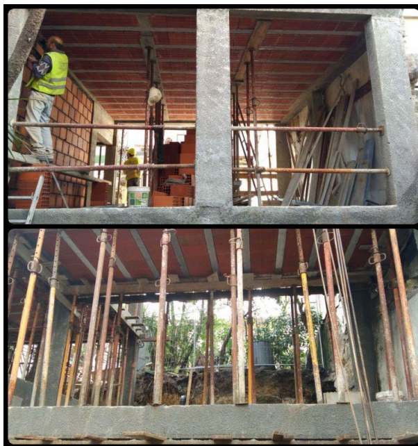
Figura 12: Estrutura de betão
