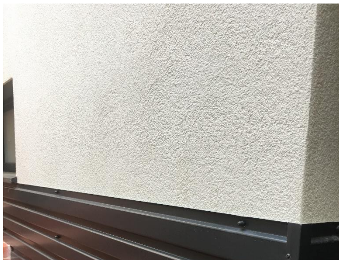
Figura 26: Isolamento térmico: "Capotto"
