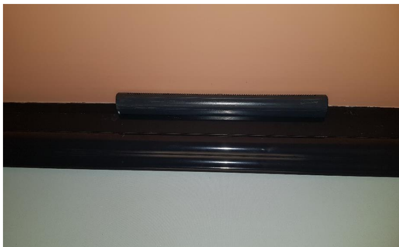
Figura 19: Abertura de ventilação autorregulável
