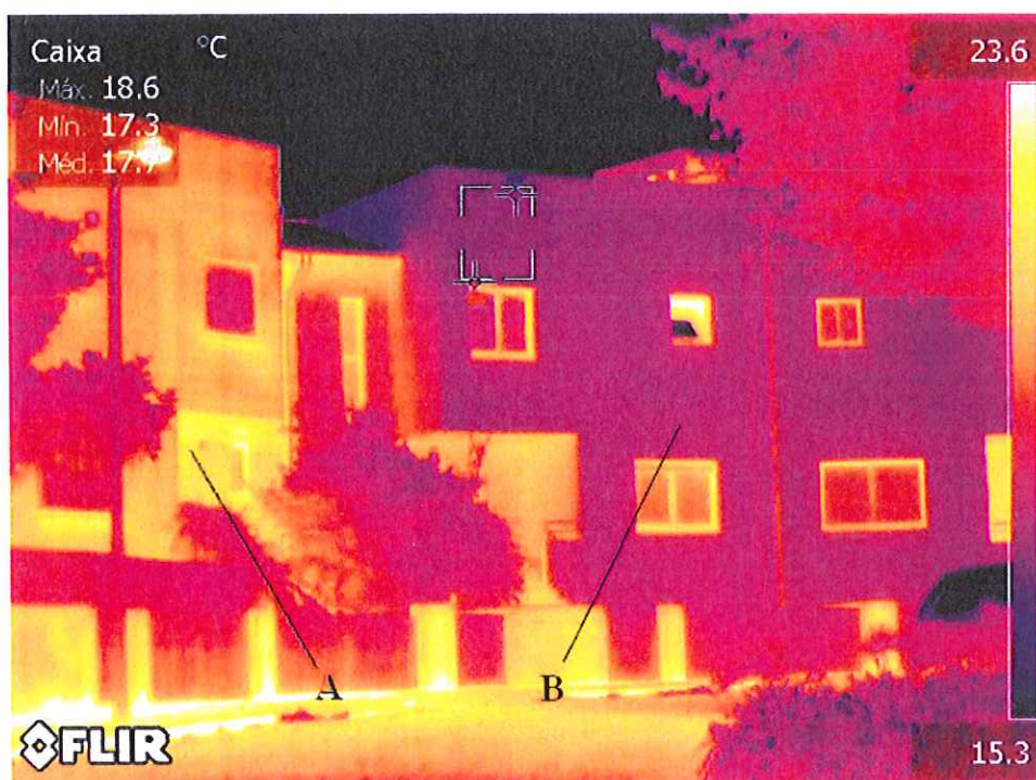
[Figura 1.5. - Imagem Térmografica de duas moradias; Fonte: Eng.º António Cardoso/FLIR]
