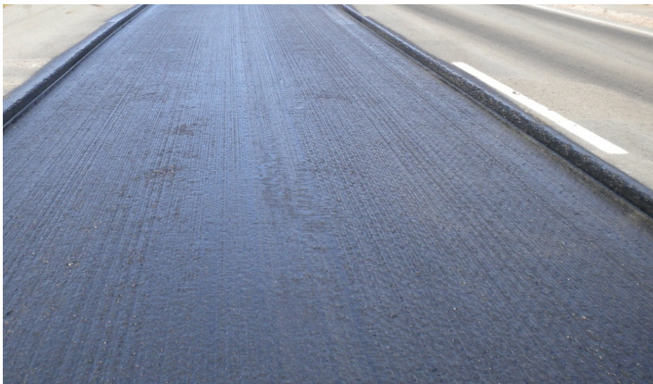
Figura III. 8 - Superfície de Pavimento com a Rega Colagem
