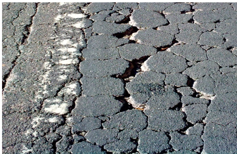
Figura III. 4 - Fendas do Tipo Pele Crocodilo
