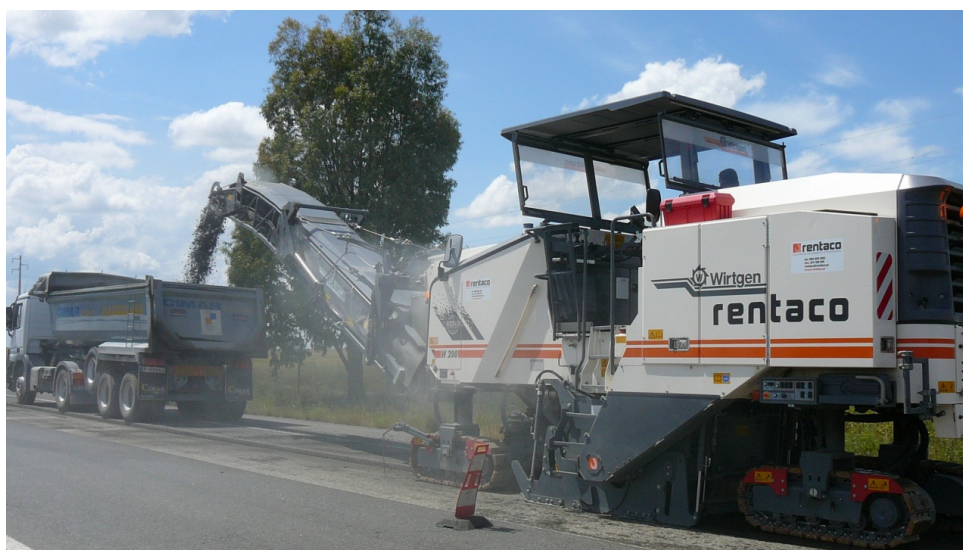
Figura III. 17 - Fresagem do Pavimento Existente
