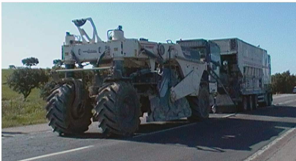
Figura II. 1 – Equipamento de Reciclagem In Situ a Frio
