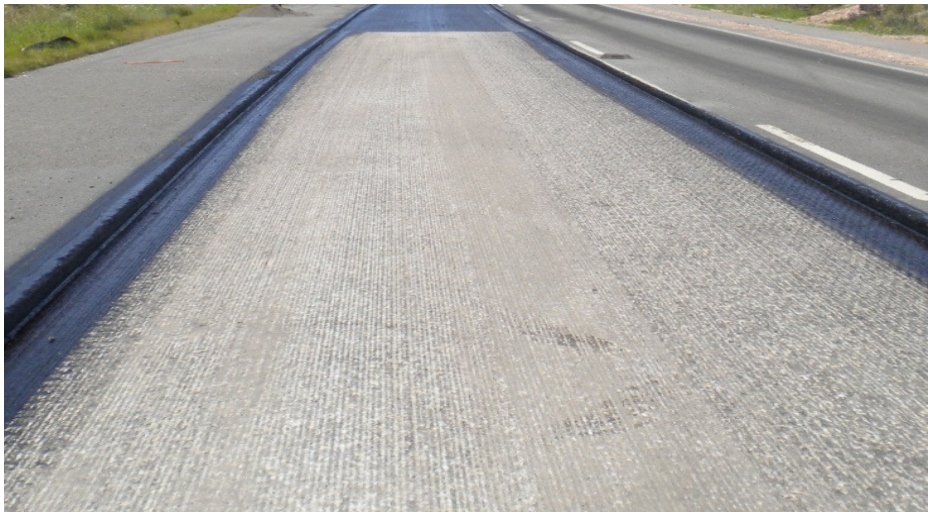
Figura III. 7 - Superfície de Pavimento Limpa Pronta para Receber a Rega Colagem
