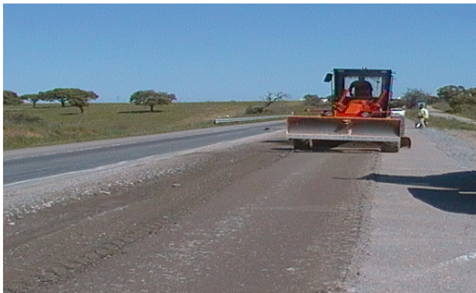
Figura III. 14 - Motoniveladora a Realizar o Nivelamento da Camada
