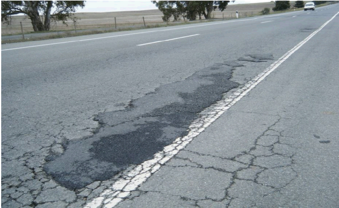
Pele de Crocodilo, Remendo de Grande Dimensão
