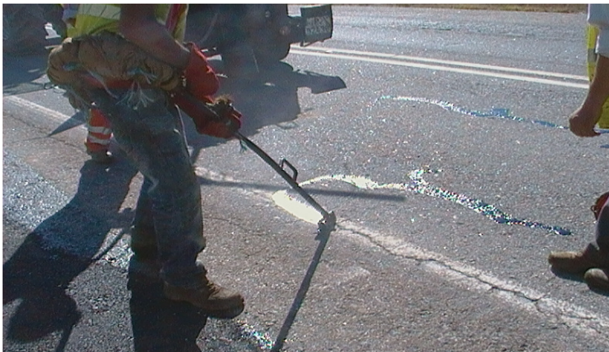
Figura III. 3 - Equipa a Realizar a Reparação de Fendilhamento/Fendas Fadiga
