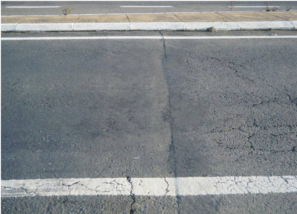
Fenda Transversal, Fendas de Fadiga
