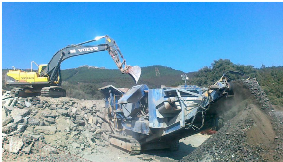
Figura III. 16 - Processo de Britagem com Britadeira Móvel
