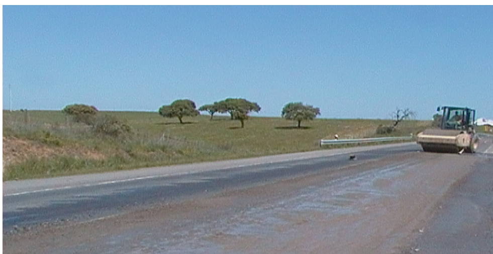
Figura III. 15 - Cilindro de Rolos a Realizar a Compactação da Camada
