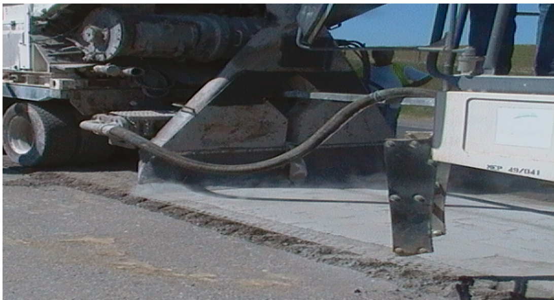
Figura III. 12 - Incorporação do Cimento
