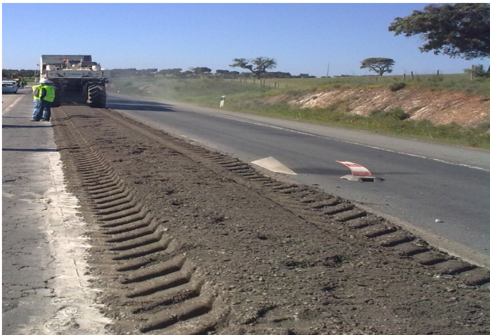
Figura III. 13 - Aspeto do Material Fresado
