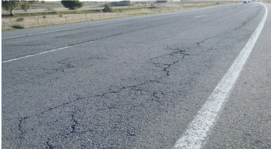
Fenda Longitudinal Ramificada com Bordos Degradados, Ninhos
