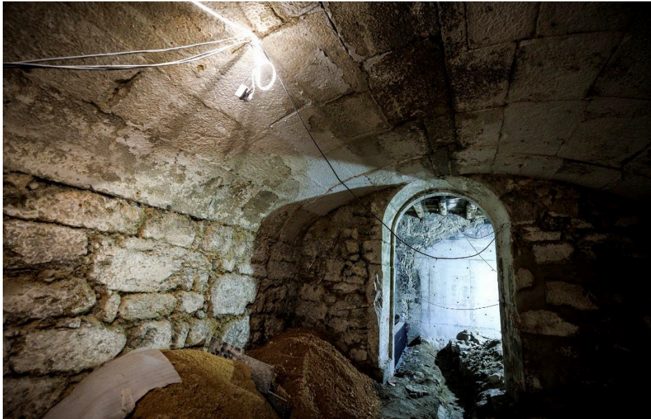
Figura AN.22 Picagem de revestimentos interiores (Fonte: Guilherme Oliveira)
