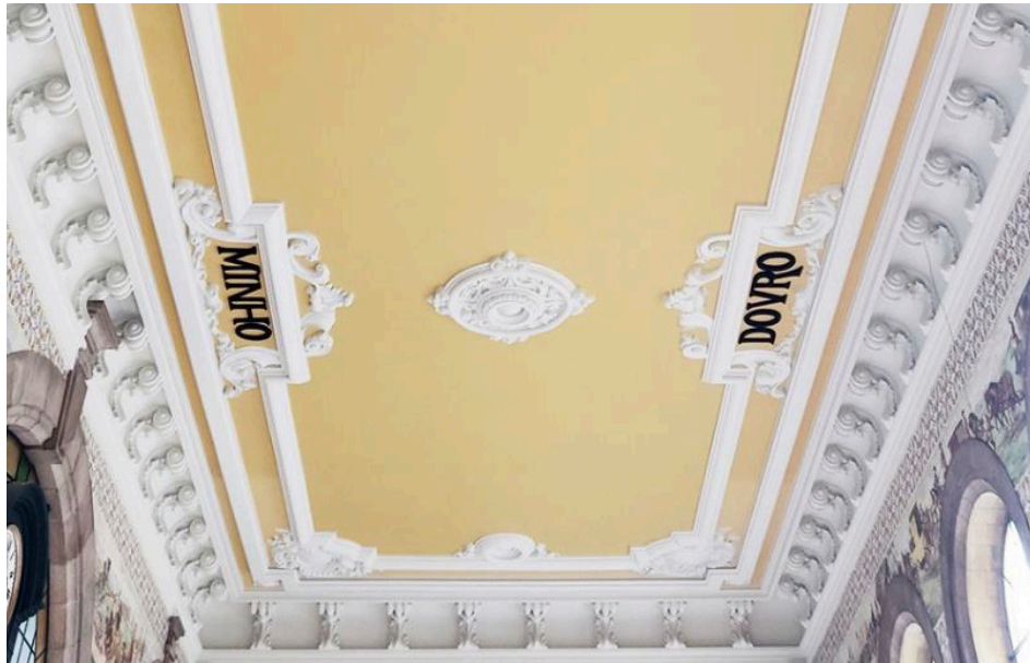
Figura 8 Teto do átrio da Estação de São Bento - atualidade (Fonte: Google Images)
