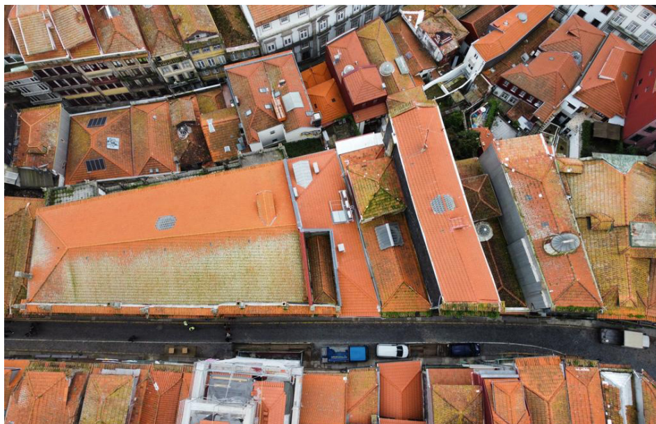
Figura AN.12 Vista aérea do Palácio antes da obra
