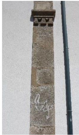
Figura 62 Pináculos e cantarias exteriores b)
