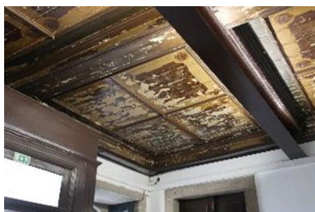
Figura 46 Teto hall de entrada a)
