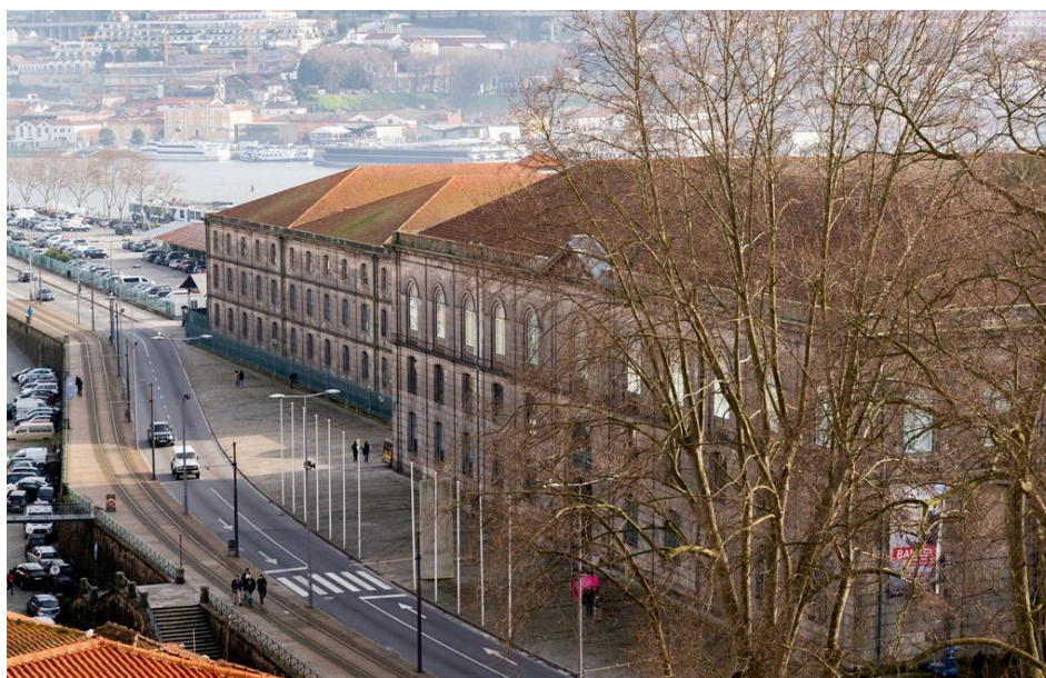
Figura 29 Fachada do edifício da Alfândega Nova do Porto e rua - atualidade (Fonte: APCER Group)
