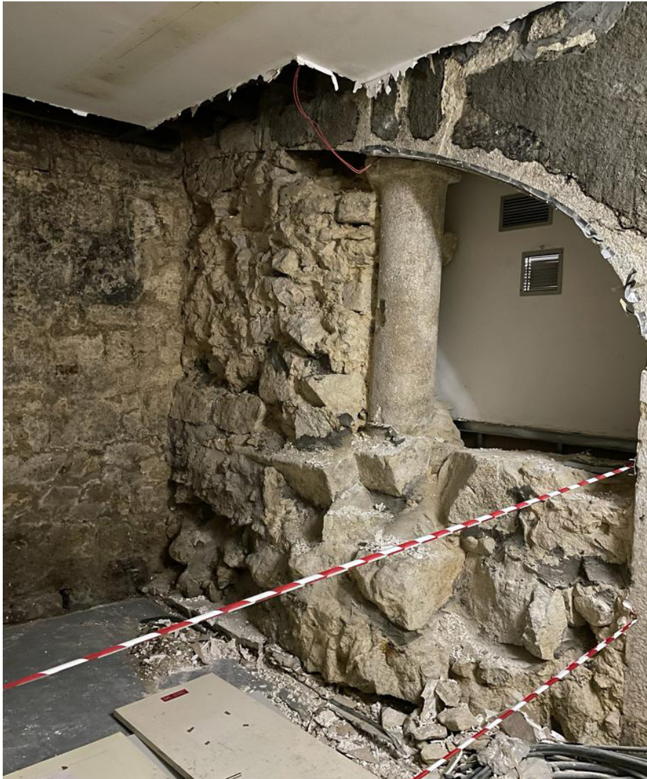
Figura 58 Arco em pedra no piso -1
