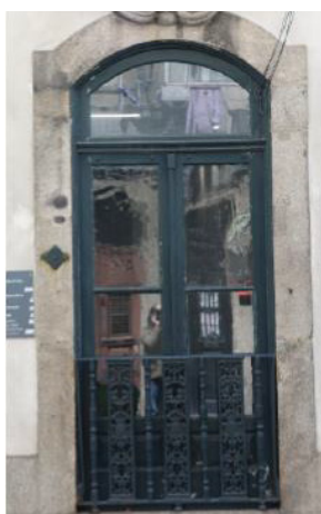
Figura 65 Guardas e elementos metálicos a)
