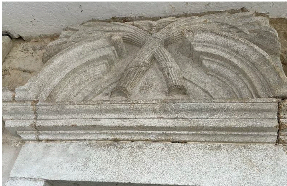
Figura 64 Cantarias em fase de restauro
