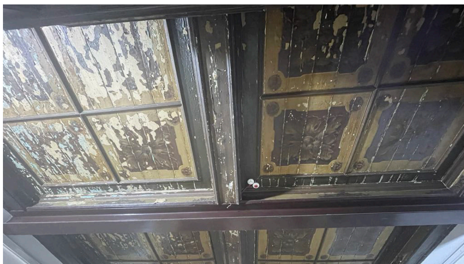
Figura 79 Teto de hall de entrada
