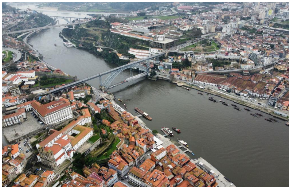
Figura AN.10 Vista aérea do Rio Douro
