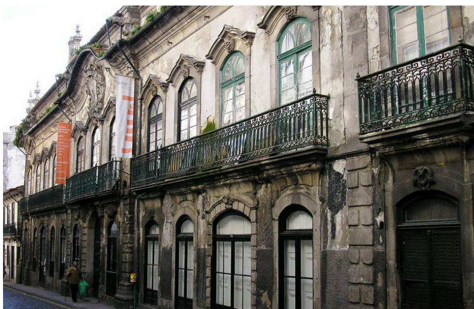
Figura 39 Fachada frontal do Palácio de Belomonte: virada para a R. de Belomonte (Fonte: Google Images)
