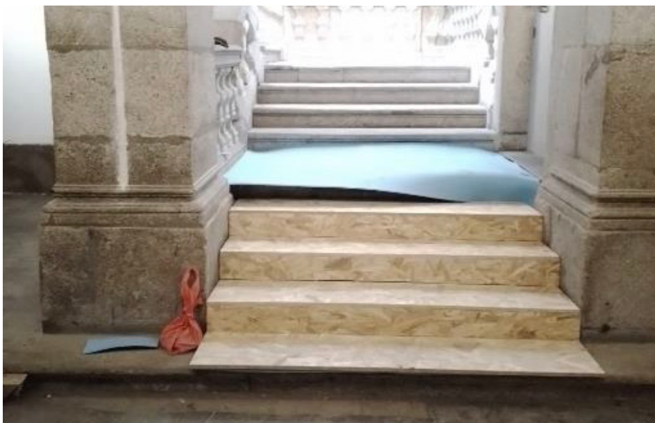
Figura 70 Escadaria, balaustres e corrimões em pedra de granito b)
