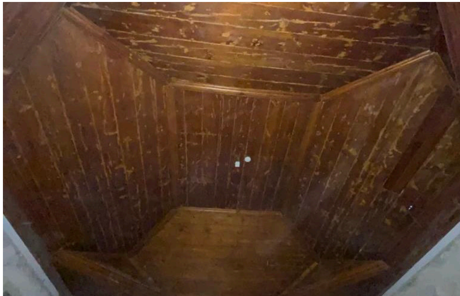
Figura 82 Teto em masseira da Sala C
