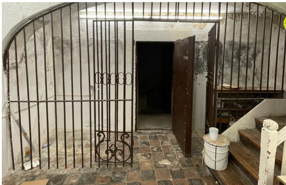
Figura 59 Guarda metálica de acesso à caixa forte
