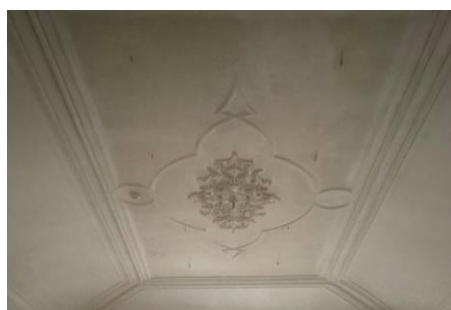
Figura 54 Teto da Sala B
