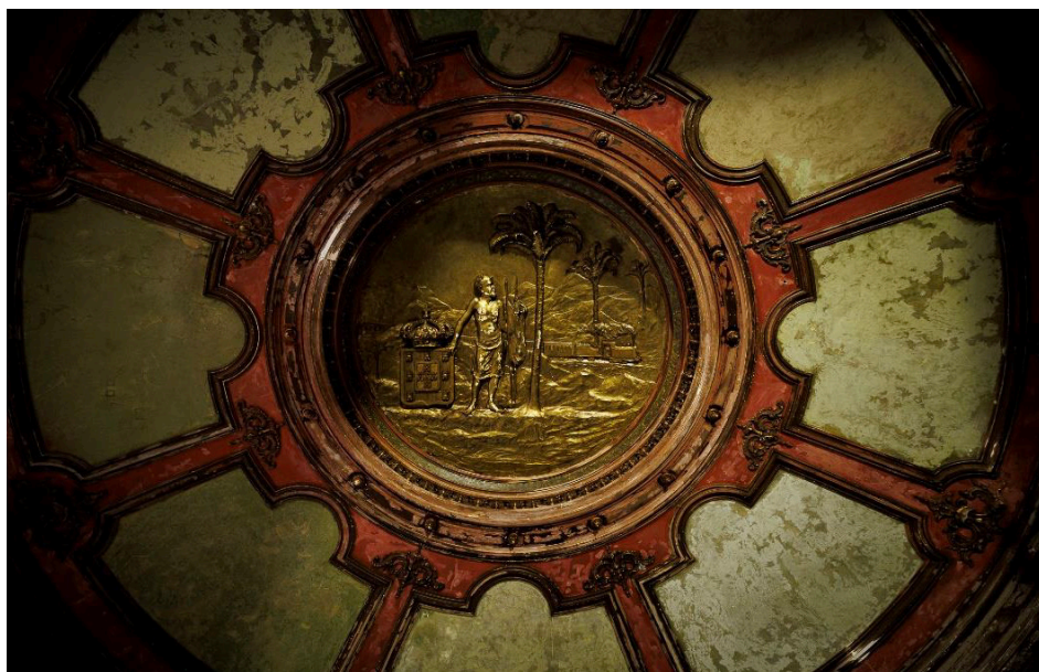
Figura 74 Teto do salão nobre: em fase de restauro (Fonte: Guilherme Oliveira)
