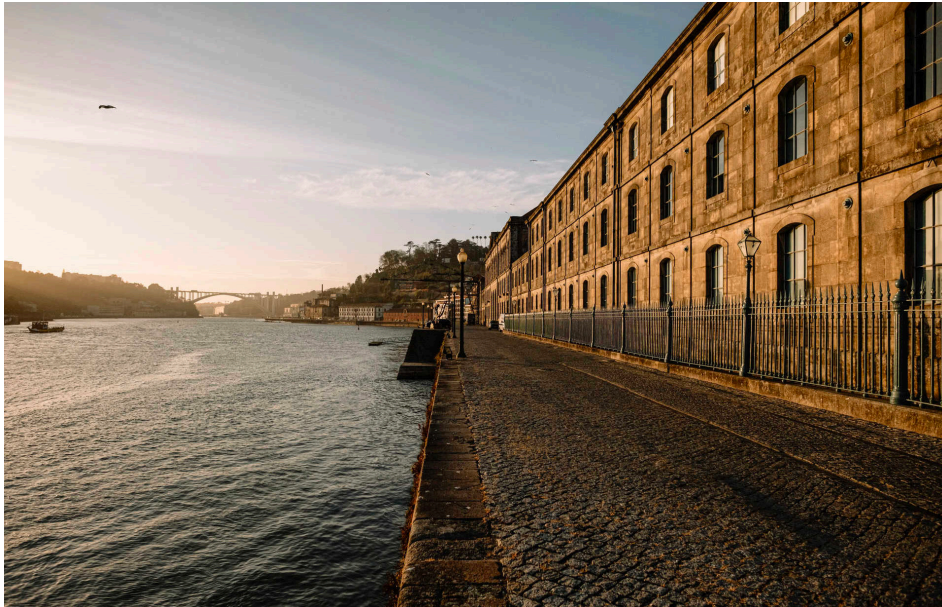
Figura 30 Tardoz do edifício da Alfândega do Porto - atualidade (Fonte: Igor Martins)
