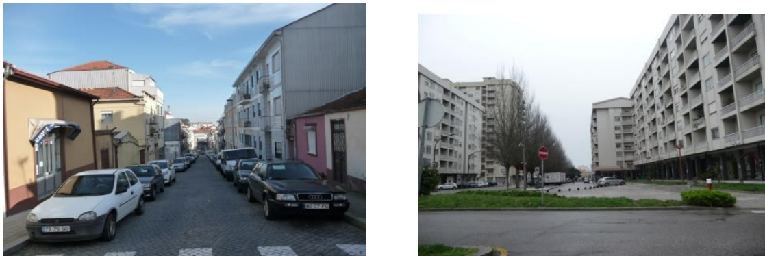
Figura 19 - (esquerda) Rua da Aliança - Permeabilidade dos limites uniforme fraca, (Direita) Rua Damião de Góis – Permeabilidade dos limites uniforme forte
