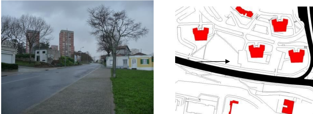
Figura 14 – Bairro da Pasteleira – partilha do espaço público com edifícios autónomos
