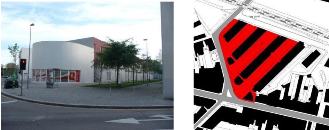
Figura 33 - Rua Águas Férreas – Estrutura habitacional e espaço público localizado num plano horizontal
