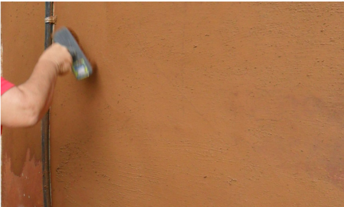
Figura 65 | Aplicação de Reboco de terra.
