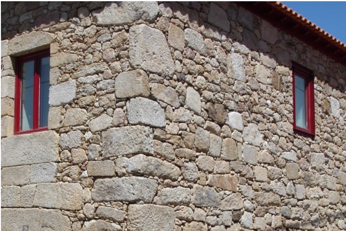
Figura 35 | Fachada em Granito, Tarouca.
