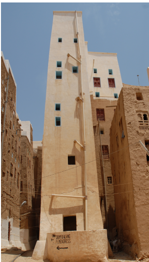
Figura 6 | Exemplo da técnica construtiva em adobe, Shibâm, Iémen.
