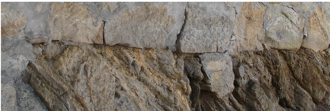
Figura 34 | Composição de muro exterior em xisto e granito, Tabuaço.
