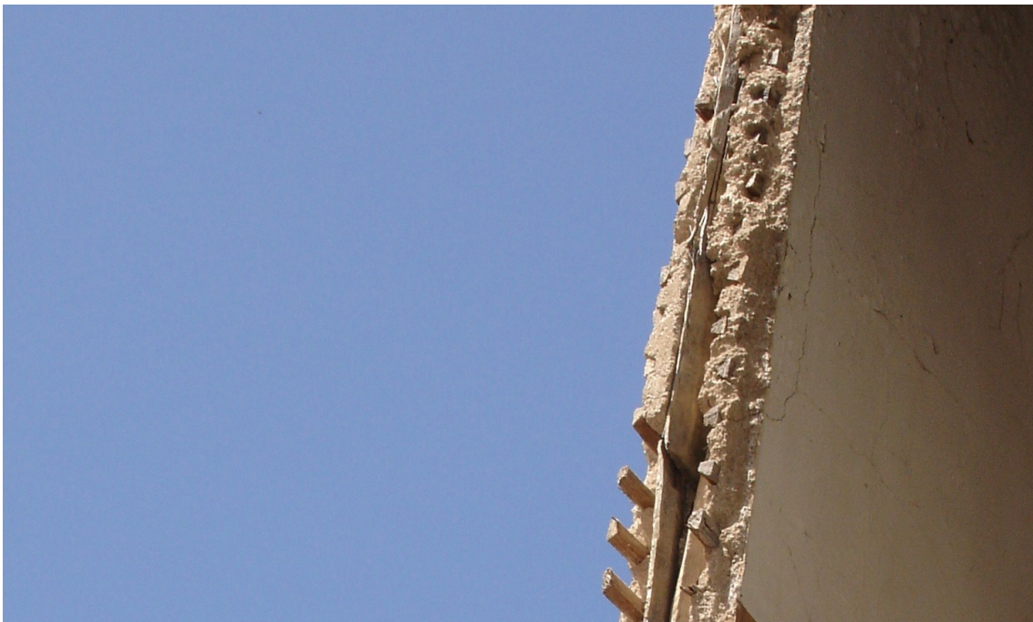
Figura 64 | Argamassa de terra em parede de tabique, Tarouca.
