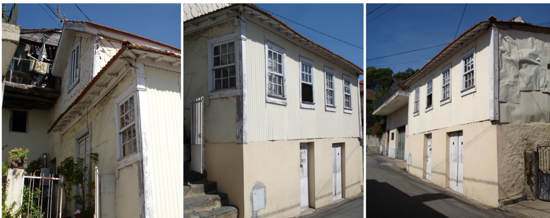
Figura 77 | Exemplar em tabique em bom estado de conservação - Aldeia de Fontes.
