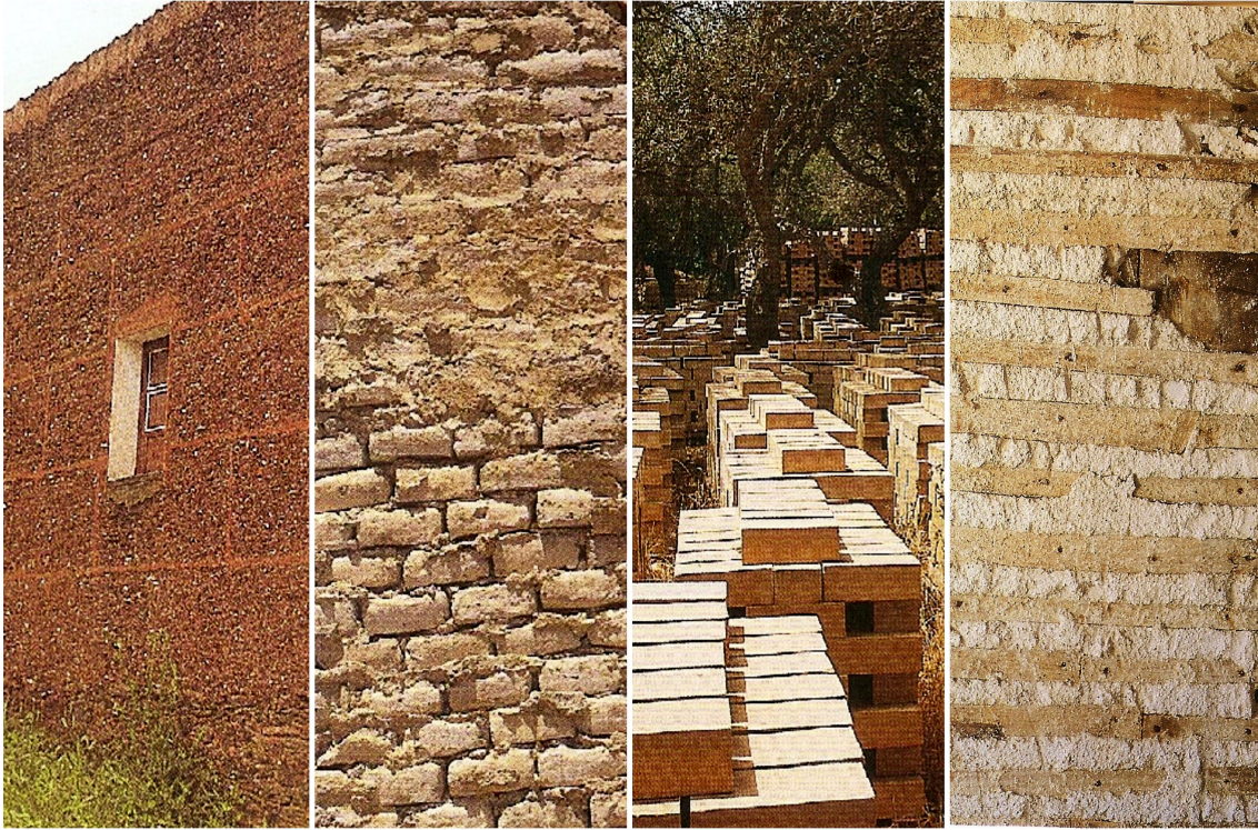
Figura 18 | Taipa, Adobe, BTC e Tabique.
