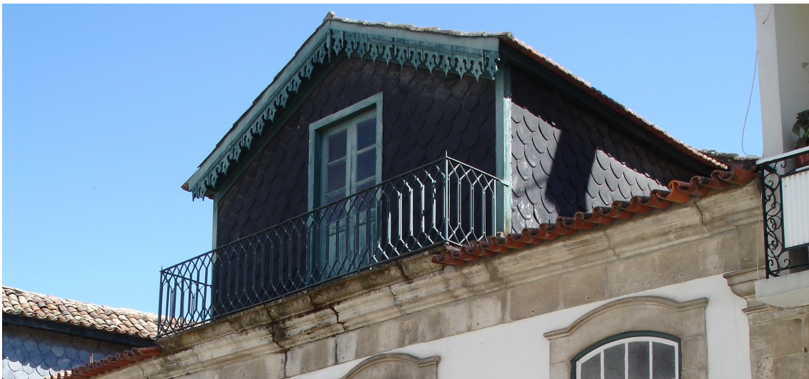
Figura 61 | Acréscimo ou trapeira em tabique revestido a lousa, Tabuaço.
