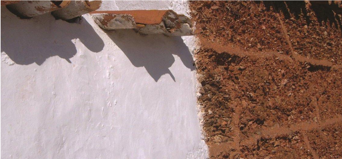
Figura 50 | Parede em taipa caiada.
