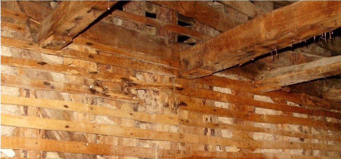
Figura 52 | Estrutura de madeira na concepção do tabique, Tarouca.
