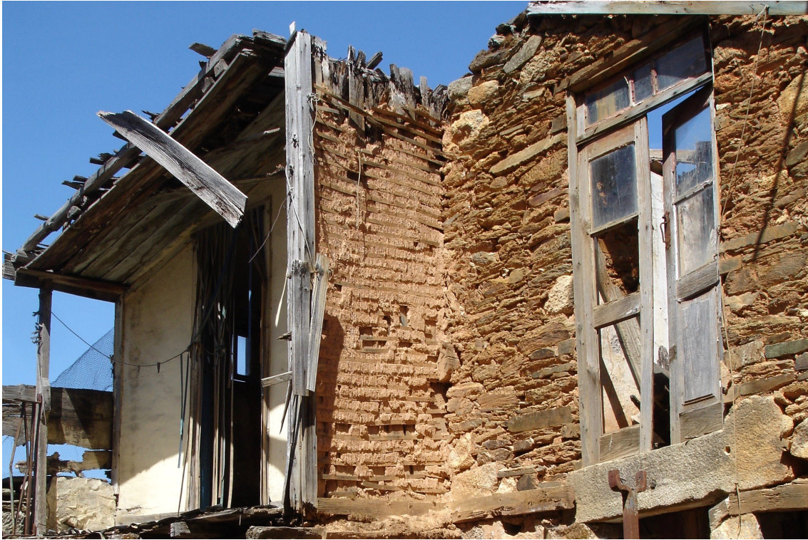
Figura 15 | Construção em tabique, Tabuaço.
