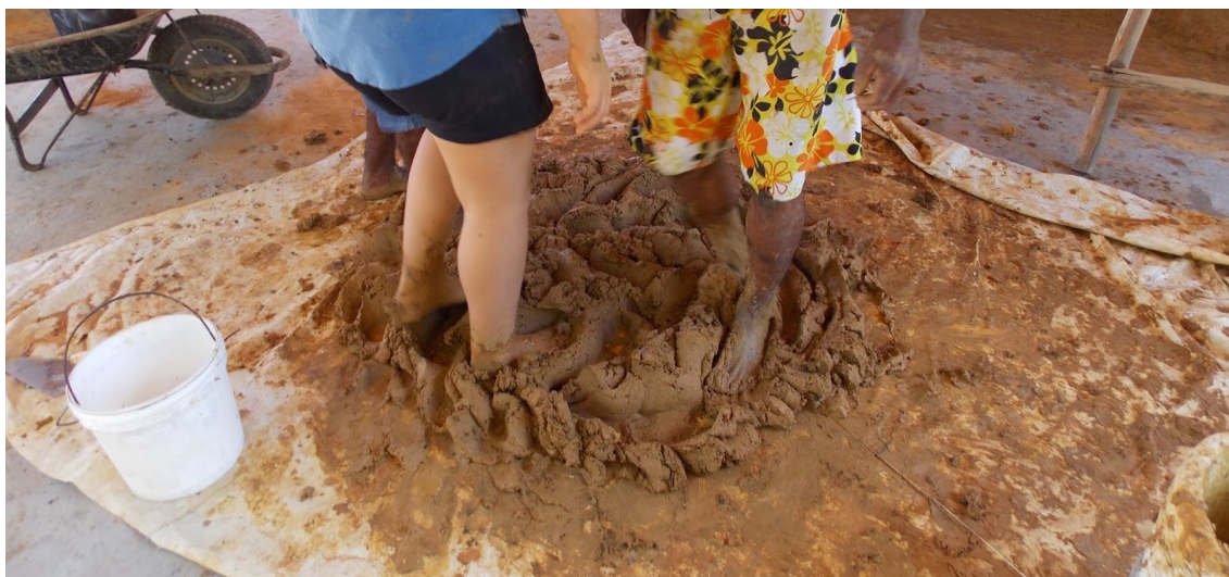
Figura 32 | Selecção e preparação da terra para aplicação.
