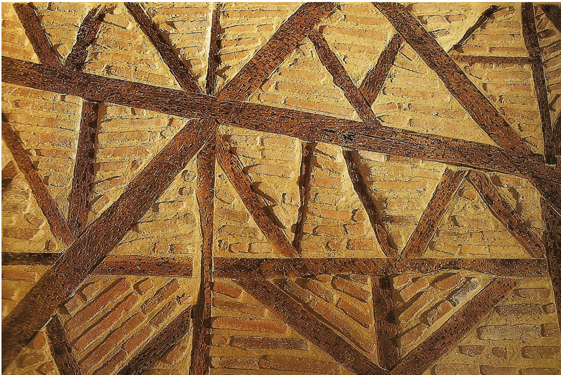
Figura 63 | Taipa de Rodízio - Edifício em Miragaia, Porto.
