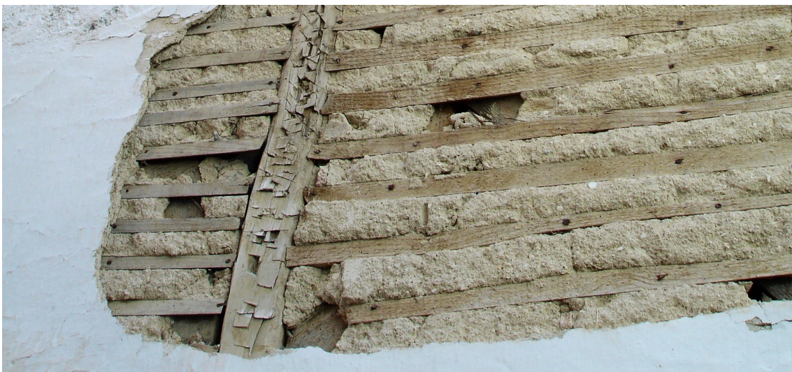
Figura 47 | Argamassa em terra, Tarouca.
