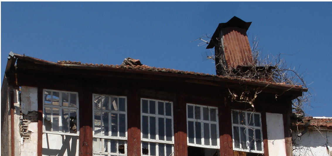
Figura 67 | Chaminé em tabique de edifício antigo, Vila Real.
