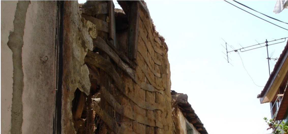
Figura 70 | Degradação do tabique por agentes naturais, Vila de Salzedas.
