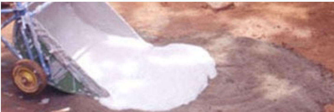
Figura 33 | Estabilização química do solo à base de cal.
