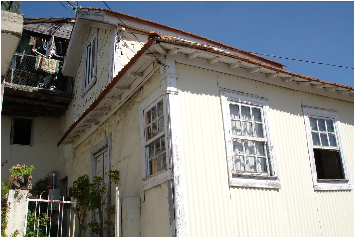
Figura 30 | Tabique, Vila de Fontes.
