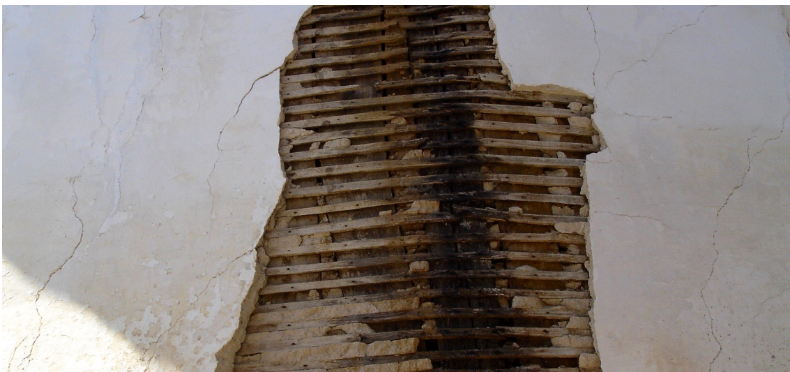
Figura 48 | Reboco em terra, Santa Marta de Penaguião.
