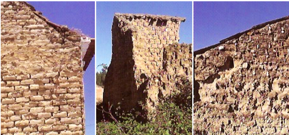
Figura 14 | Alvenarias em Adobe, Portugal.
