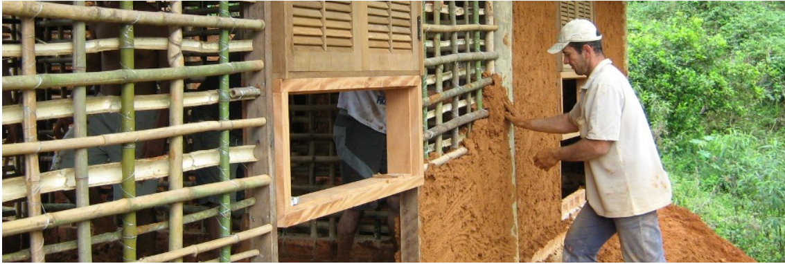
Figura 57 | Enchimento do engradado de madeira - Pau a pique, Brasil.
