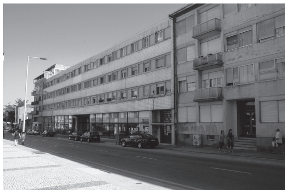
Figura 1 – Edifício na rua Latino Coelho. Fotografia do autor
