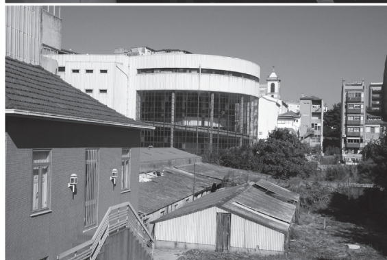
Figuras 8, 9, 10 – Vistas do edificado, conforme segunda proposta. Fotografias do autor.
