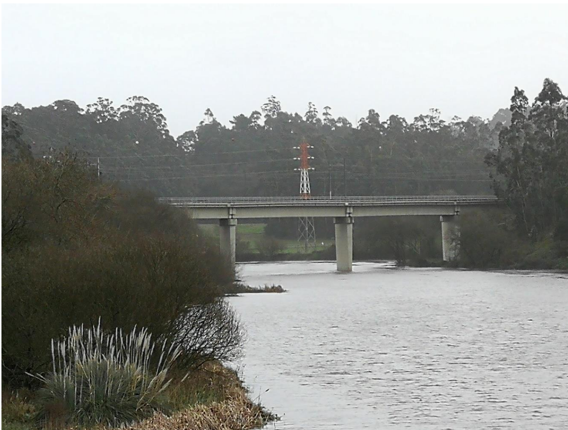
Figura 12 – Ponte do metro em Vila do Conde
