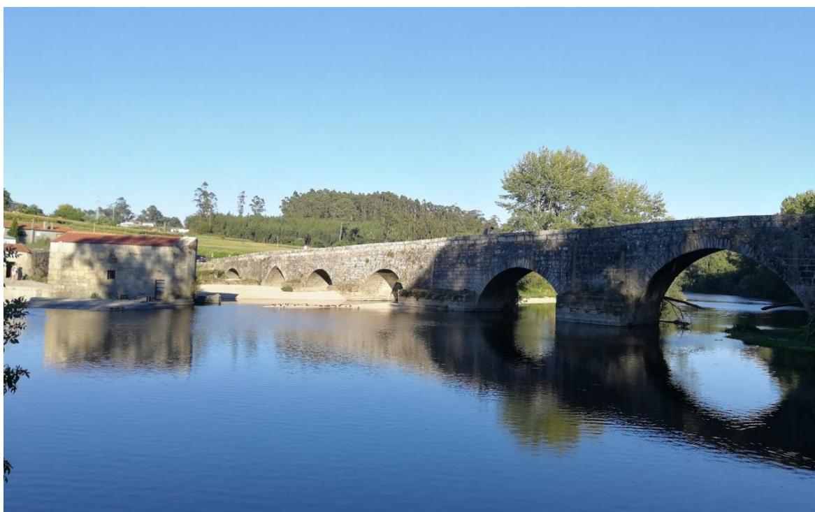
Figura 10 – Ponte D. Zameiro
