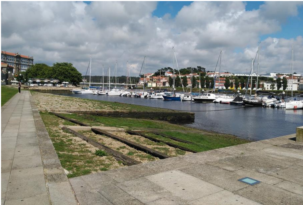
Figura 15 – Cais das lavadeiras, Cais da Alfândega e marina de Vila do Conde.
