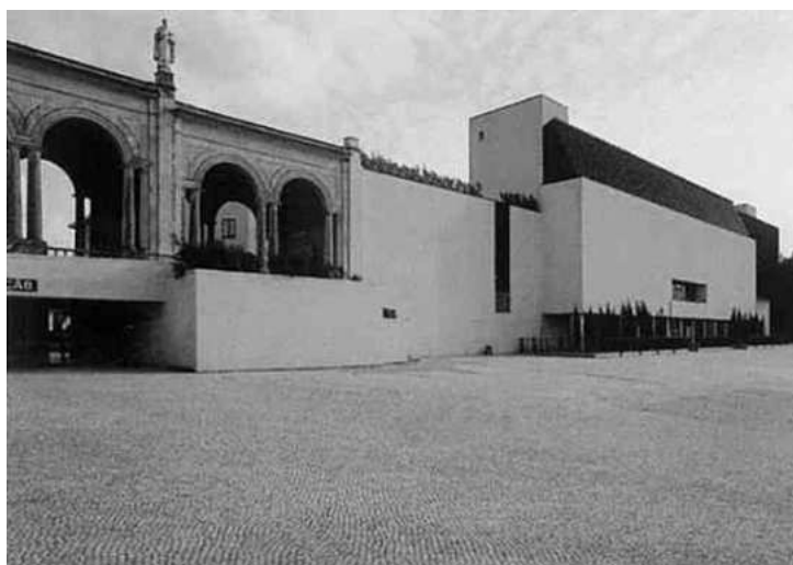
Figura 22: Casa Nossa Senhora do Carmo, 1983
