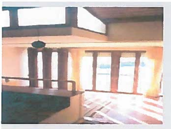
Figura 1.3-7 Tubos em fibra de vidro instalados juntos aos vãos envidraçados.
