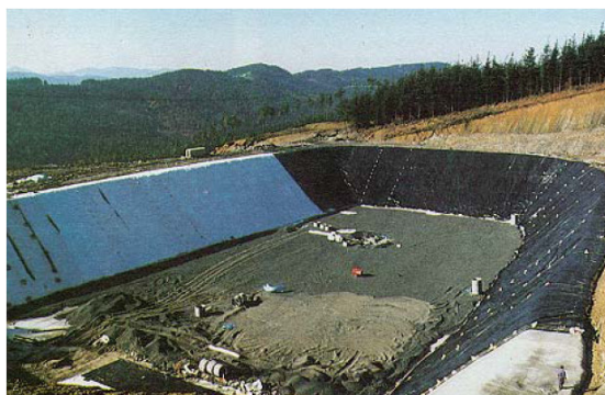
Figura II.5. Vista de uma alvéolo de deposição de resíduos sólidos de um Aterro (Russo, 2003).
