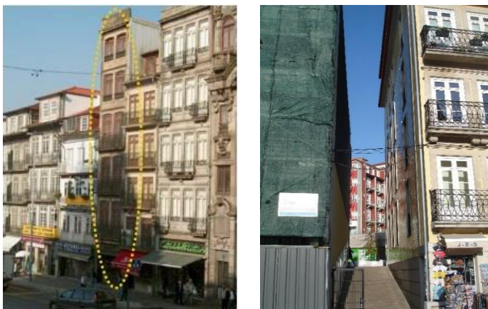
Figura 47- Edifício demolido para acesso Figura 48- Acesso derivado da demolição
