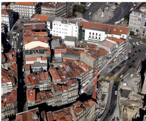
Figura 18- Estado do Quarteirão antes da intervenção
