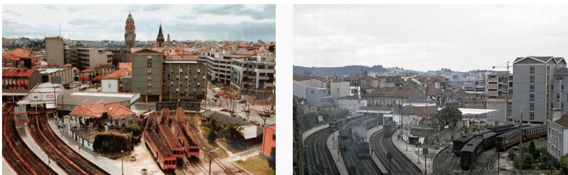
Figura 30 e 31- Antiga Estação de Comboios da Trindade
