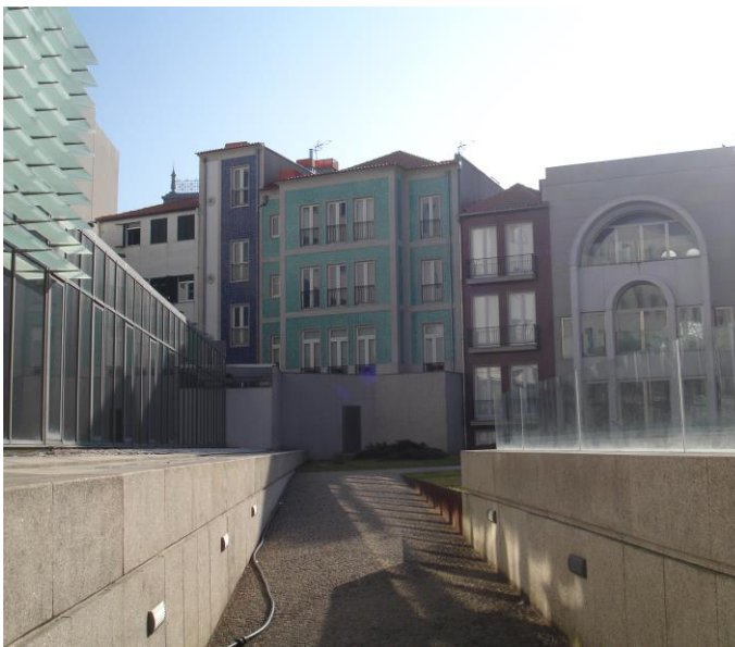
Figura 7 – Praça no Interior de Quarteirão
