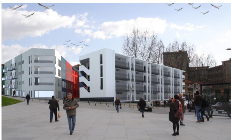
Figura 38- Entrada da Passagem Rua da Trindade
