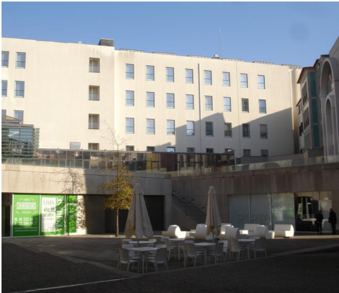
Figura 5 – Praça no Interior de Quarteirão
