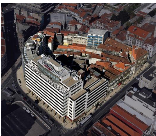
Figura 26- Estado do Quarteirão antes da Intervenção
