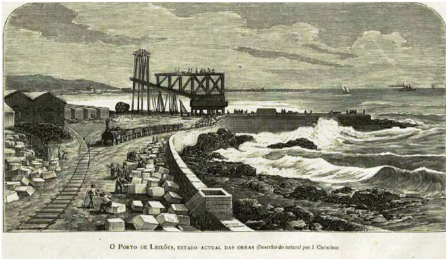
Figura 11. Porto de Leixões em construção. Fonte: O Ocidente , ano 8, 1885, n.º 251, p. 273.
