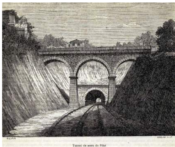
Figura 4. Abertura de túnel ferroviário.
