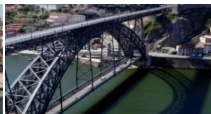
Fig. 6 Ponte Luiz I
