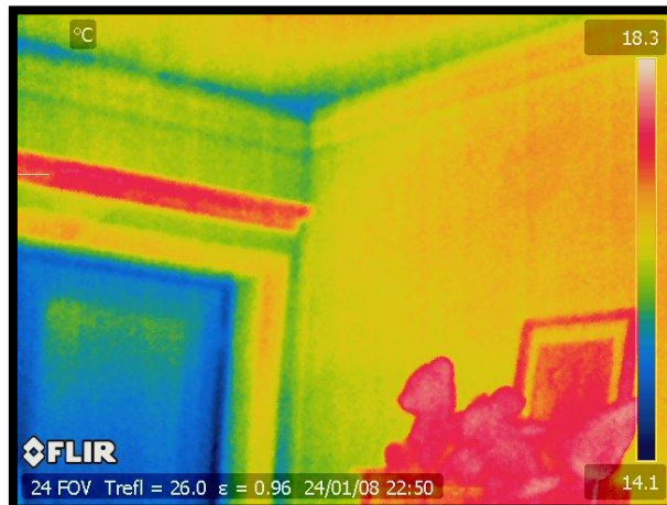
Figura 3.3 - Fugas de Ar pelas Janelas; fonte: Imagens cedidas pelo Eng o . António Cardoso
