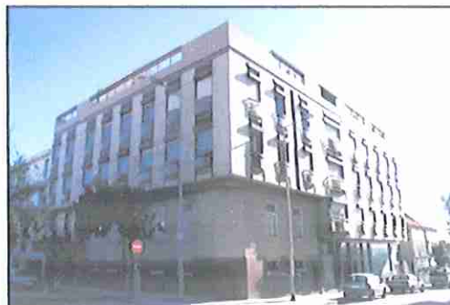
Foto 26 – Panorâmica do Edifício da Rua Hintze Ribeiro.
