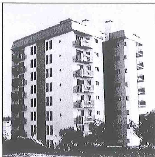
Fig. 8 – Habitação Social de Olivais Norte, de Teotónio Pereira. Fonte – http://www-ext.lnec.pt/LNEC/DED/NA/arq/ntp/prjobr/prjobr.htm .
