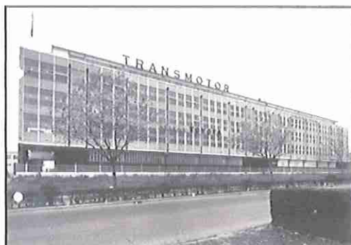
Foto 22 – Alçado principal do Edifício de Delfim Ferreira.
