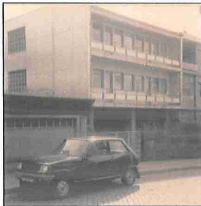
Foto 19 - Alçado principal da Moradia de Abílio de Sousa.
