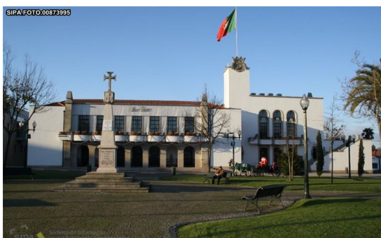
Fig. 37: Edifício Paços do Concelho e Tribunal.
