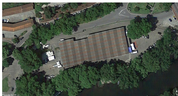
Fig. 8: Vista aérea do edifício da fig.7. Fonte: Google Earth, 2019.
