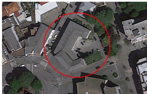
Fig. 36: Vista aérea do edifício da fig.35.
