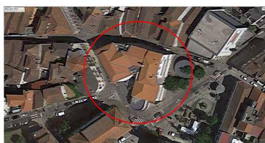
Fig. 44: Vista aérea do edifício da fig.43.
