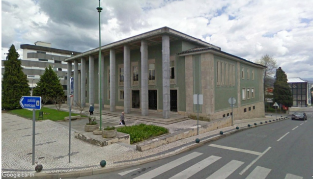
Fig. 29: Edifício do Tribunal do Marco de Canaveses.
