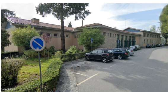
Fig. 9: Edifício do Tribunal de Amarante. Fonte: Google Earth, 2019.
