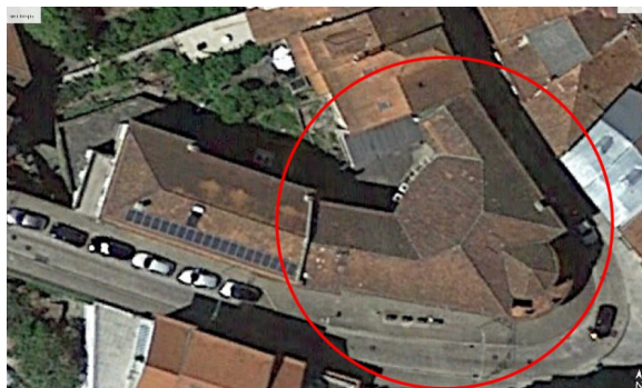
Fig. 2: Vista aérea do edifício da fig.1.
