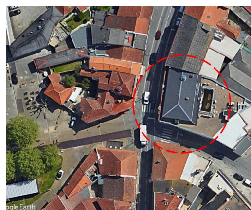
Fig. 50: Vista aérea do edifício a modificar (Paços do Concelho, à data do projeto).
