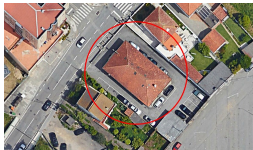
Fig. 24: Vista aérea do edifício da fig.23.
