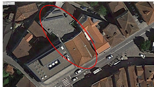
Fig. 48: Vista aérea do edifício da fig.47.
