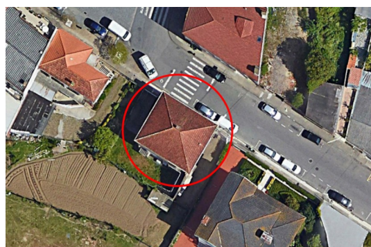
Fig. 52: Vista aérea do edifício da fig.49.
