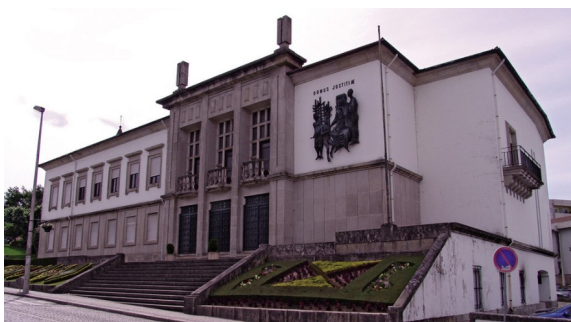
Fig. 27: Edifício do Tribunal de Lousada.
