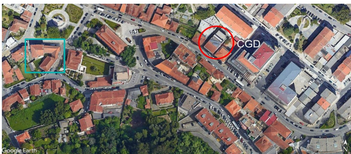
Fig. 57: Vista aérea. Implantação dos edifícios na envolvente. Gondomar.
