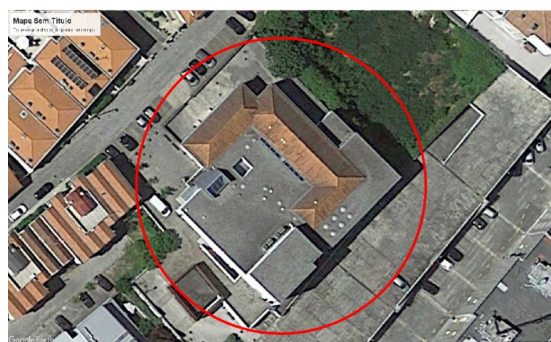
Fig. 4: Vista aérea do edifício da fig.3.
