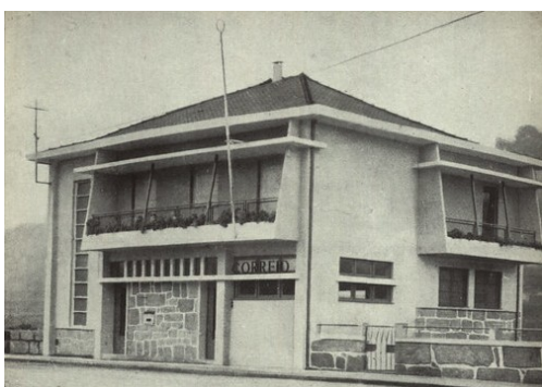
Fig. 51: Estação dos CTT de Valongo.
