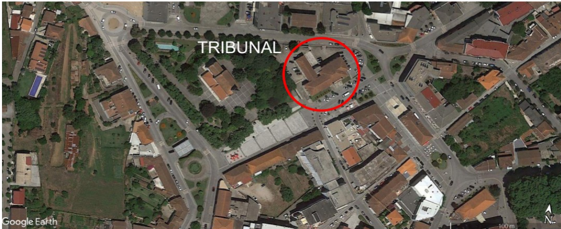
Fig. 58: Vista aérea. Implantação dos edifícios na envolvente. Lousada.
