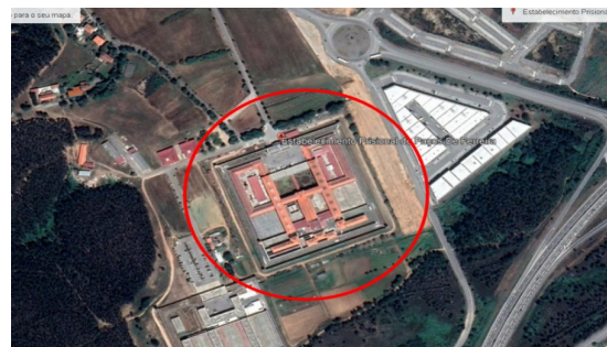
Fig. 32: Vista aérea do edifício da fig.31.
