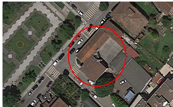
Fig. 20: Vista aérea do edifício da fig.19.
