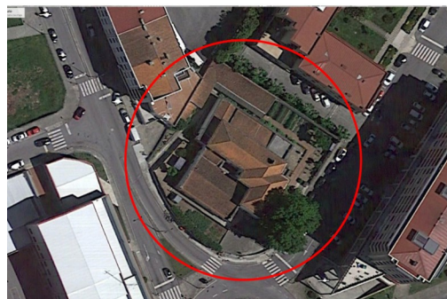
Fig. 42: Vista aérea do edifício da fig.41.
