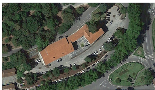
Fig. 10: Vista aérea do edifício da fig.9. Fonte: Google Earth, 2019.
