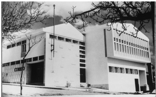
Fig. 19: Estação dos CTT de Felgueiras.
