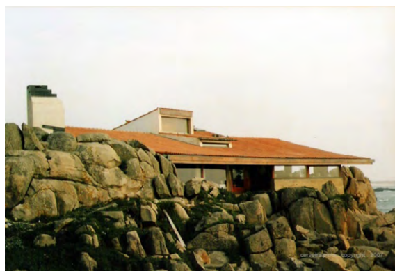
Figura 11. Casa de Chá da Boa Nova (1958-1963). Leça da Palmeira, Matosinhos. Arq. Álvaro Siza Vieira. Fonte: foto do autor.
