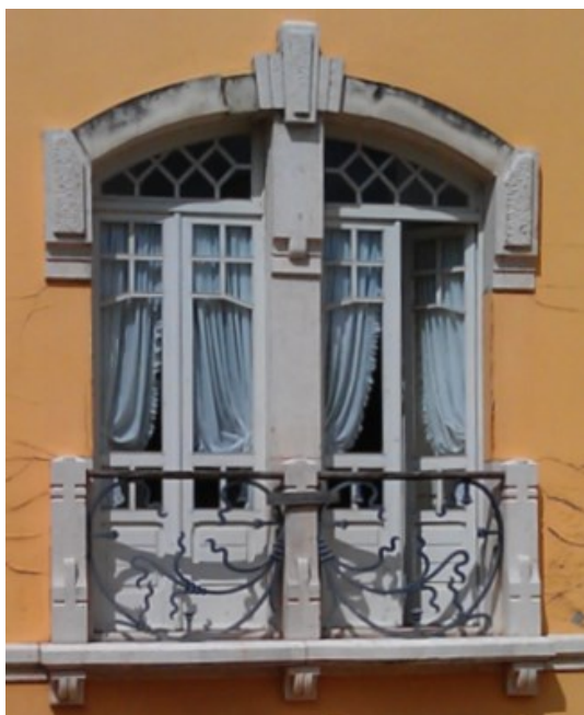
Fig. 81 - Pormenor de janela bifora
