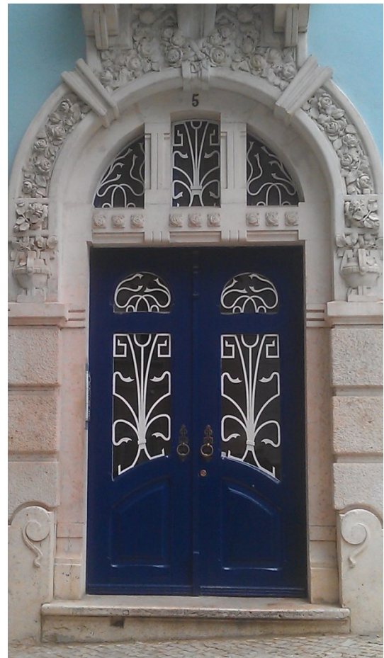
Fig. 43 - Portal do edifício de Estephania Macieira
