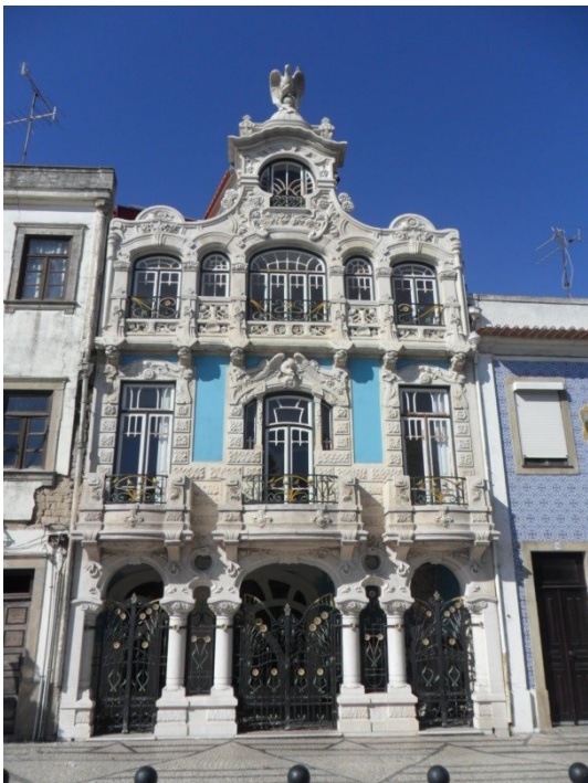
Fig. 70 - Fachada da casa de Belmonte Pessoa
