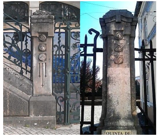
Fig. 62 - Pilaretes: Casas de F. Simões (esq.) e de J. Pedrosa d'Agostinha (dir.)
