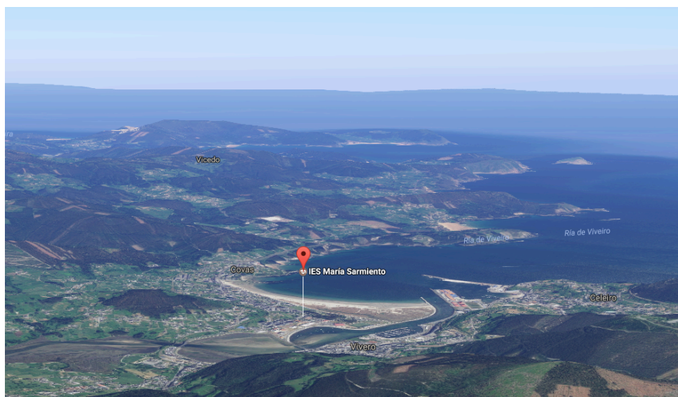
Fig.60. Vista aérea del IES .María Sarmiento. Fuente: Google Maps.
