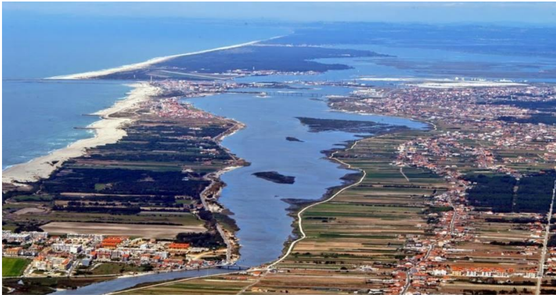
Fig. 31 - Vista aérea do Município de Ílhavo no limite sul, confrontando com o município de Vagos
