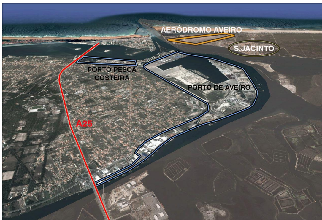
Fig. 32 - Vista da Gafanha da Nazaré e sua relação com as principais infraestruturas.
