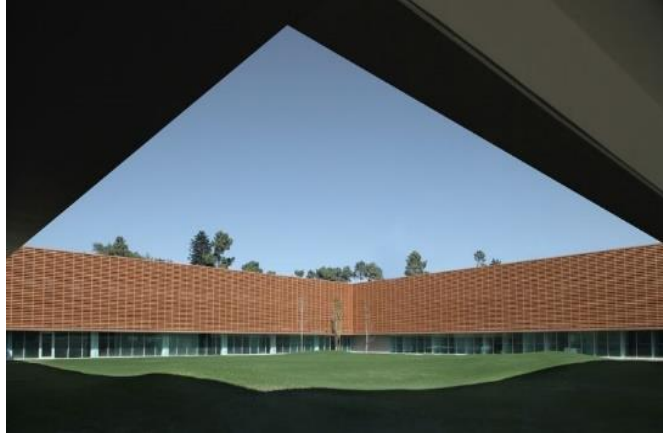
Figura 36: Fachada ventilada em madeira no hospital da Guarda - Jular madeiras (Jular, s.d.) - https://www.aripa.pt/uploads/mod_projectos/58/507_b.jpg
