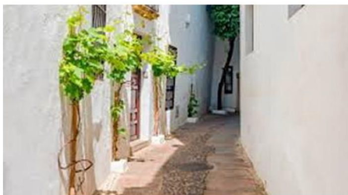
Figura 63: Exemplo de aplicação de tinta natural de cal em fachada - Gestor orçamentos Arquimedes da Cype 2025
