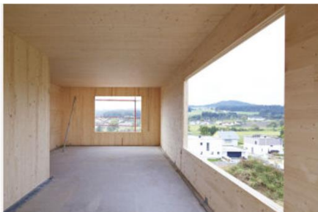
Figura 89: Modelo de aplicação de parede estrutural de painel de madeira lamelada colada cruzada CLT - Gestor de orçamentos Arquimedes da Cype 2025
