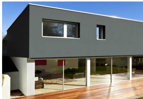
Figura 50: Fachada pintada com tinta termo refletora - https://tintasepintura.pt/wp-content/uploads/2020/04/Cin-K-Sistema-ETICS.png
