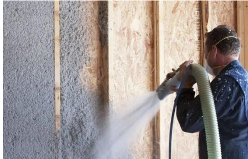
Figura 61: Aplicação de fibra celulose como isolamento de parede - https://m-strana.ru/upload/resize_cache/user_myself/article/67612/sprint.editor/bfc/830_830_1/qg9d6dix57rjr4xcl1890f8redzc8gcl.webp
