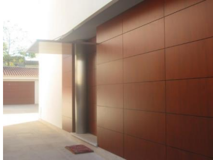
Figura 29: Componentes de placas de fenólicos - Dossier Técnico-Económico – Fachadas Ventiladas, 2006)
