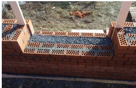
Figura 54: Colocação da argila expandida em parede dupla - https://ihousetop.decorexpro.com/wp-content/uploads/2020/01/1479047906_stena-uteplennaya-keramzitom.jpg
