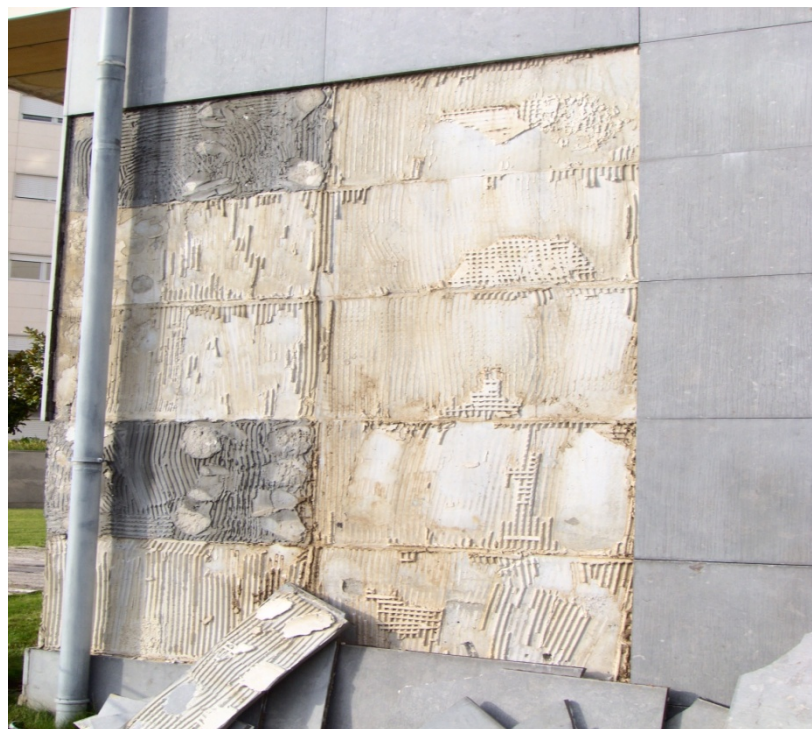
Figura 28 – Descolamentos pontuais mas extensos, sem empolamento aparente [Arquivo Pessoal]
