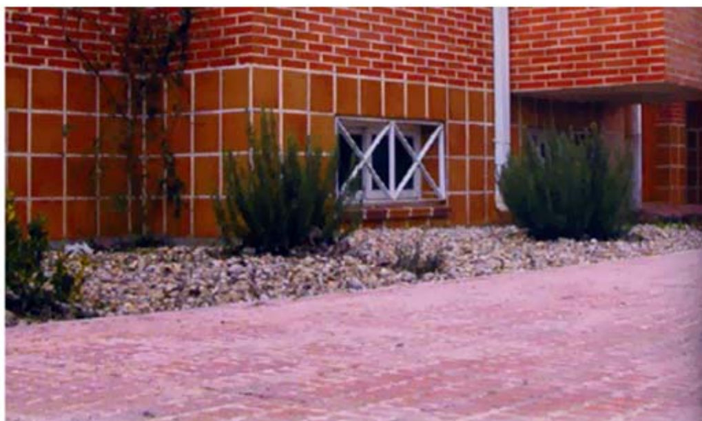
Figura 24 - Utilização de revestimentos cerâmicos numa fachada e num pavimento [5]
