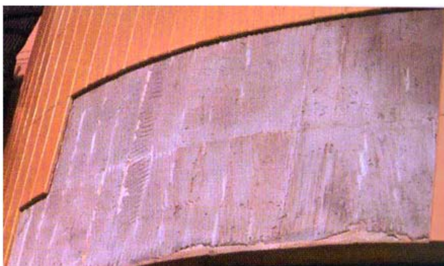
Figura 30 - Descolamento localizado, em plano curvo [1]
