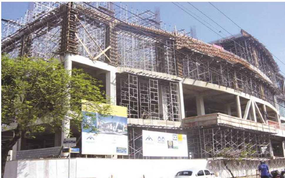
Figura 6 - Exemplo de uma obra actual [Arquivo Pessoal]
