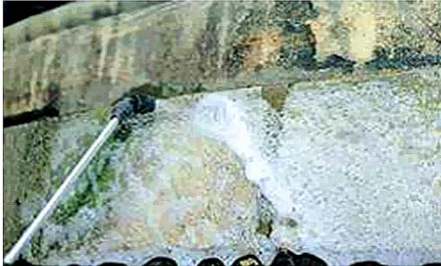
Figura 50 - Aplicação de hipoclorito de sódio [5]
