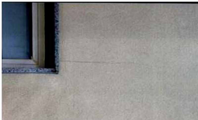
Figura 13 - Desenvolvimento de fenda a partir do vão aberto de uma janela [7]
