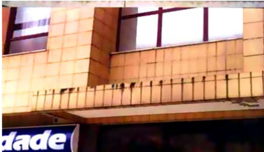
48 - Formação de descolorações por acumulação de sujidade [7]
