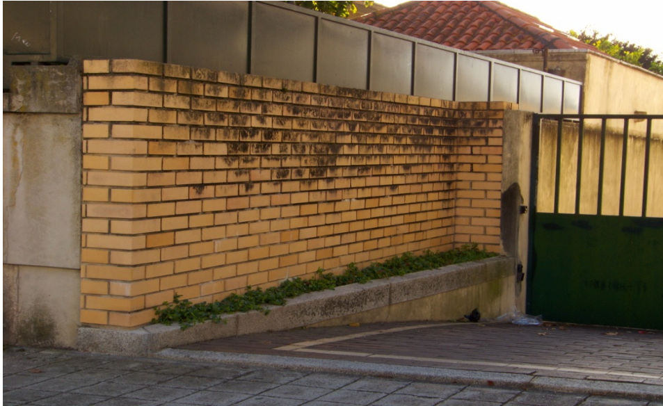
Figura 17 - Manchas de sujidade e presença de micro organismos [Arquivo Pessoal]
