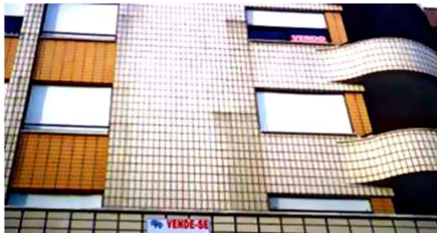
Figura 49 - Outro exemplo de descolorações [7]
