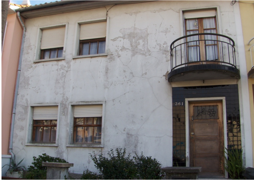
Figura 14 – Desenvolvimento de várias fendas a partir de vãos em casa antiga [Arquivo Pessoal]
