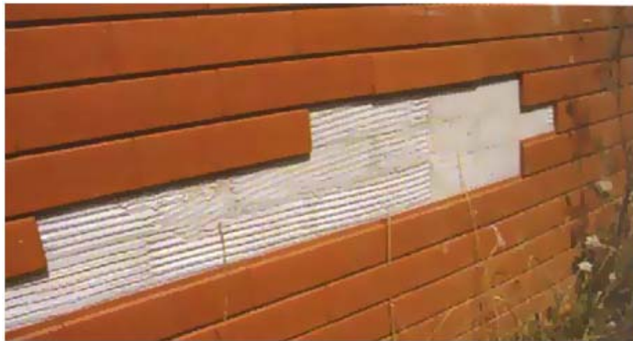
Figura 32 - Diferentes texturas do suporte do suporte de colagem e sinais de colagem incompleta [1]
