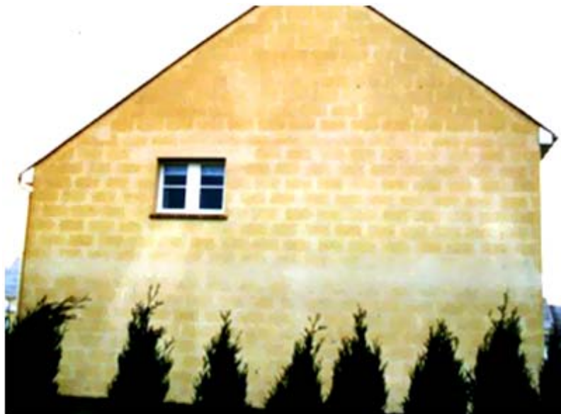
Figura 16 - Cor não uniforme [7]
