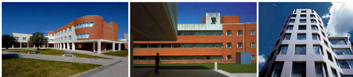
Figura 11. Departamento de Engenharia Cerâmica e do Vidro (1988), Departamento de Química (1990), Aveiro; Banco Fonsecas & Burnay (1990), Porto. Fontes: www.litoral magazine.com , 2016; Rui Morais de Sousa, 2000; Luís Ferreira Alves, 2013.
