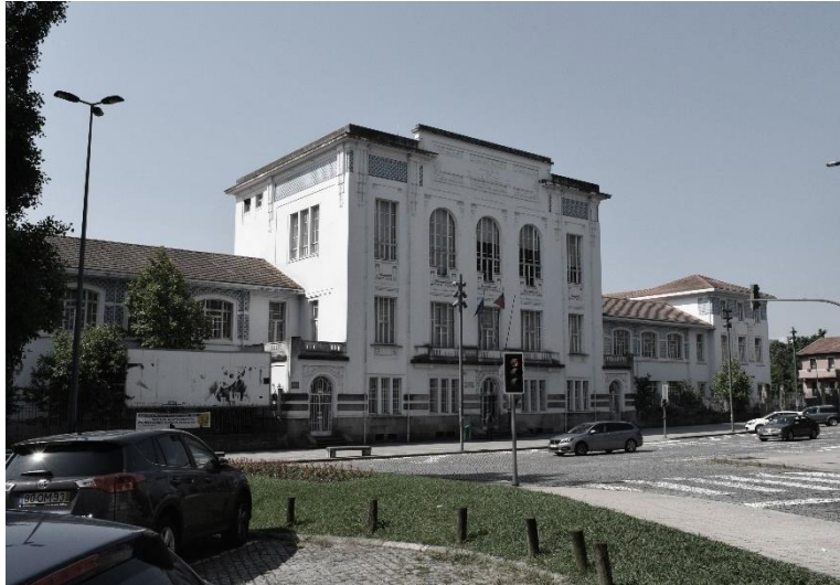
Figura 32 - Liceu Rodrigues de Freitas fonte: autor
