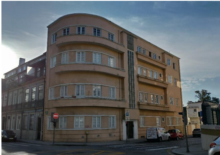
Figura 47 - Edifício do gaveto entre a R. Augusto Luso e Av. da Boavista fonte: autor
