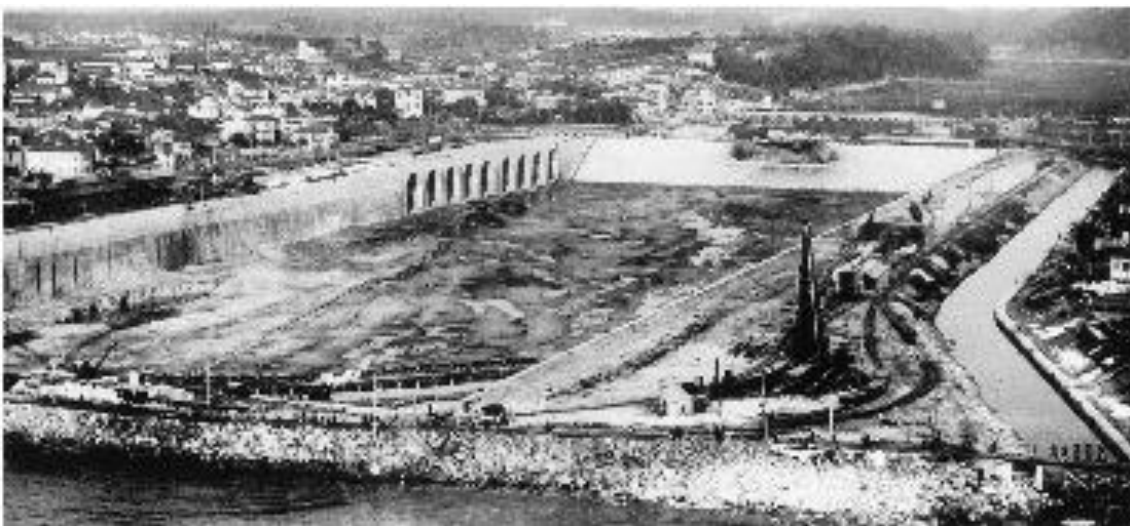
Figura 11 - Construção do Porto de Leixões
