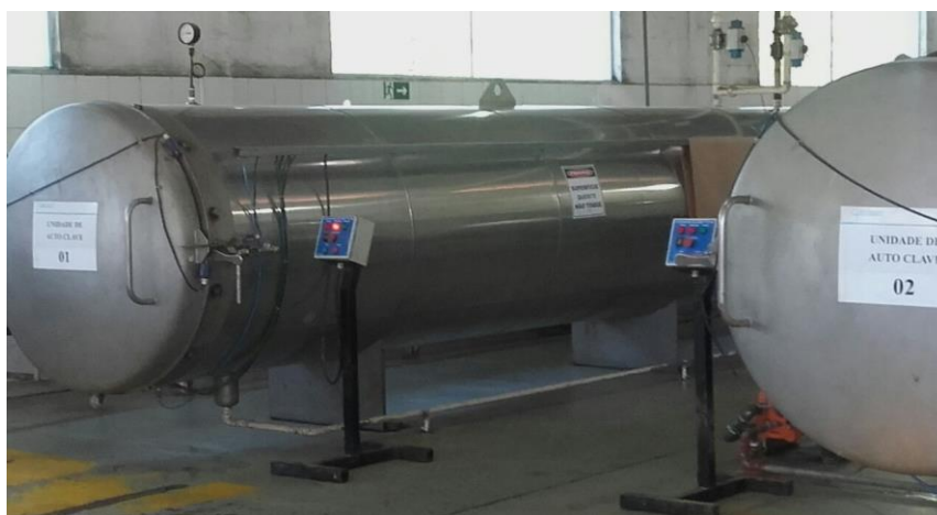
Figura 20 - Equipamento de autoclave utilizado para o tratamento dos resíduos de serviços de saúde, do município de Santos.
