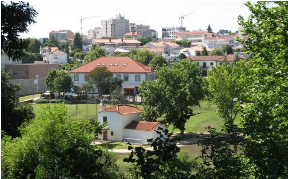
Figura 7.31 – Vista do Solar dos Condes de Fijó e zona de parque após a reabilitação
