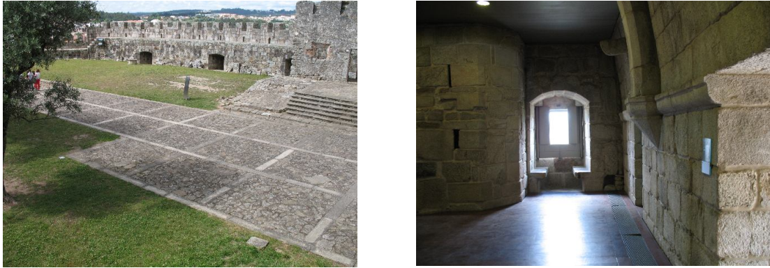
Figura 7.42 – Remodelação efectuada no exterior e interior do castelo de Santa Maria da Feira.
