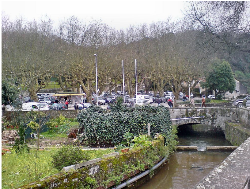
Figura 7.56 – Vista do rio Cáster e da praça do Rossio previamente às obras de reabilitação.
