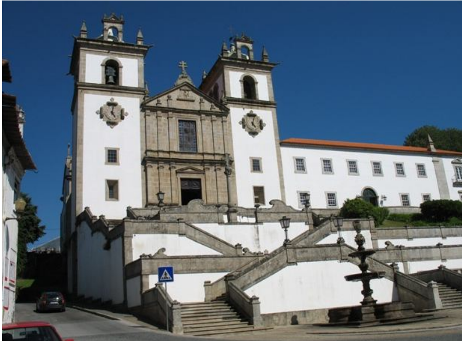
Figura 7.25 – Vista da Igreja e do convento dos Lóios após a reabilitação.
