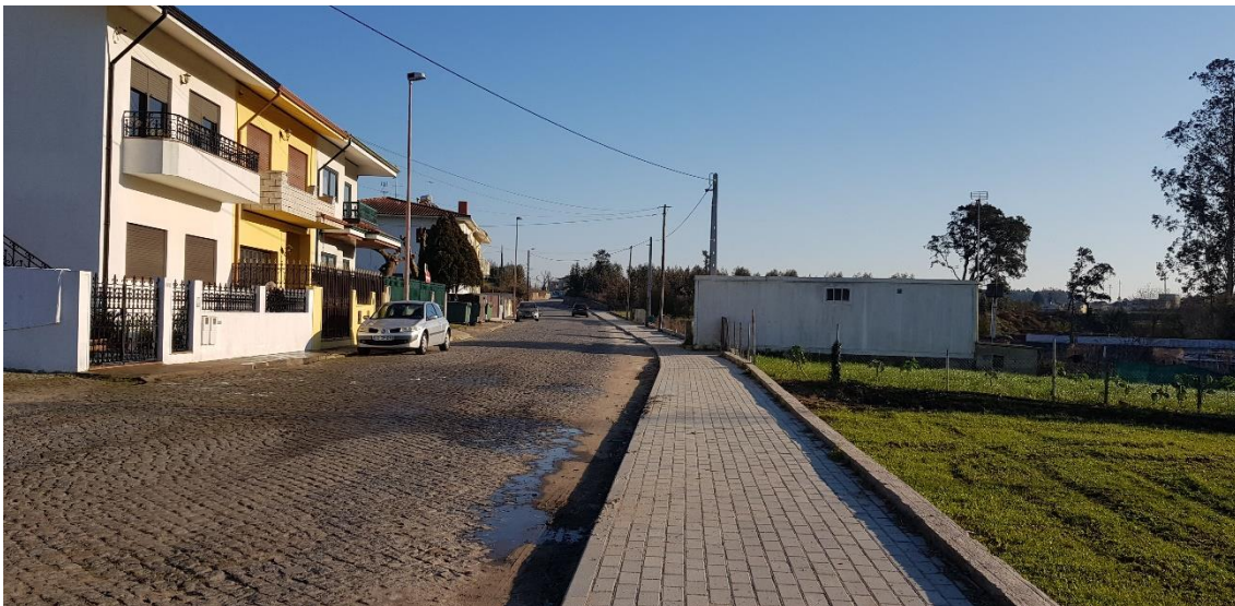
F.AN.26: Vista para a entrada da Urbanização do Carregal pela Rua da Venda da Velha Fonte: Elaboração própria
