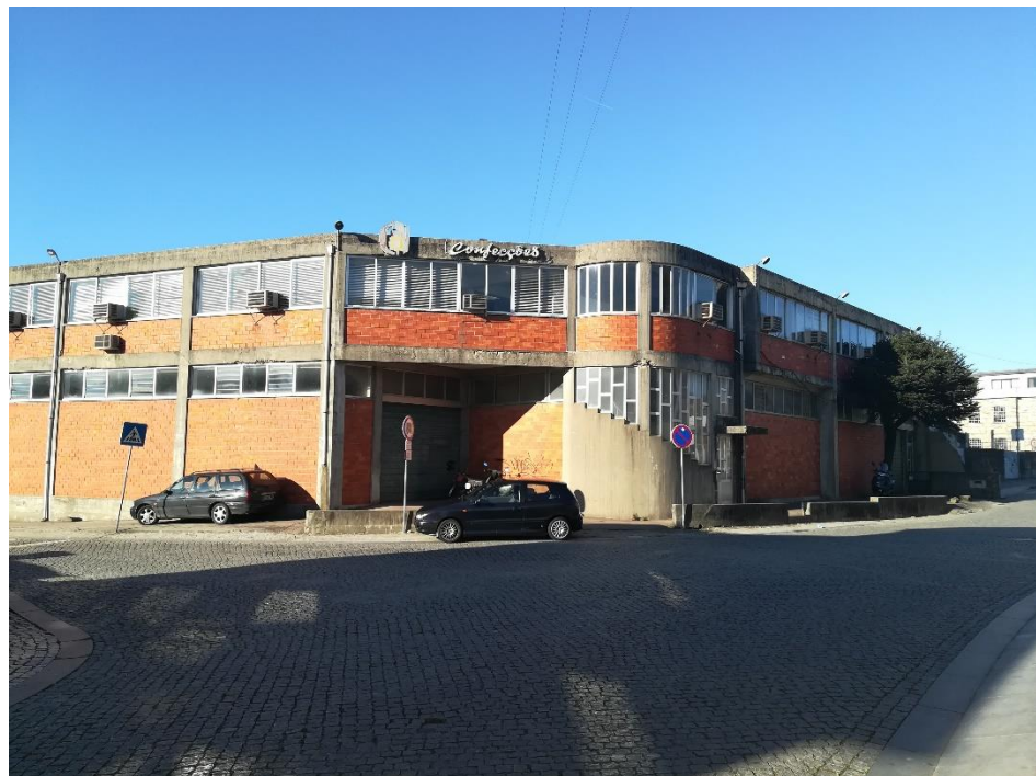
F.AN.32: Vista para antiga indústria têxtil na Rua da Mota Fonte: Elaboração própria
