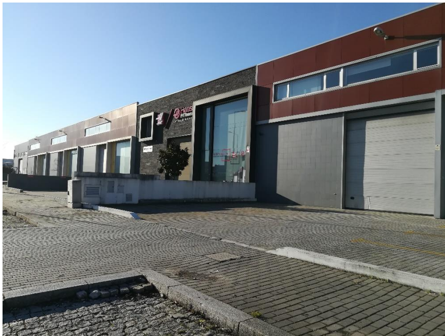
F.AN.23: Vista para o espaço público da Zona Industrial Fonte: Elaboração própria
