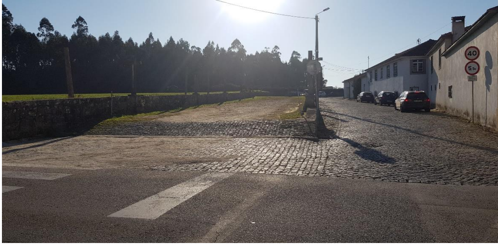
F.AN.12: Vista para o Adro e a Travessa da Igreja Fonte: Elaboração própria
