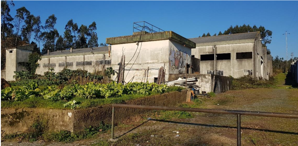
F.AN.33: Vista para antiga indústria, pela Rua da Venda da Velha Fonte: Elaboração própria
