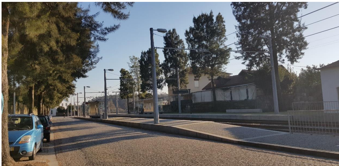
F.AN.17: Vista para a estação de Metro “Vilar do Pinheiro”
