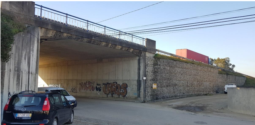
F.AN.15: Vista para viaduto da A28 pela Rua de Aveleda Fonte: Elaboração própria
