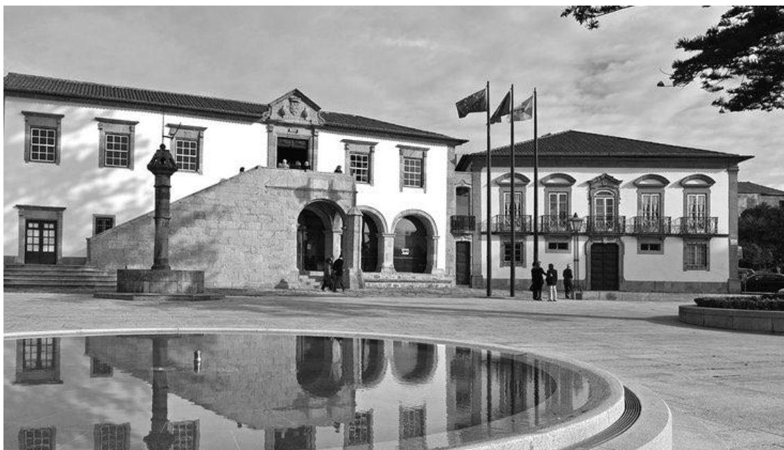
F.AP.06: Edifício Paços do Concelho Fonte: Câmara Municipal de Vila do Conde
