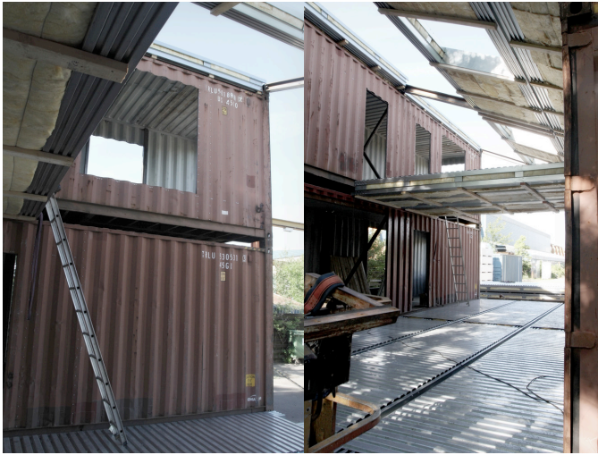
Fig. 3.12 Interior en construcción
