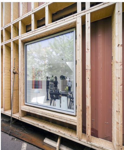
Fig. 3.13 Fachada en construcción
